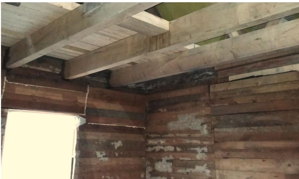
Foto 12 Pööningukorruse kahjustatud talade väljavahetamine, prusside otsad immutatud putukate ja seenkahjustuste vastu.
