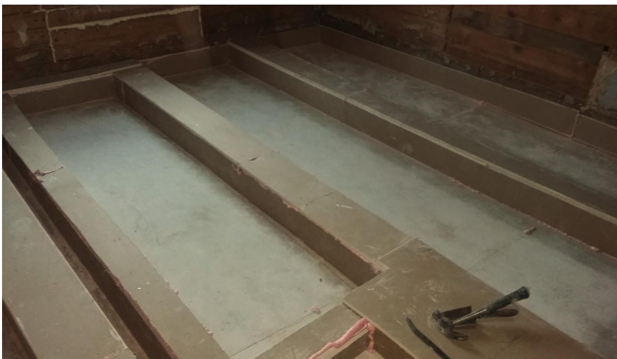
Foto 13 Pealt olemasolevate talade katmine tuletõkkekipsiga, vuugid täidetakse tuletõkkevahuga.
