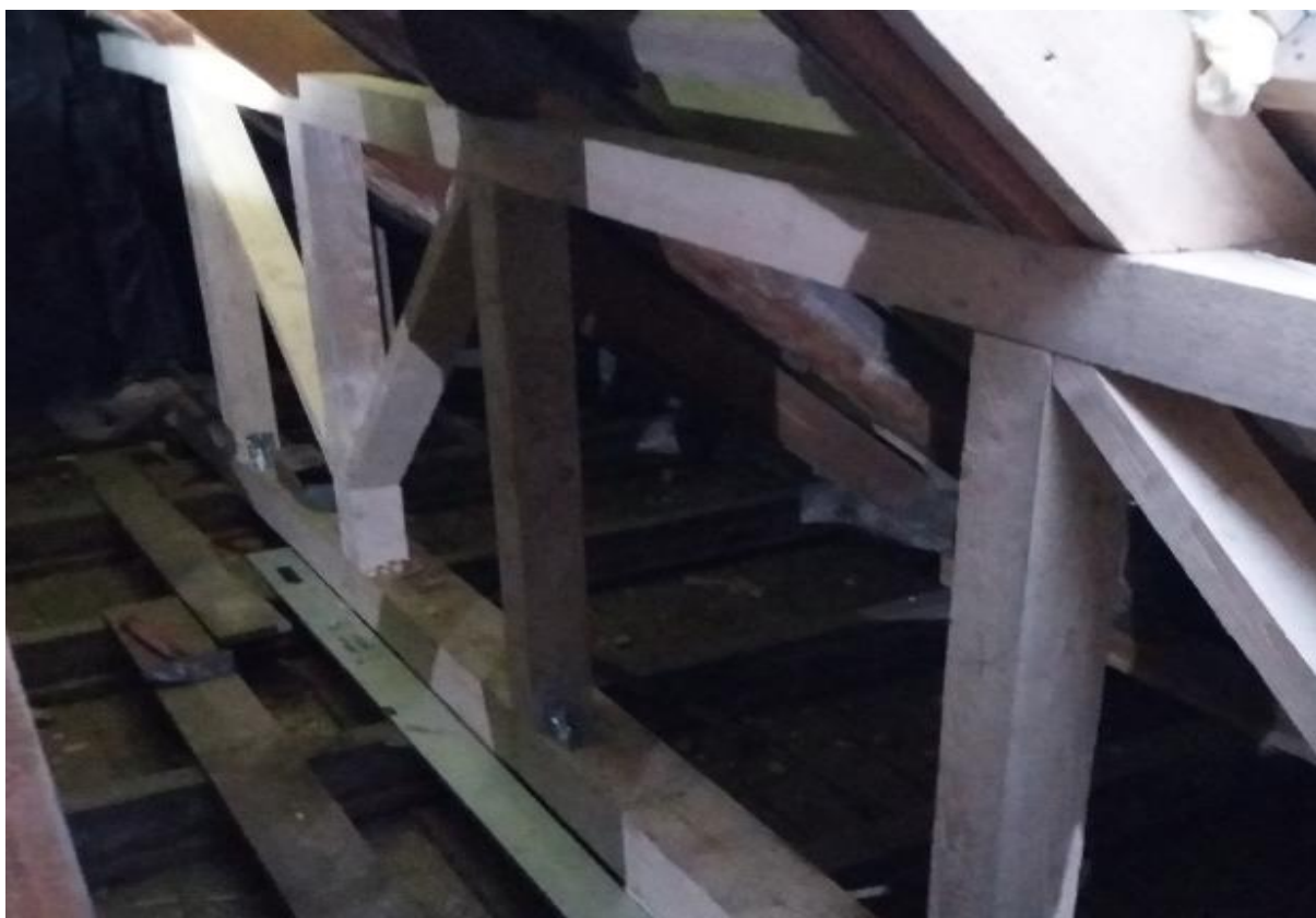
Foto 18 Täiendavad konstruktsioonid katuse sarikatele.
