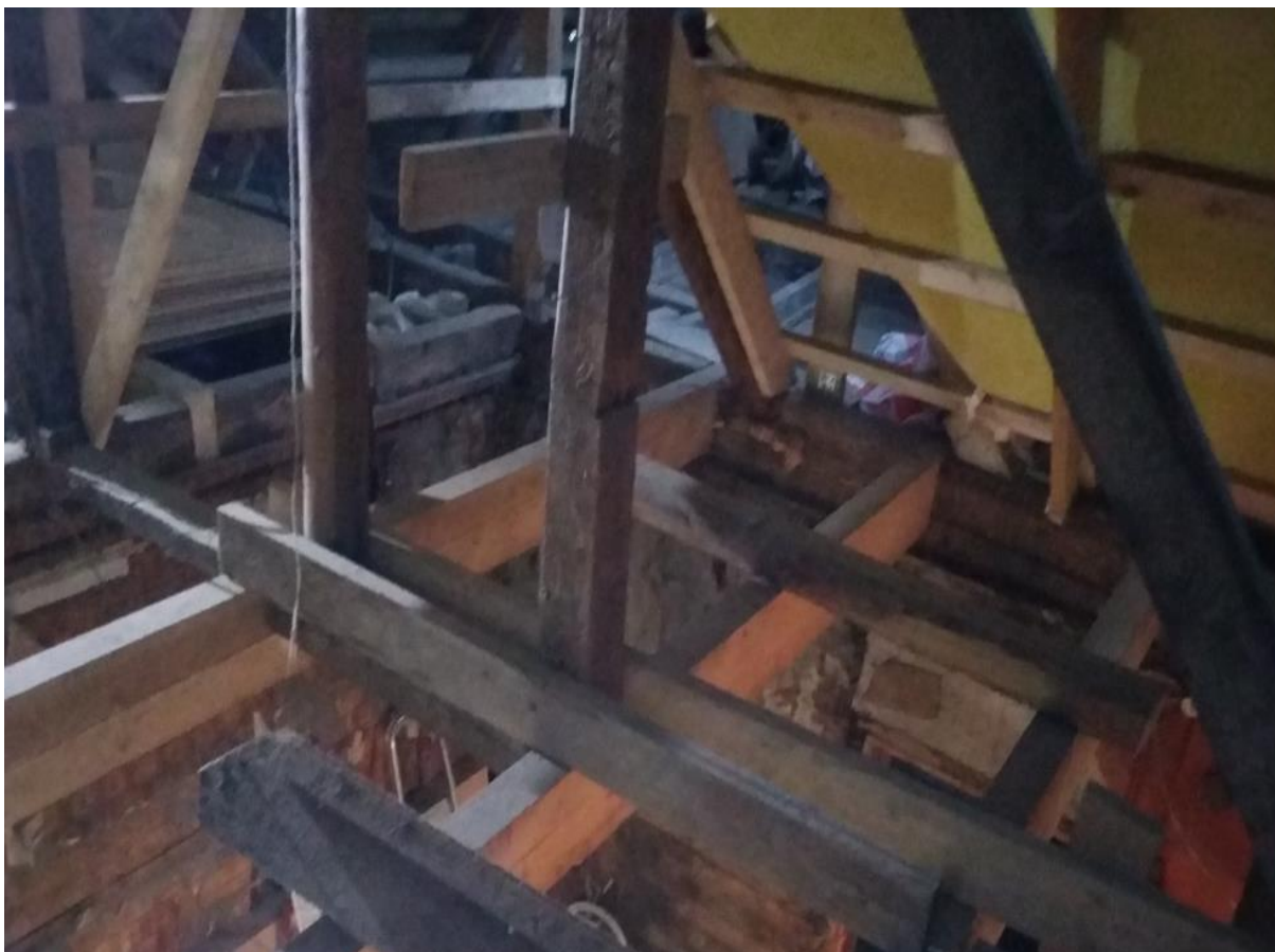
Foto 17 Osaliselt tuli välja vahetada põõningukorruse vahelaetalad, millele toetuvad katust kandvad turvikud
