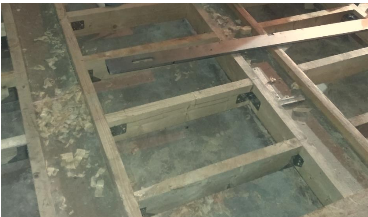
Foto 14 Põranda konstruktsiooni tugevdamine lisa prussidega.
