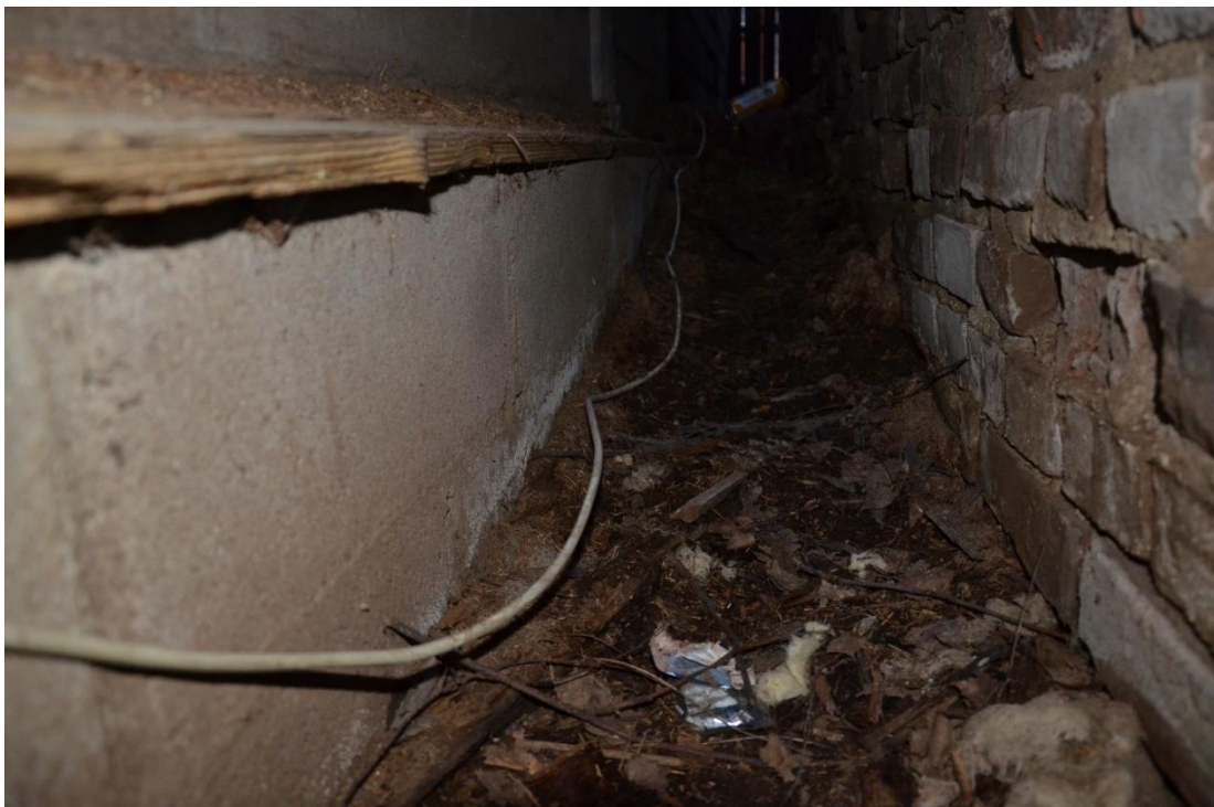
21 Vaade Filosoofi 5 ja 7 majade vahelisele alale. Vasakul näha Fibo plokkidest uut vundamenti ja vana veelauda. Paremäl on Filosoofi 7 tulemüür. Kõrgem sodikuhi on katusealuse korruse terrassi all.
