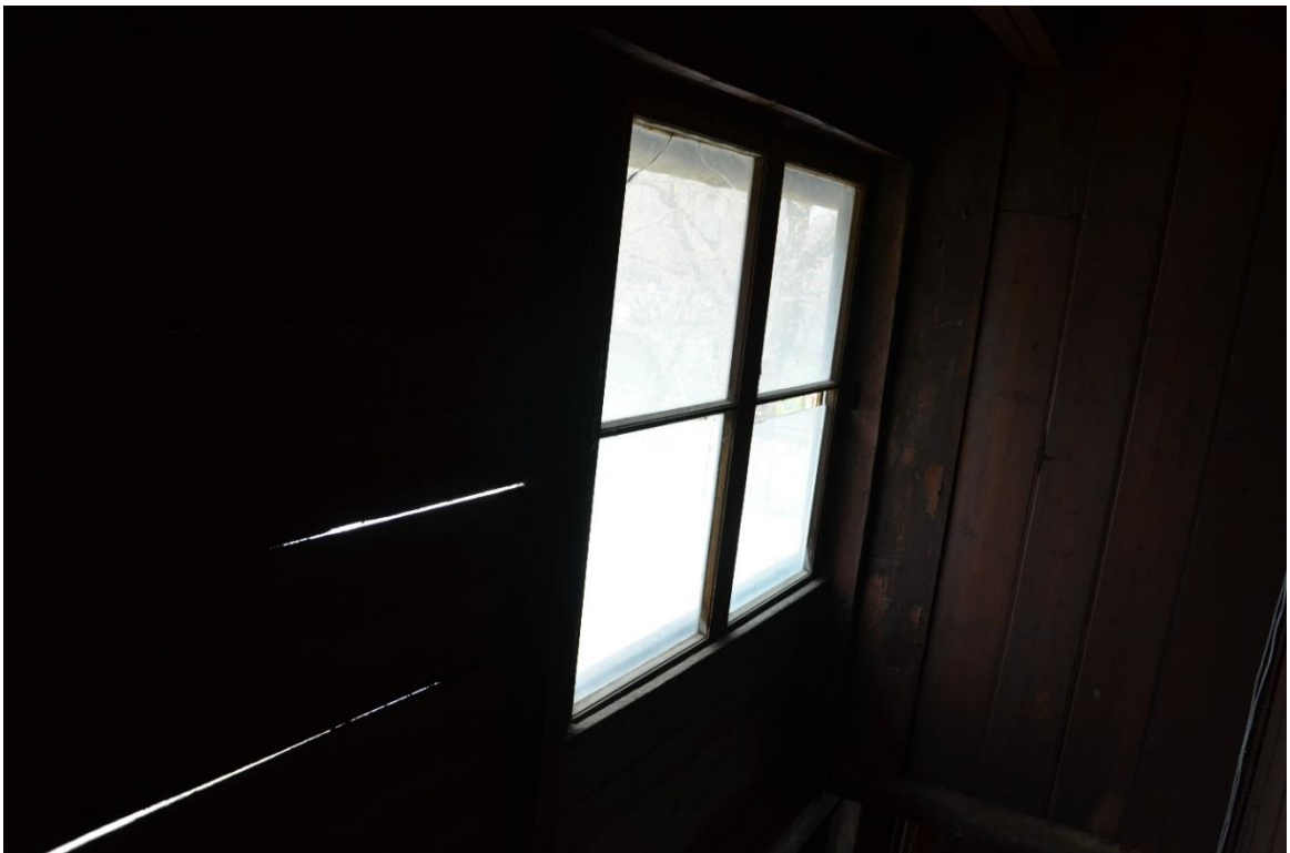
36 Aken maja põhjaseinas. Tõenäoliselt tegemist ühe originaalakna alumise osaga. Vasakul näha, kuidas tihedalt trepikoja sõrestikule löödud välilaudis.
