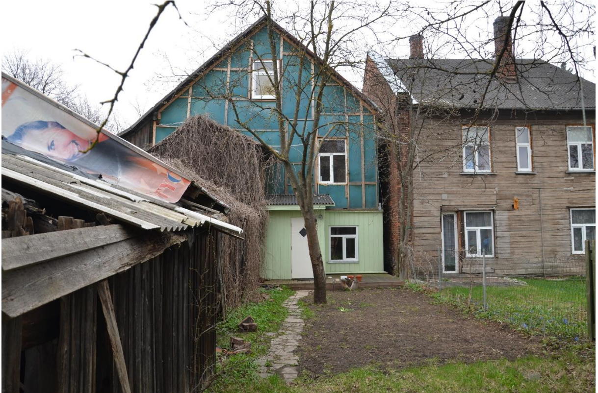
15 Hoovipoolne vaade. Vasakul lagunenud kuurid, maja küljes metsviinapuuvätide all on väline trepikoda. Lisaks näha terrassi, välivoodrit ja seina jäänud tuuletõkkeplaati. Kõik hoovipoolsed aknad on majaga sobimatuse plastikust. Maas on näha plaatidest teed, aias kahte pihlakat. Ja tulevast muruplatsi.
