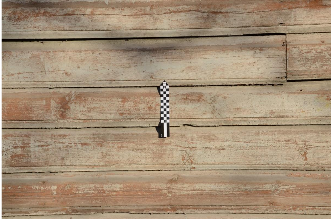
27 Laudvooder maja põhjaküljel. Värviskeem on sama, mis tänavapoolsel fassaadil, kuid laudise laius varieerub 15 ja 20 cm vahel. Laudiseprofiil, seevastu, on ühtlane.
