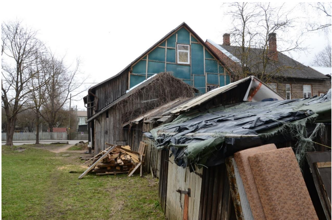
18 Vaade majale, kuuride rivile ja maja külge ehitatud trepikojale hoovi poolt. Esiplaanil paremal näha garaažkuuri, millele toetub kolm kušetti ja kaks välisust, kaugemal ehituspraht. Maja esialgse mahu ja juurdeehituse piir on jälgitav tuuletõkkeplaadi ja püstlaudise vaheldumisega.
