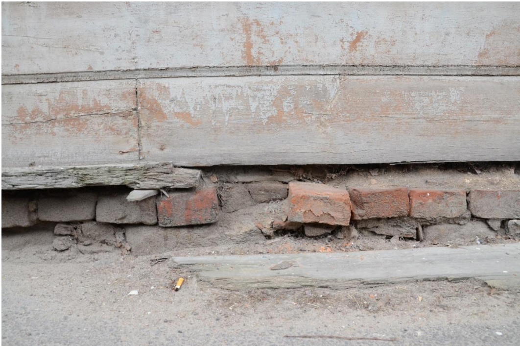
19 Vundament maja tänavapoolsel küljel. Näha pehkinud veelauda, mis on veel omal kohal, ja tänavale vajunud veelaid. Samuti näha tellisvooder.
