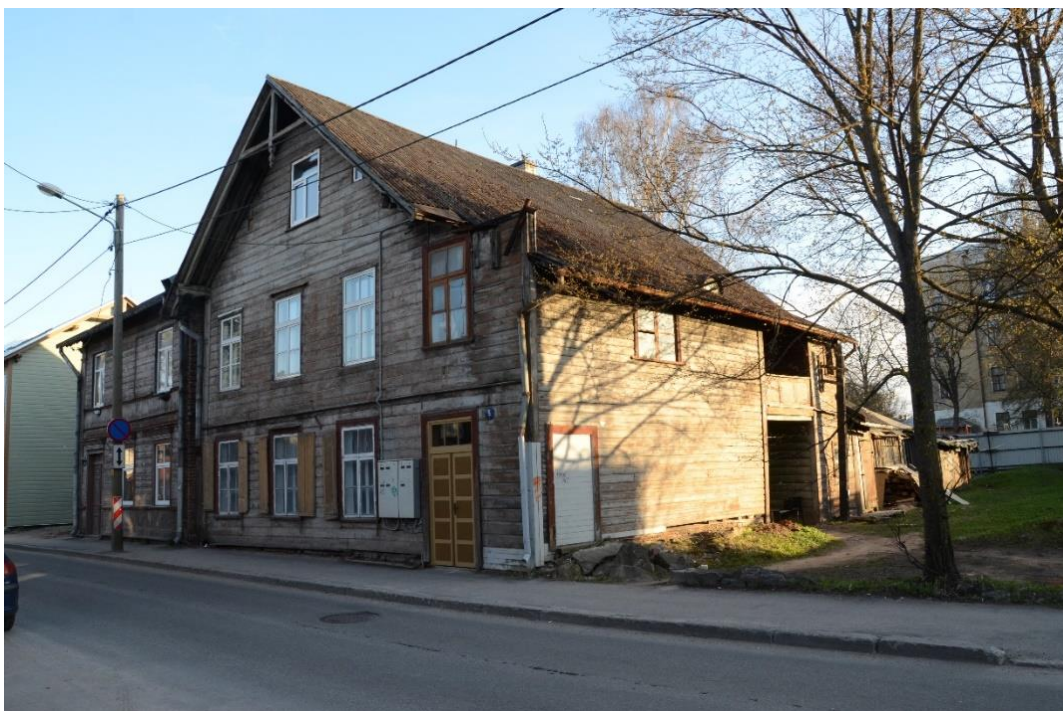
13 Vaade majale teiselt poolt Filosoofi tänavat. Näha tänavapoolne fassaad elektrikilbiga ja põhjakülg, eterniitkatus, kauguses paistavad ka kuurid ning plekkaed.
