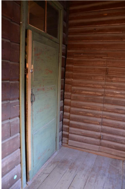
41 Vasakul rohekas uks, mis viib teise korruse rõdult hoone esialgsesse mahtu, väiksesse trepikotta. Ukse kohal on kaheks jaotatud valgimik. Vasakul on näha ka katkestust algses voodrilauas, mis võib viidata sellele, et uks on tehtud kunagise akna koha peale. Ukse kahe ruuduga valgimik võib olla ka endise akna ülemise osa taaskasutus. Paremalt on näha ust, mis viib teise korruse endisesse kuivkäimlasse, mis hetkel on kasutusel panipaigana.
