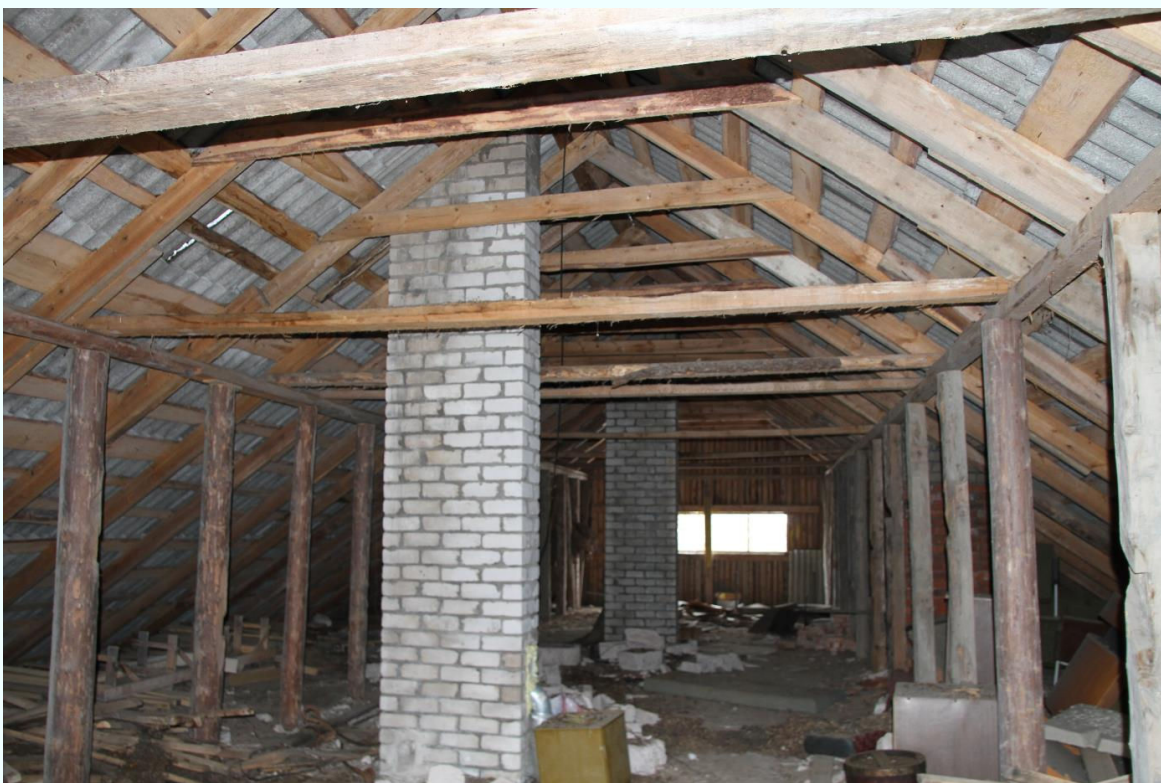
Foto 16. Pööning ja katusekonstruktsioonid.
