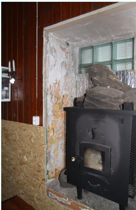
Foto 11. Kontori akna avasse paigaldatud tulekolle
