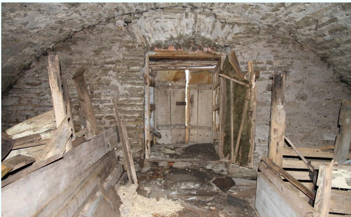
Foto 25. Põhjapoolse keldri sissepääs.
