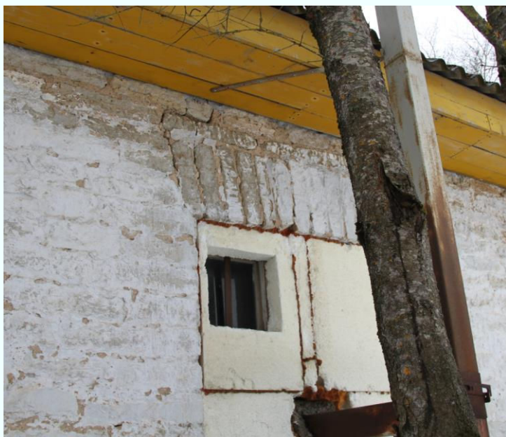
Foto 6. Aknakaare vajumine sisehoov fassaadis.
