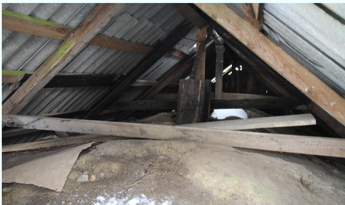
Foto 26. Põhjapoolse keldri katusekonstruktsioon.
