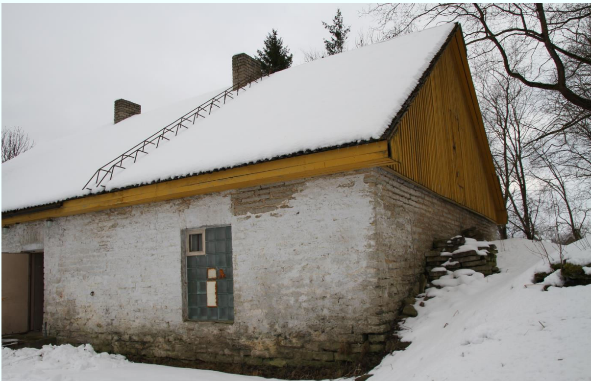
Foto 5. Keldri liitumine hoonega.
