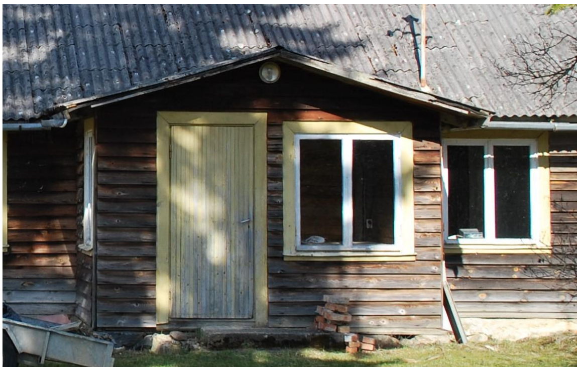
Joonis 14. Tuulekoda, vaade lõunast.
