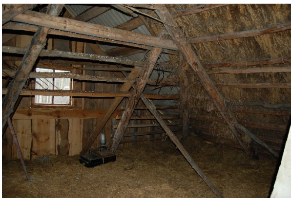
20. katuse kandekonstruktsioon
