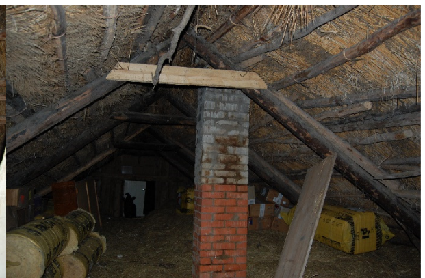
21. katuse kandekonstruktsioon
