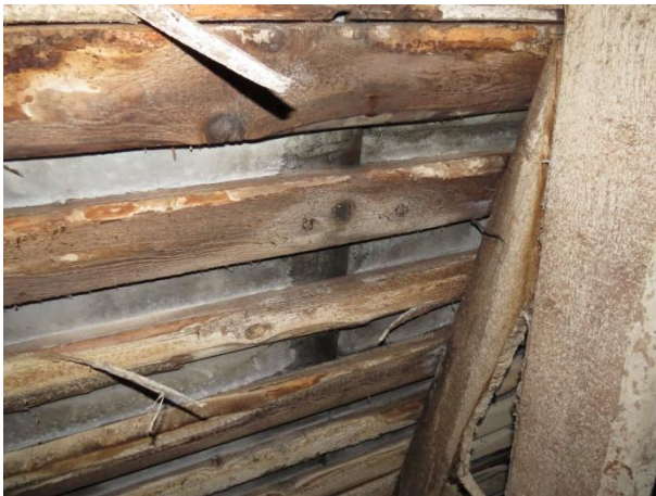
Fotod 28 ja 29. Katuse valtside vaheline läbijooks peale vihma.
