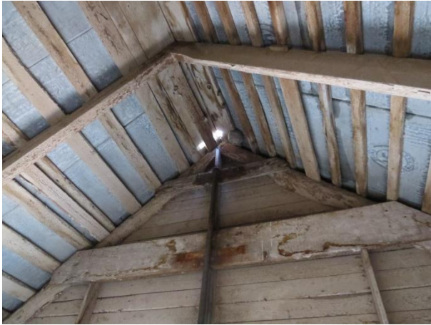
Foto 26. Katuse kaguotsas paiknev sulgemata läbiviik.
