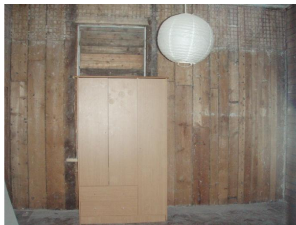
Foto 91. Näide püstplank seinast.
