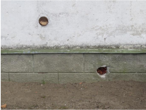
Foto 100. Kinnitopitud ventilatsiooniaugud.
