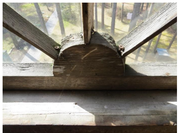
Foto 56 ja 57. Poolkuu kujuline uukaken on hooldamatuse tõttu peagi lagunemas.
