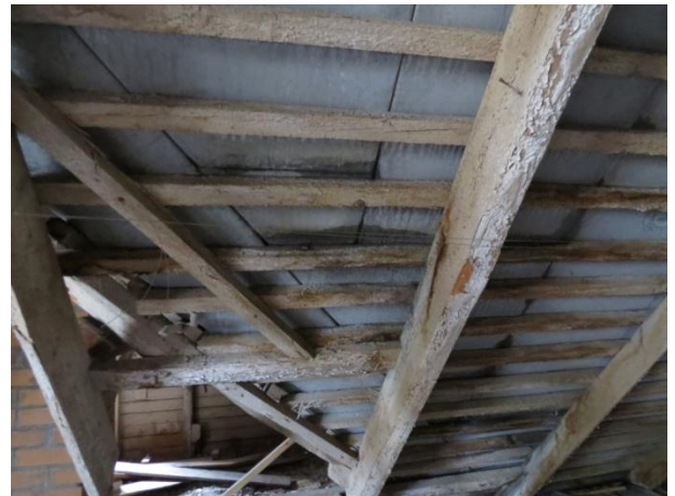
Fotod 28 ja 29. Katuse valtside vaheline läbijooks peale vihma.
