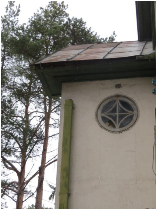
Foto 32. Katkine vihmaveetoru koos dekoratiivaknaga.
