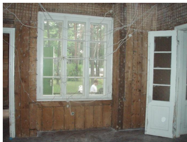
Foto 92 ja 93. Remondi käigus võeti seinad ja lagi puiduni paljaks, õnneks säilis põrand.
