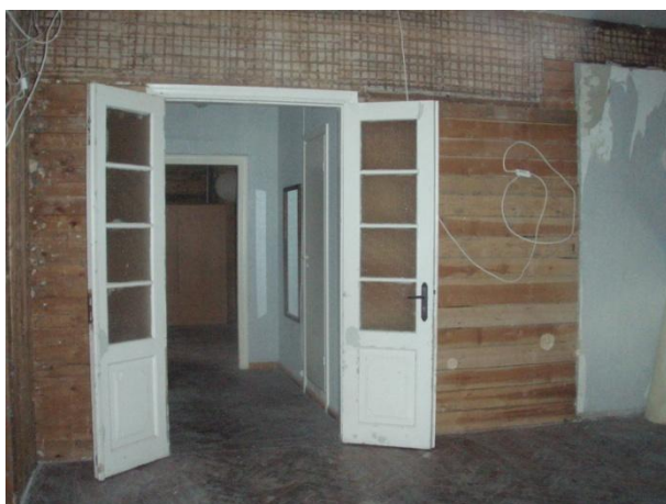
Foto 92 ja 93. Remondi käigus võeti seinad ja lagi puiduni paljaks, õnneks säilis põrand.
