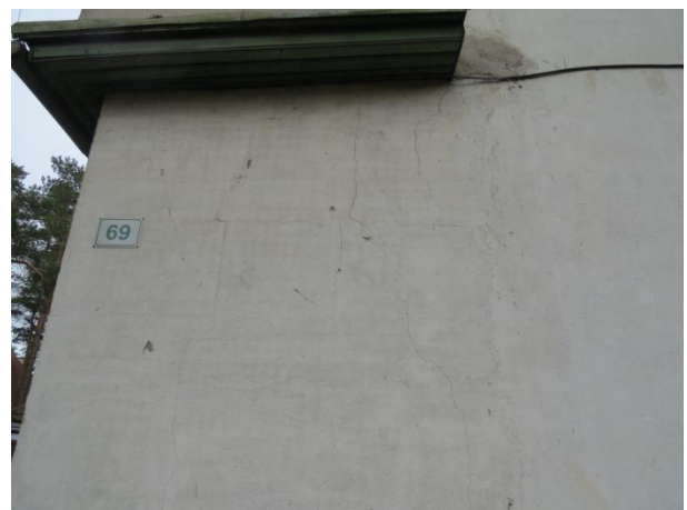
Foto 43. Praguline krohv hoone loodeseinas.
