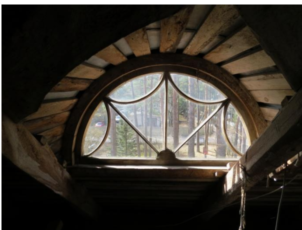
Foto 56 ja 57. Poolkuu kujuline uukaken on hooldamatuse tõttu peagi lagunemas.
