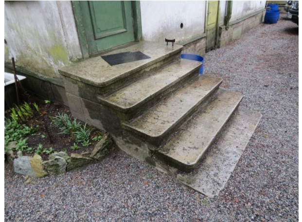
Foto 67. Sissepääs korterisse nr. 2.
