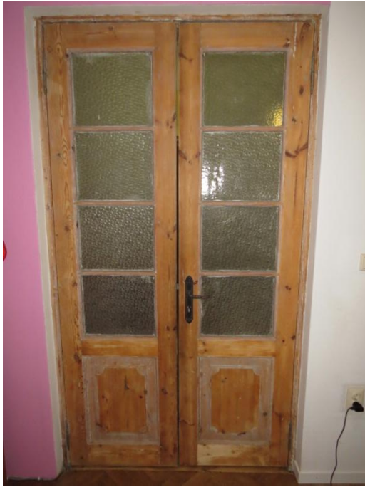
Foto 98. Ukselt on eemaldatud vanad värvikihid.
