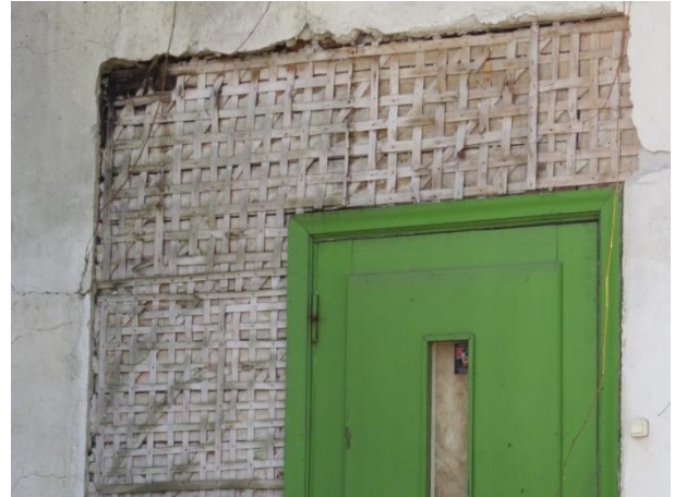
Foto 45. Maha lõhutud krohvi alt on näha puidust krohvimatti.
