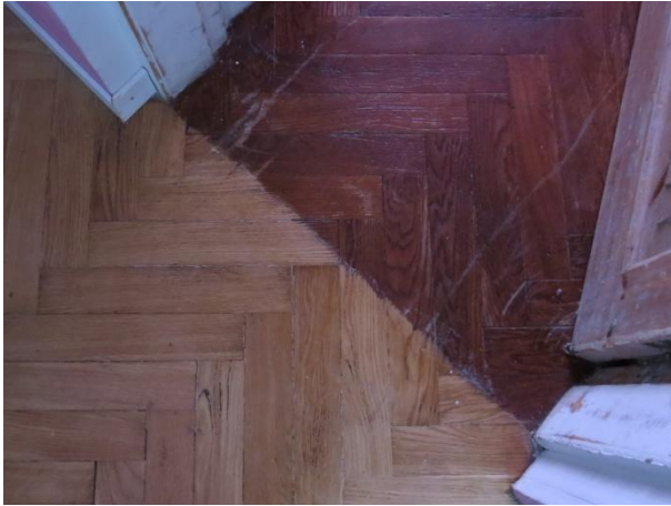
Foto 94. Originaalpõrand- pool lihvitud, pool mitte.
