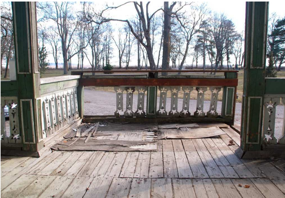
25. Fragment väiksema veranda kahjustunud puitosadest. Epp Vahtramäe, 12.04.2016
