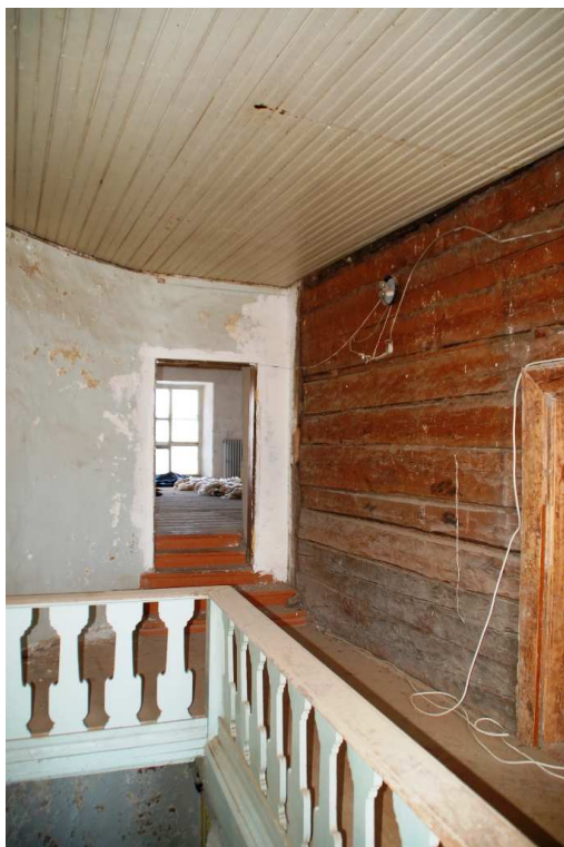
26. Vaade teise korruse vestibüülis. Epp Vahtramäe, 12.04.2016
