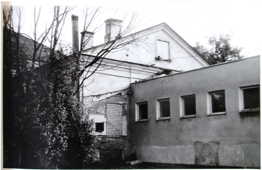
5. Peahoone tagantvaade (1986). Allikas: ERA.T-76.1.7540 Lüganuse vald, Aa mõisa park. Kapitaalremont-restaureerimise tööprojekt. Arhitektuur-ehituslik osa. Kd I. R. Pau, Ü. Saar. P-7506. 1986
