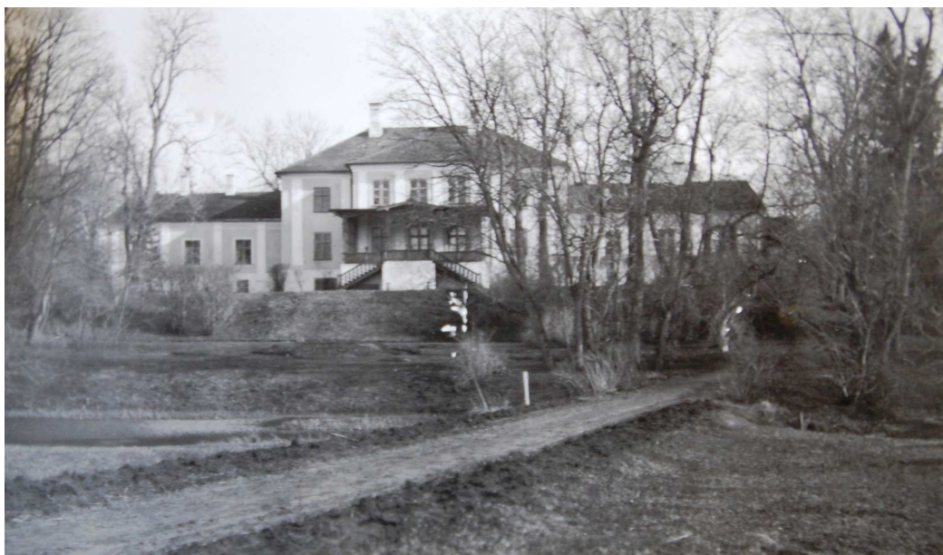
15. Peahoone tagantvaade. Allikas: ERA.T-76.1.14067: Lüganuse vald. Aa mõis. Projekteerimise lähtematerjal. Endise Aa mõisa peahoone, Aa internaatkodu fassaadide, katuse ja pargi kap.remont-restaureerimine. Peahoone fassaadide ülesmõõtmine. Kd I H. Adrikorn. Ü-700, 1985
