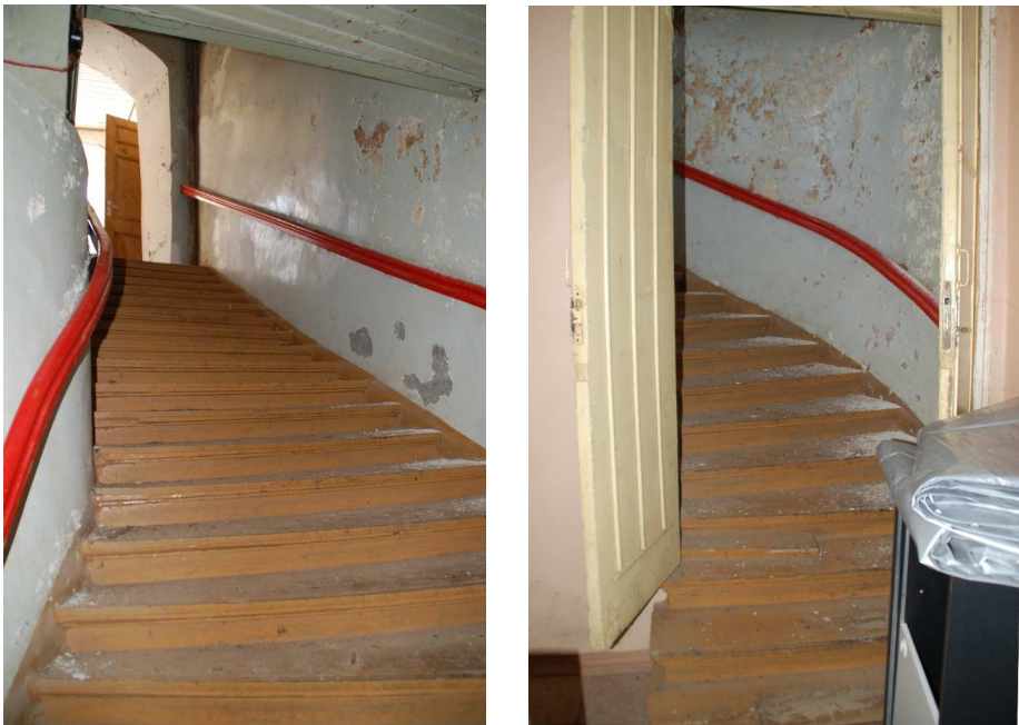
33-34. Peatrepp teisele korrusele. Epp Vahtramäe, 12.04.2016
