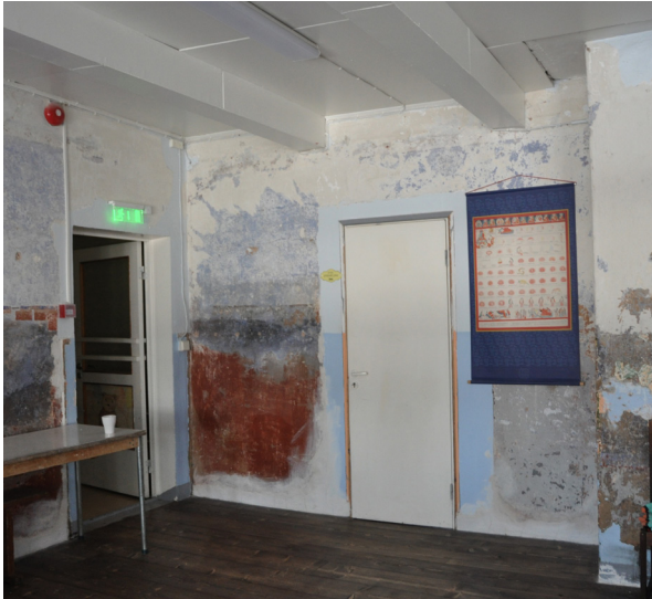
20. Saali läänenurk. Paljastunud maalingukihid.
