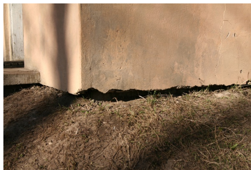
Foto 7: Elamu tuulekoja sokliososa
