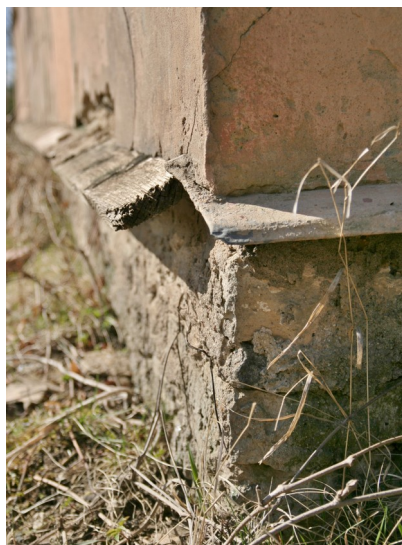
Foto 6: Elamu paekivivundament ja puidust veelaud
