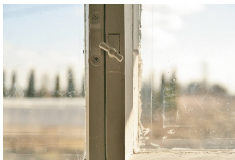
Foto 12: Lõunafassaadi üheksase jaotusega akna luftakna kinniti
