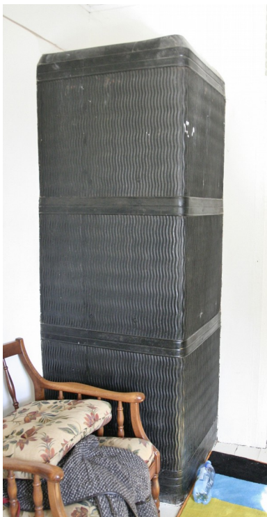
Foto 13: Uus plekkahi elutoa ja köögi vahel
