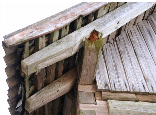
Foto 19: laudahoone säilinud osa katusekonstruktsioon
