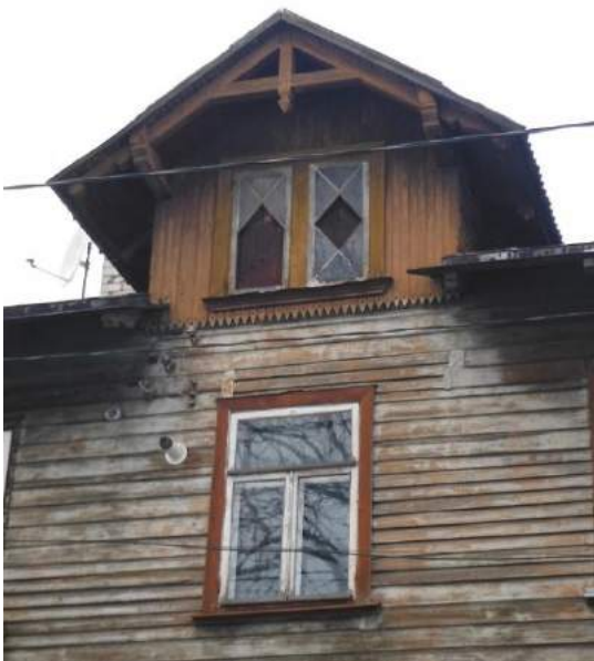
Illustratsioon. Vasakul – Vintskapi aken eristuva raamijaotusega, nõukogudeaegne aken trepikojas; Paremalt – Soklikorrusel sepistatud hingedega aknaluugid. 20.04.2016.
