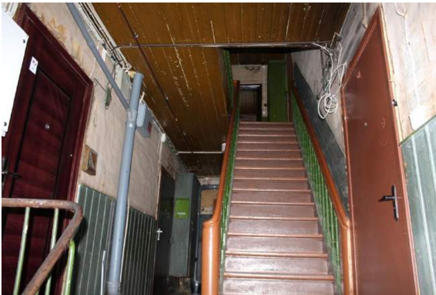
Illustratsioon 26. Vaade välisuksest sisenedes trepikotta., vasakul metallist piire. 21.04.2016
