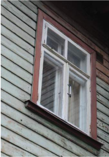
Illustratsioon 22. Vasakul – Originaal raamijaotusega puitaken; Paremalt – Originaal aknakarniis ja piirdelauad. 20.04.2016.
