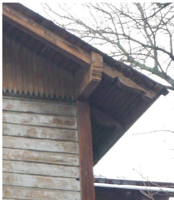
Illustratsioon 12. Vasakul – Peafassaad Härjapea tänaval; Paremalt – Originaal saelõikelised sarika- ja pärliniotsad, viilu- ja fassaadilauad. 20.04.2016
