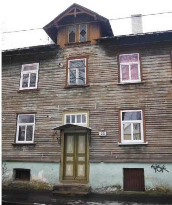
Illustratsioon 12. Vasakul – Peafassaad Härjapea tänaval; Paremalt – Originaal saelõikelised sarika- ja pärliniotsad, viilu- ja fassaadilauad. 20.04.2016
