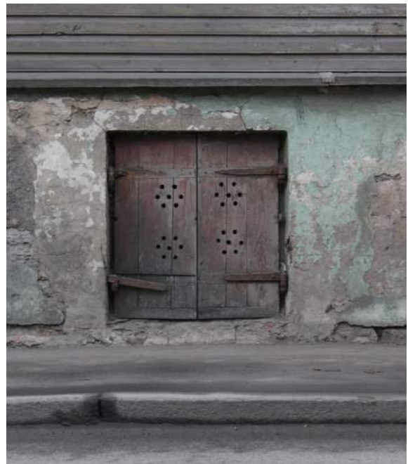
Illustratsioon. Vasakul – Vintskapi aken eristuva raamijaotusega, nõukogudeaegne aken trepikojas; Paremalt – Soklikorrusel sepistatud hingedega aknaluugid. 20.04.2016.
