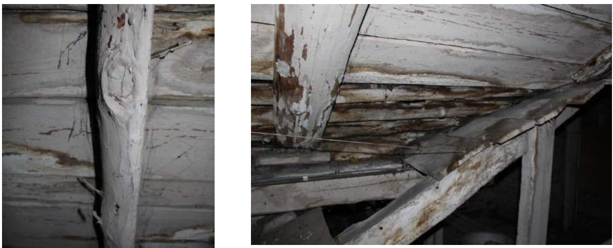
Illustratsioon 20. Vasakul – Poolpalgist sarikas; Paremal – Avariiline neelukoht. 20.04.2016
