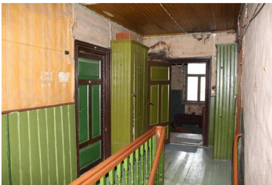
Illustratsioon 14. II korruse trepikoda. Säilinud kapid, puidust tahveluksed, puitlambriid seinad. 20.04.2016
