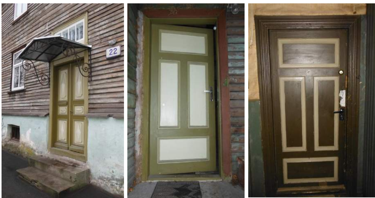
Illustratsioon 24. Vasakul - Restaureeritud välisukse vastavalt maja välisviimistluspassile; Paremalt – Säilinud korteriuks. 20.04.2016
