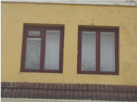
Foto 82. Aken tüüp 1 fassaad
