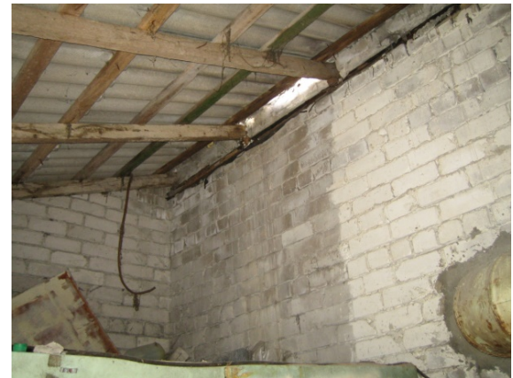
Foto 38. Juurdehituse katusekonstruktsioon
