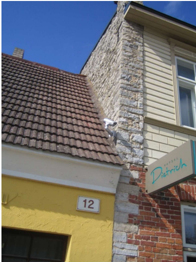
Foto 29. Fassaadi liitumine Karja 10-ga
