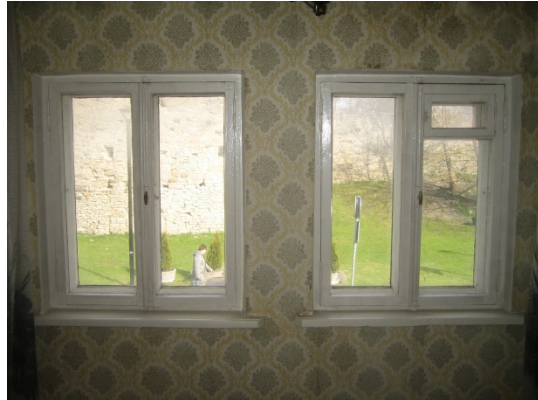
Foto 83. Aken tüüp 1 fassaad seest
