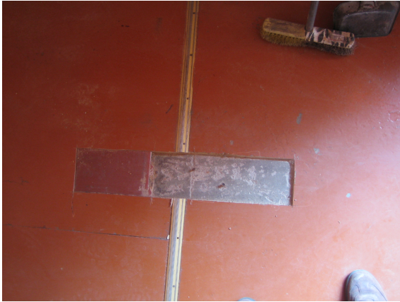
Foto 57. Peahoone põrand sondaaz
