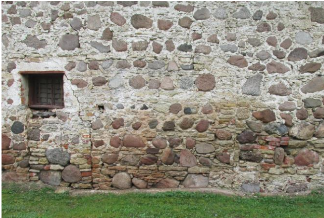
7-8. Hoone sokkel. Sillutisriba puudub. Fotod: Kalle Merilai 27.04.2016.a.
