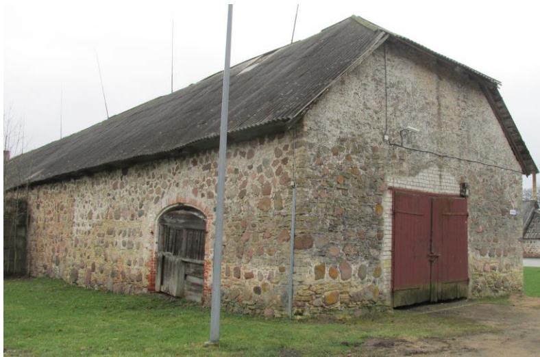
9. Välisseinad Foto: Kalle Merilai 27.04.2016.a.
