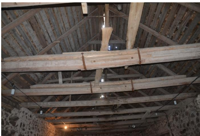
12. Katusekonstruktsioon. Foto: Kalle Merilai 27.04.2016.a.
