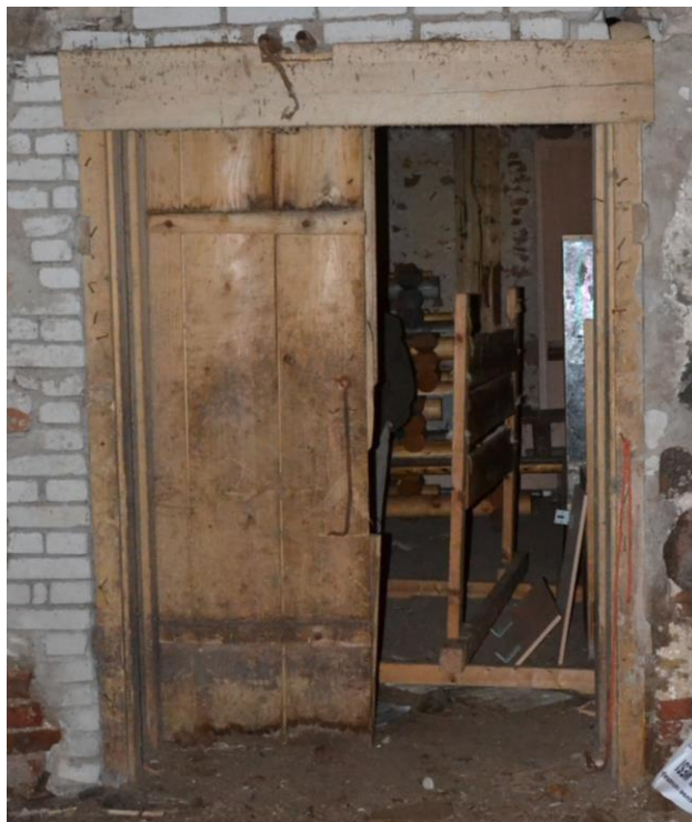
20. Hoone siseuks. Foto: Kalle Merilai 27.04.2016.a.
