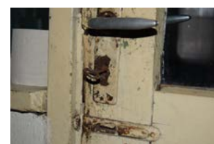
78. SU-3 link, lukukate, võti ja katkine spingaleti kest
