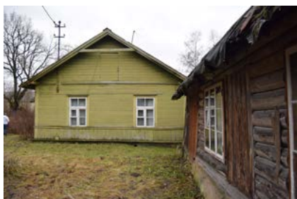
31. Hoone põhjakülg. Nähtav läänekülje vajumine. Erakogu. 2016
