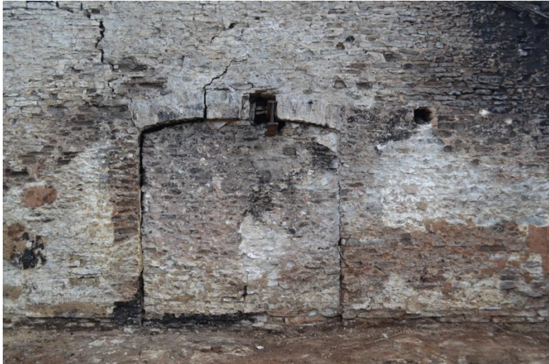
Foto 29. Kinnimüüritud ukseava 1. korruse vaheseinas
