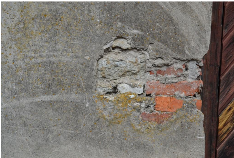
Foto 17. Lõunapoolne välissein – mahatunud tsementkrohvi alt paistmas tellis ja paekivi
