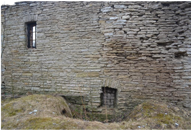
Foto 16. Põhjapoolne välissein – erinevad ehitusjärgud
