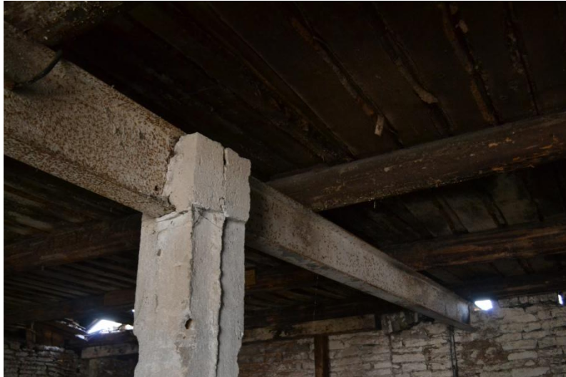
Foto 15. Tugevduseks on Nõukogude ajal paigutatud talade alla omakorda metallkonstruktsioon
