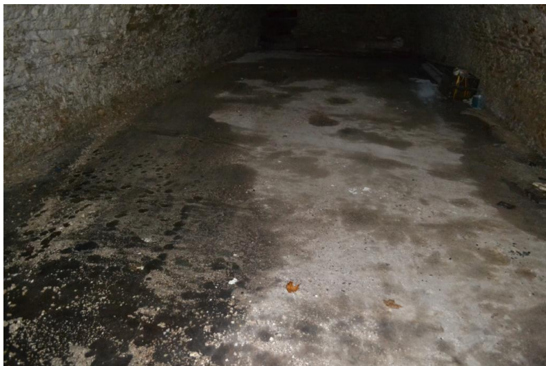
Foto 19. Betoonpõrand keldris, näha niiskuskahjustused
