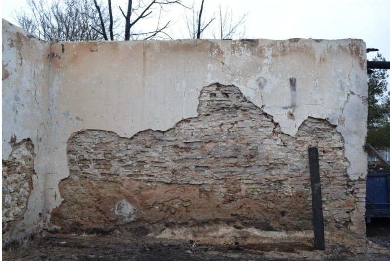
Foto 18. Idapoolne sisesein tsementkrohviga
