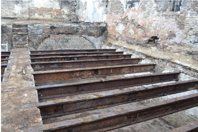
Foto 7. Keldri põhjapoolses otsas hilisemad raudtalad võlvlae asemel
