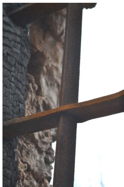
Foto 23 ja 24. Aken lääneküljel. Põhjapoolse akna sepistatud trellid ja põlengus kahjustada saanud lengid
