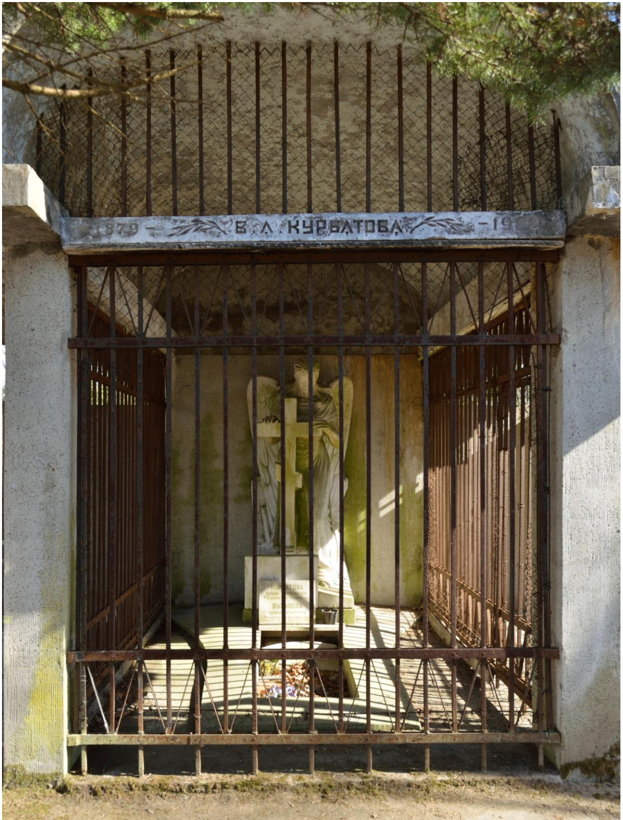
Foto 6. Inglise skulptuuri piiravad Nõukogude aegsed metallvõred mille kogu ulatuses võib näha roostetamist.
