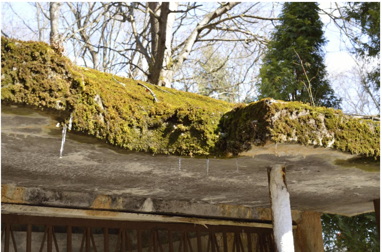
Foto 14. Alla kukkunud katuse serv. Katusel kasvab korralikult paks sambla kiht koos väikeste puuvõrsetega.
