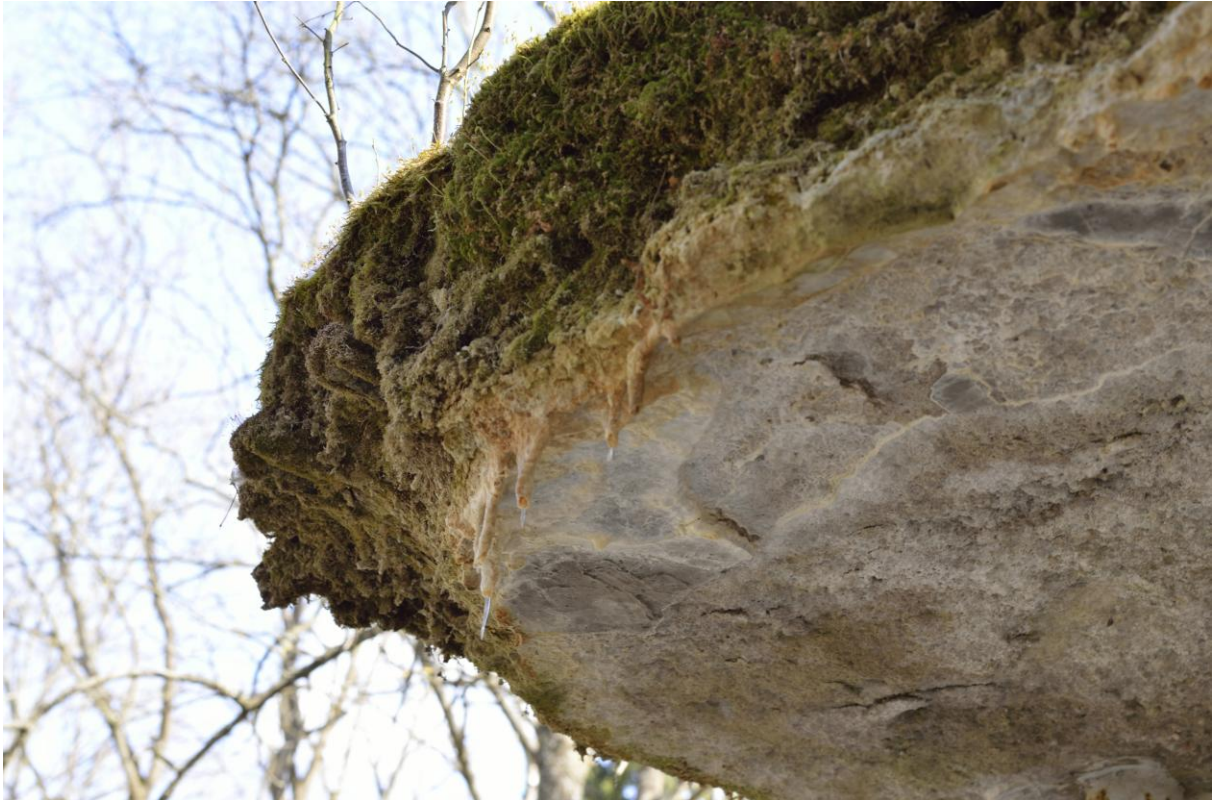
Foto 13. Kabeli katuse servast ripuvad alla väikesed stalaktiidid. Raudbetoonist katus on altpoolt vaadates täis pragusid ja tühimikke.
