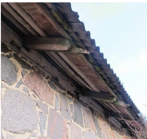
89. Sarikad ja vihmaveerenni konstruktsioon
