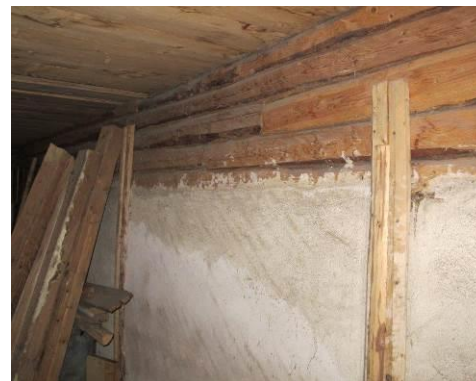
68. Aida sisevaade – krohvitud seinad viljahoidlate ulatuses
