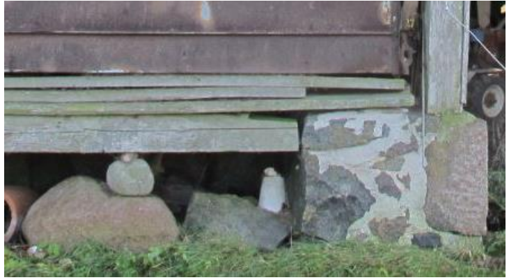
45. Aida esise terrassi vundament põhjafassaadil
