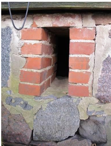
47. Vundamendi tuulutus lõunafassadil
