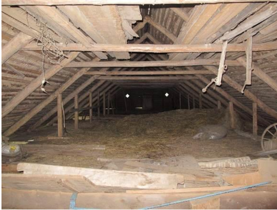
85. II korruse katusekonstruktsioon
