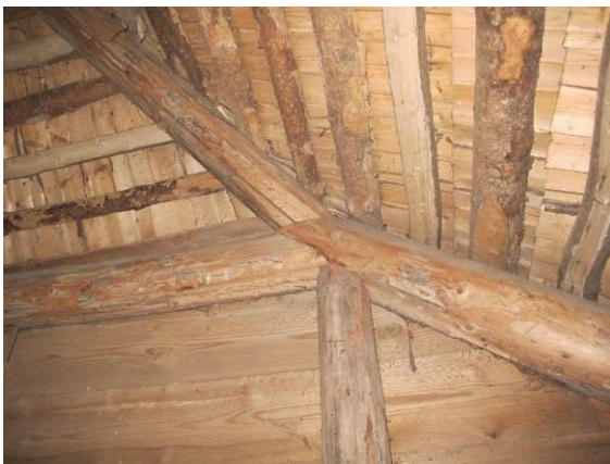
87. Katuse kandekonstruktsioon kelba juures
