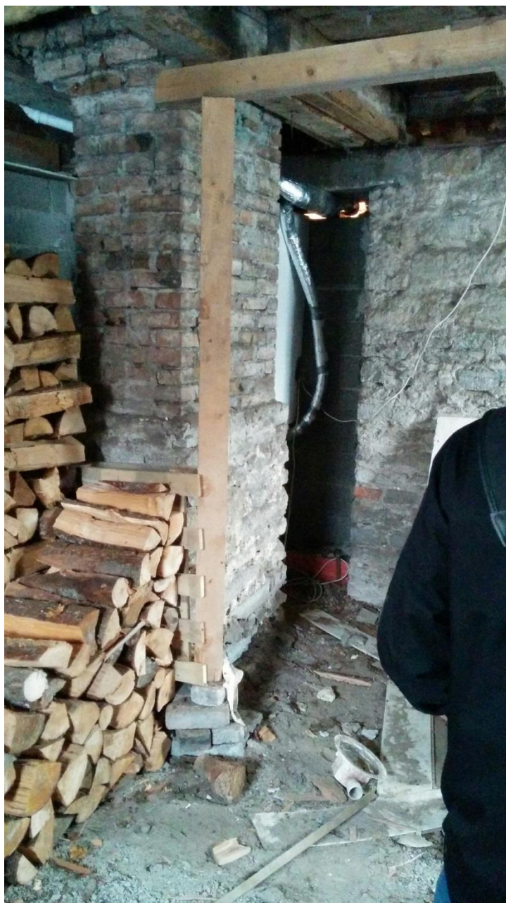
Foto 15. Ohtlik ajutine toestus mis toetab põranda kandetala, autori foto.
