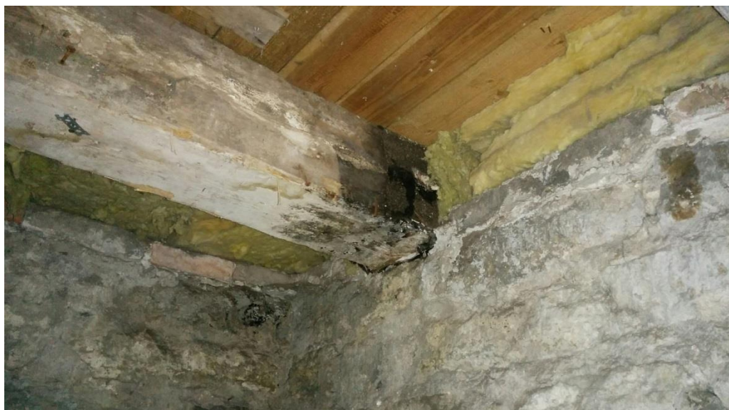
Foto 13. Põranda kandev tala toetub otse kivimüürile, autori foto.
