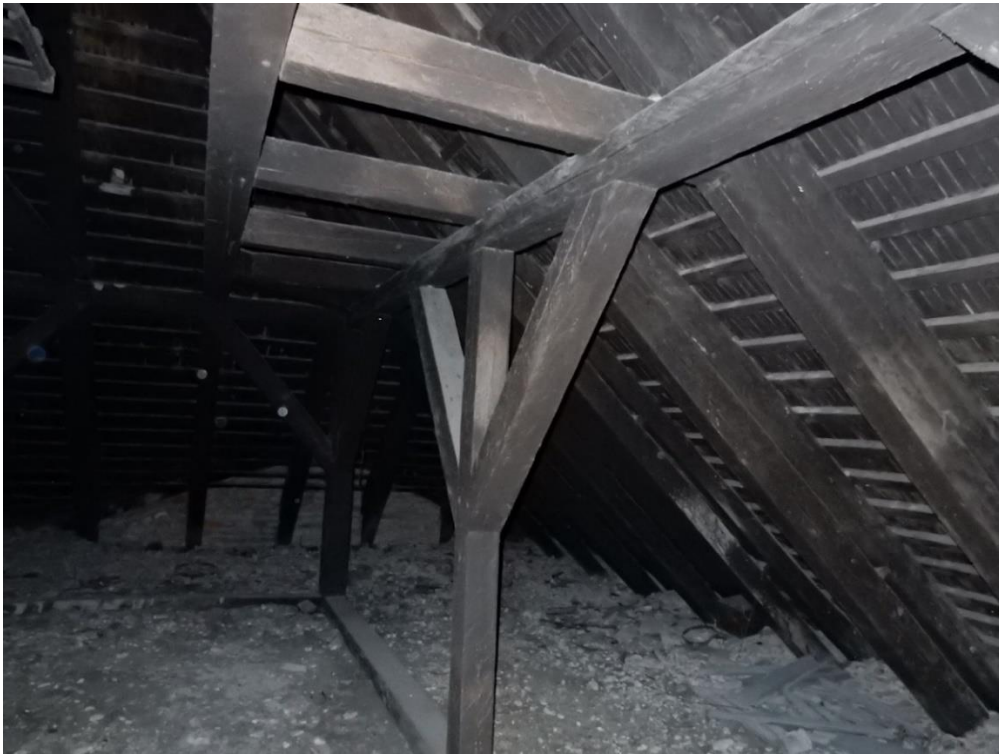
15. Pööninguvaade Torma-poolsele kelbaalusele: kirvega tahatud puitkonstruktsioonid, puitsindlid, lael on eemaldatud punased põletatud savist S-kivi jäänuseid, 25.03.2017
