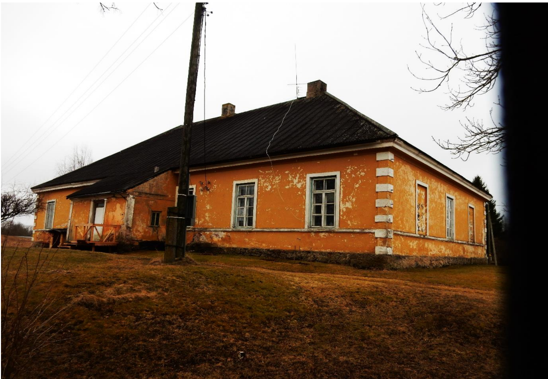
46.Vaade põhjast peahoonele, 25.03.2017
