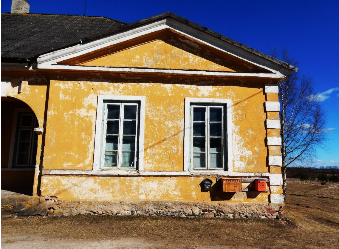
72.Vaade Tartu-poolsele risaliidile, aknad A3 ja A2, sokli keskosas geodeetiline alusvõrgu punkt nr „88“, 30.03.2017
