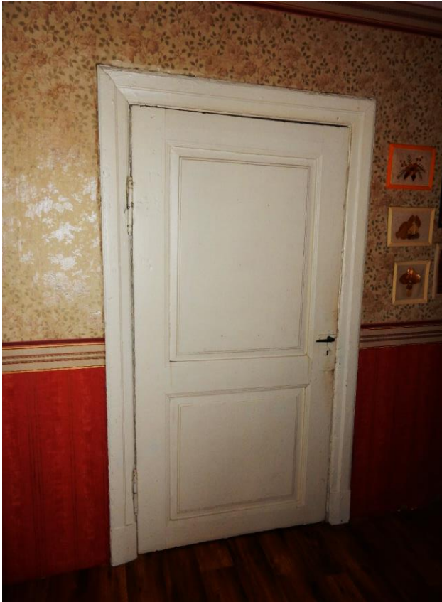
95.Sisevaade ruumis nr 9 uksele U15, 25.03.2017
