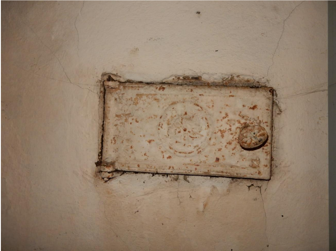
87.Sisevaade ruumis nr 19 tahmaluugile, 24.04.2017
