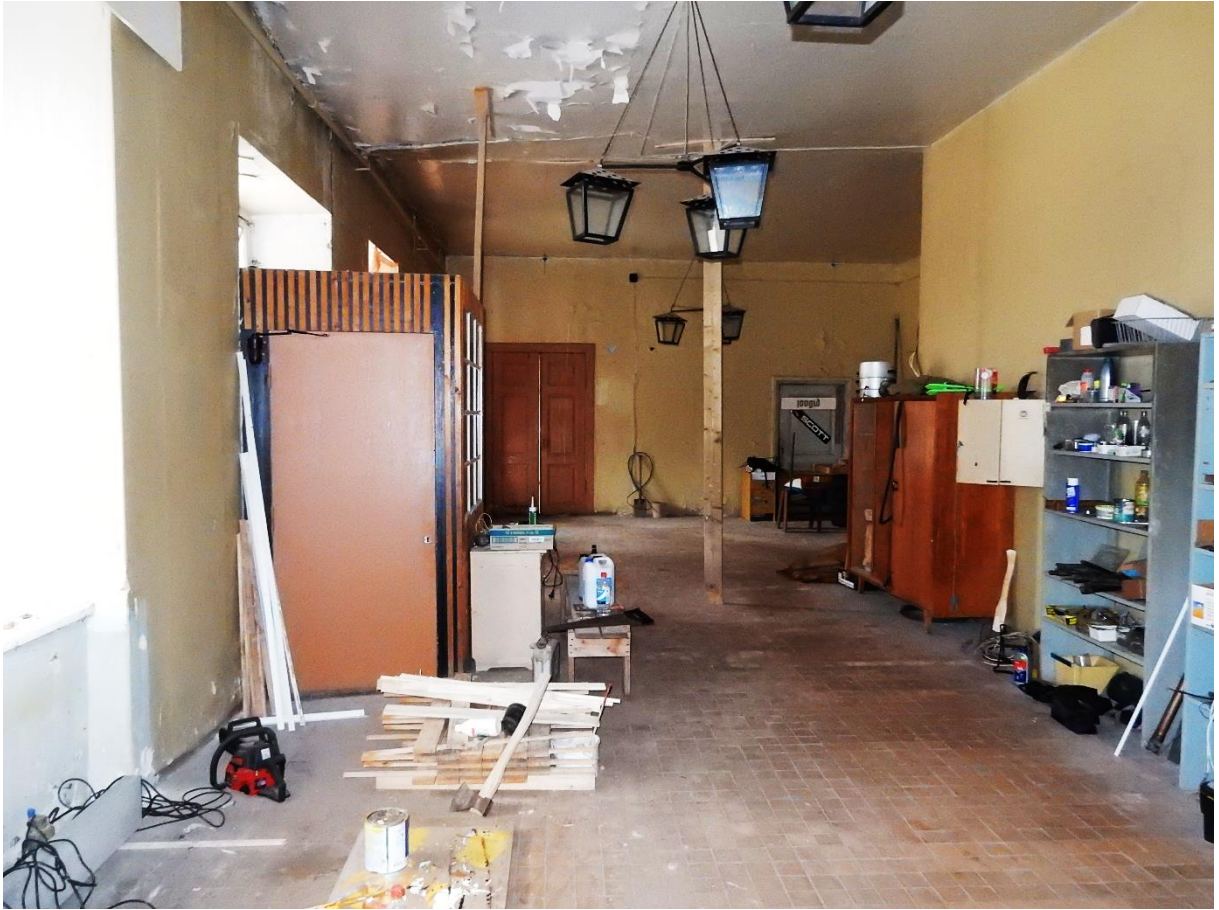
76.Sisevaade ruumis nr 5 uksele U1, 25.03.2017
