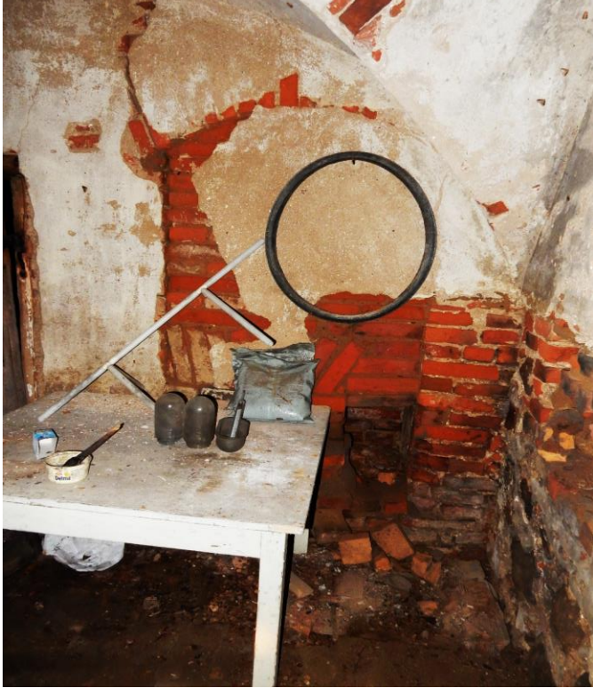
113. Vaade keldri ahjusuule ruumis nr 2, 25.03.2017
