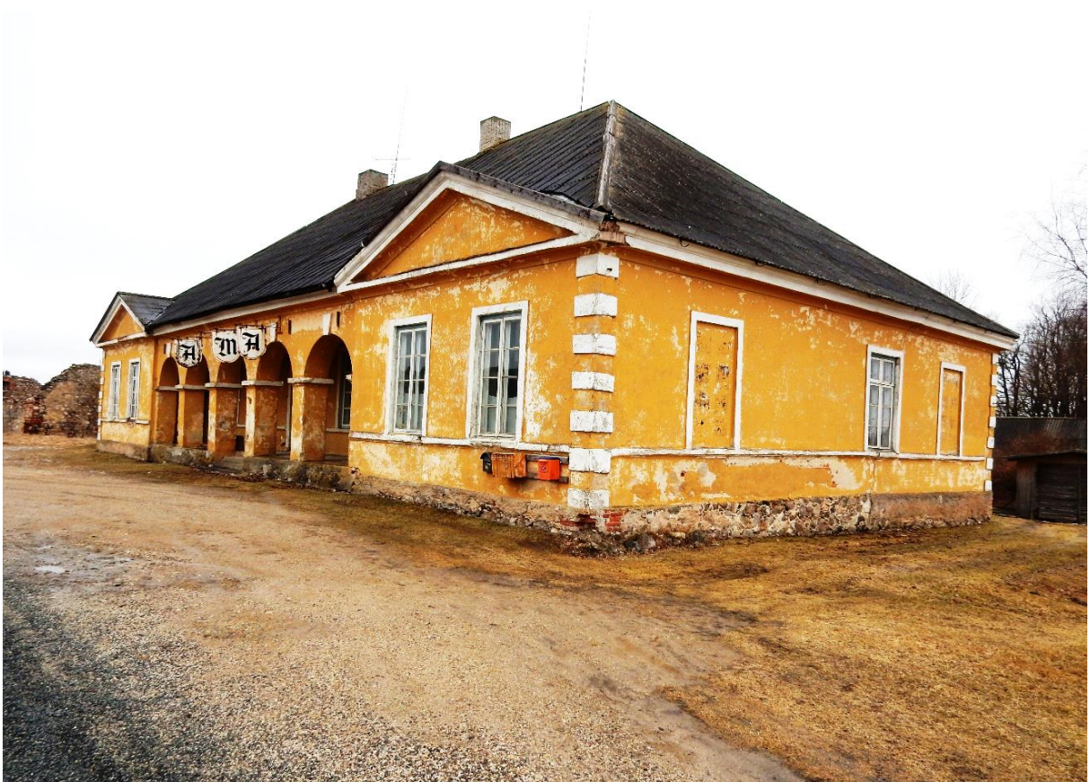
36. Vaade lõunast Torma postijaama peahoonele, 25.03.2017
