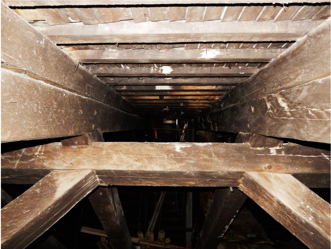
101. Pööninguvaade sarikate ja räästatõstjate vahel harja suunas, keskel tugikäppade ja penni vahel on tugiraamistiku ülemine vöö, 25.03.2017
