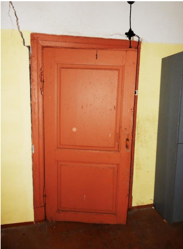
88.Sisevaade ruumis nr 18 uksele U5, 25.03.2017
