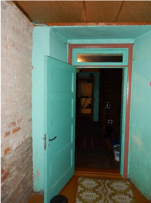
97.Sisevaade ruumis nr 12 uksele U10, 24.04.2017
