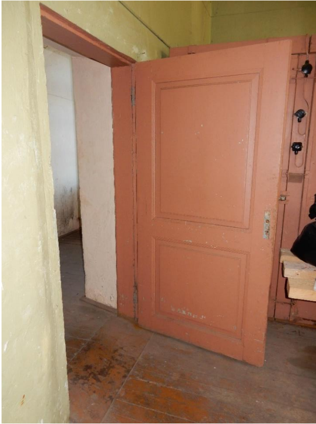
89.Sisevaade ruumis nr 20 uksele U4, 24.04.2017
