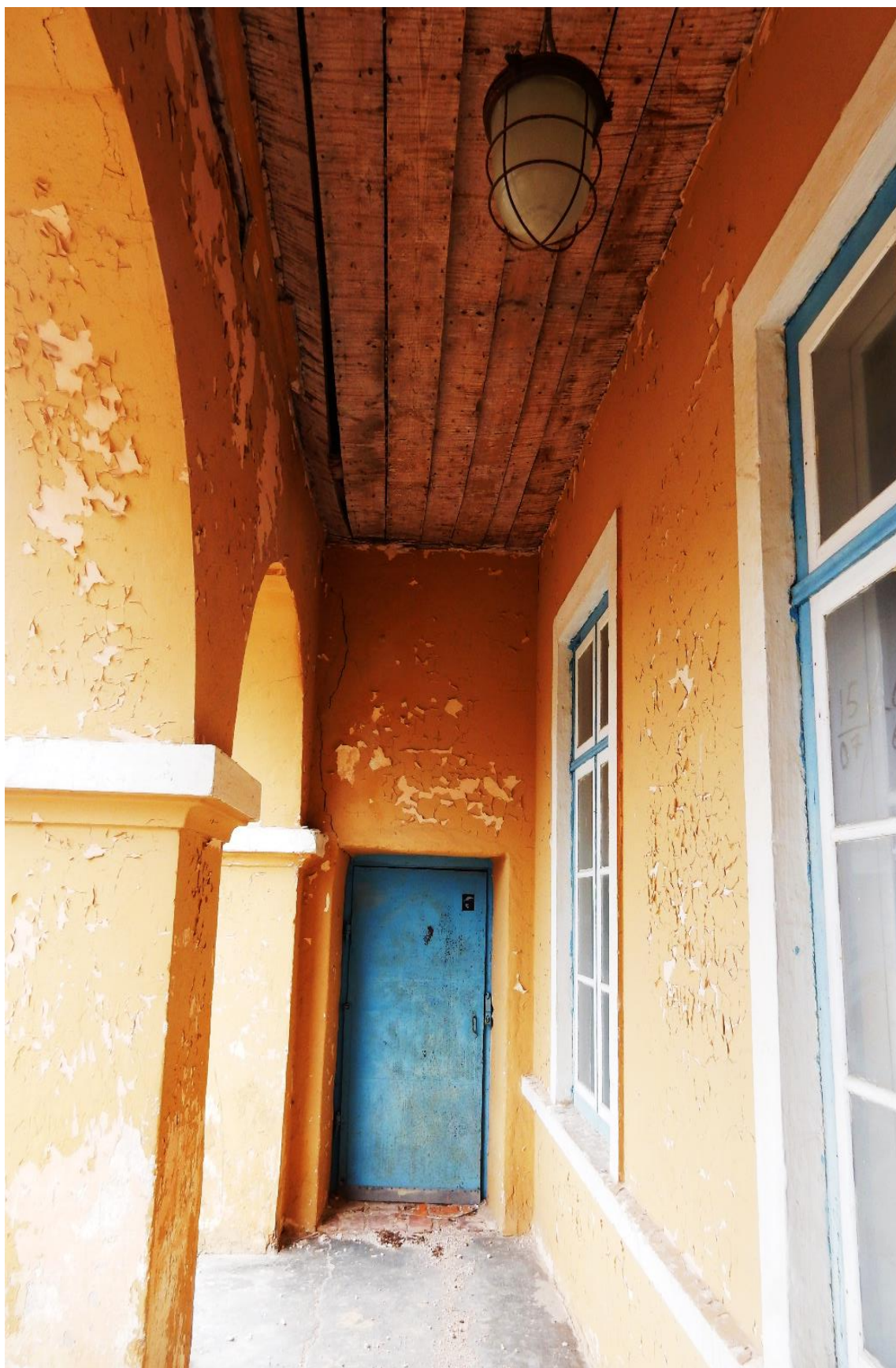
74. Vaade kaaristualusele uksele VU2, 30.03.2017
