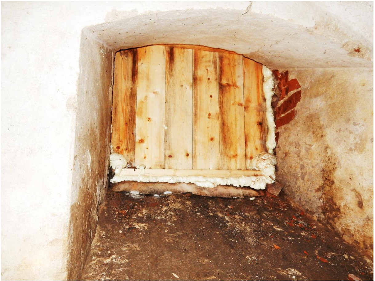
115.Lubamatu poliüretaanvahu kasutamine keldri akna A21 tihendamisel
