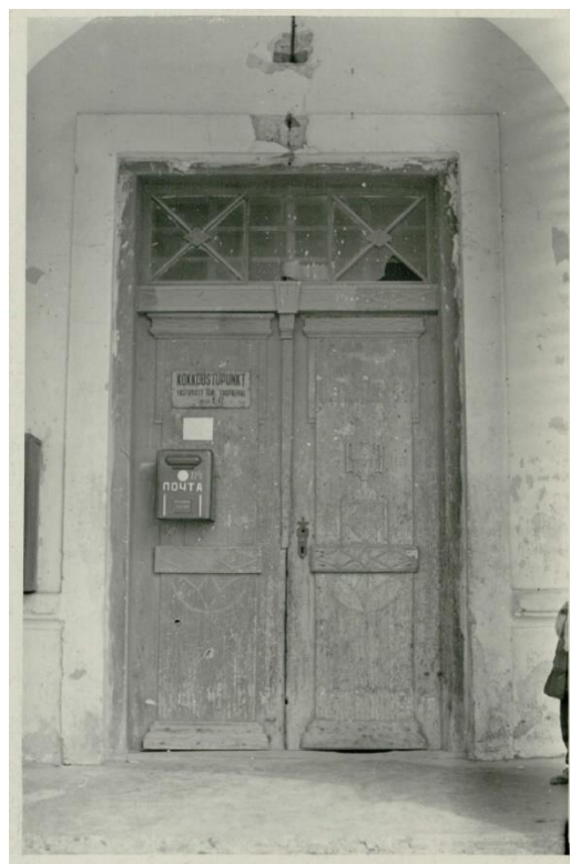
13.Vaade peauksele VU1, ukse link on kadunud, juuli 1964, Kalvi Aluve (ERA.T-76.1.633, P-688-b)
