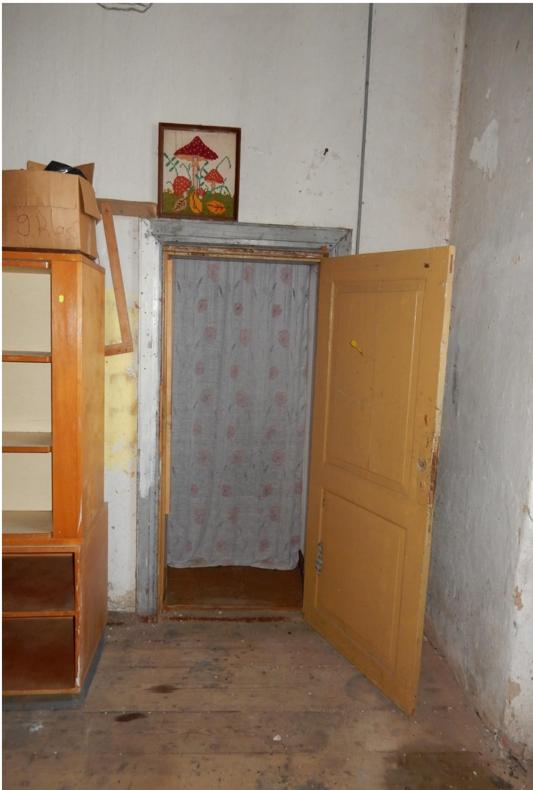
92.Sisevaade ruumis nr 17 uksele U8, 24.04.2017
