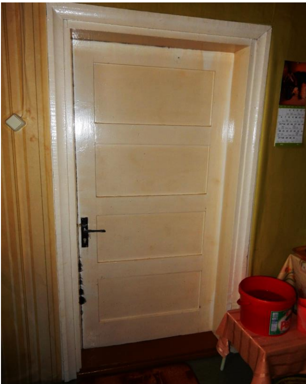
96.Sisevaade ruumis nr 10 uksele U13, 25.03.2017
