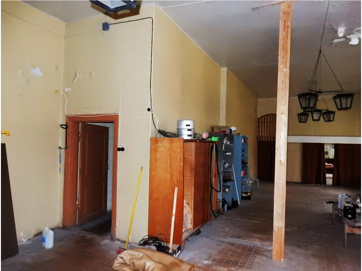
78.Sisevaade ruumis nr 5 uksele U3, 25.03.2017
