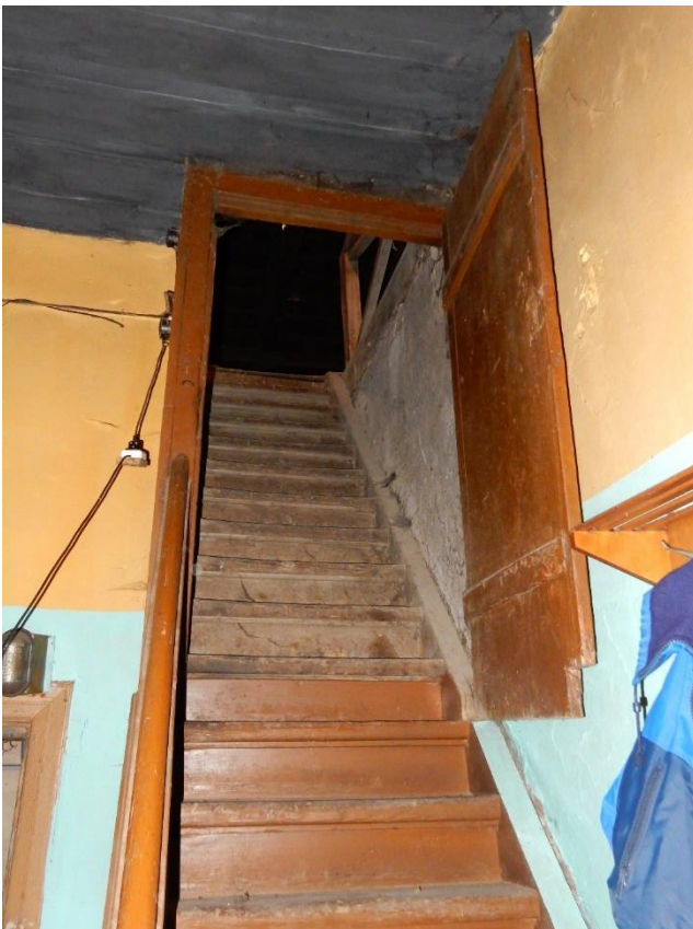
100.Sisevaade ruumis nr 11 pööningutrepile ja -uksele U22, 24.04.2017
