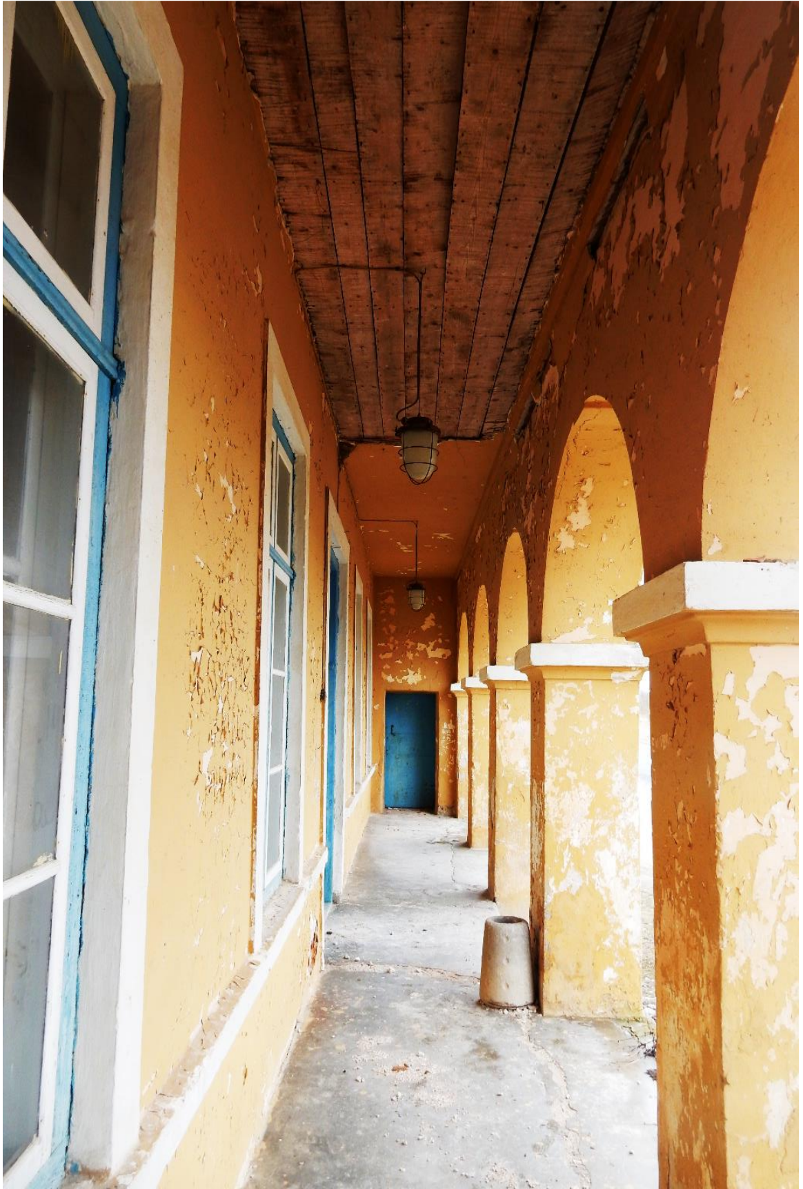
75.Vaade kaaristualusele uksele VU3, 30.03.2017
