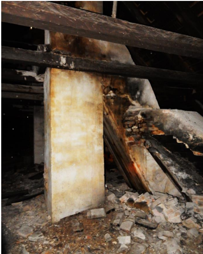
104. Tartu-poolne korsten pööningul, 25.03.2017
