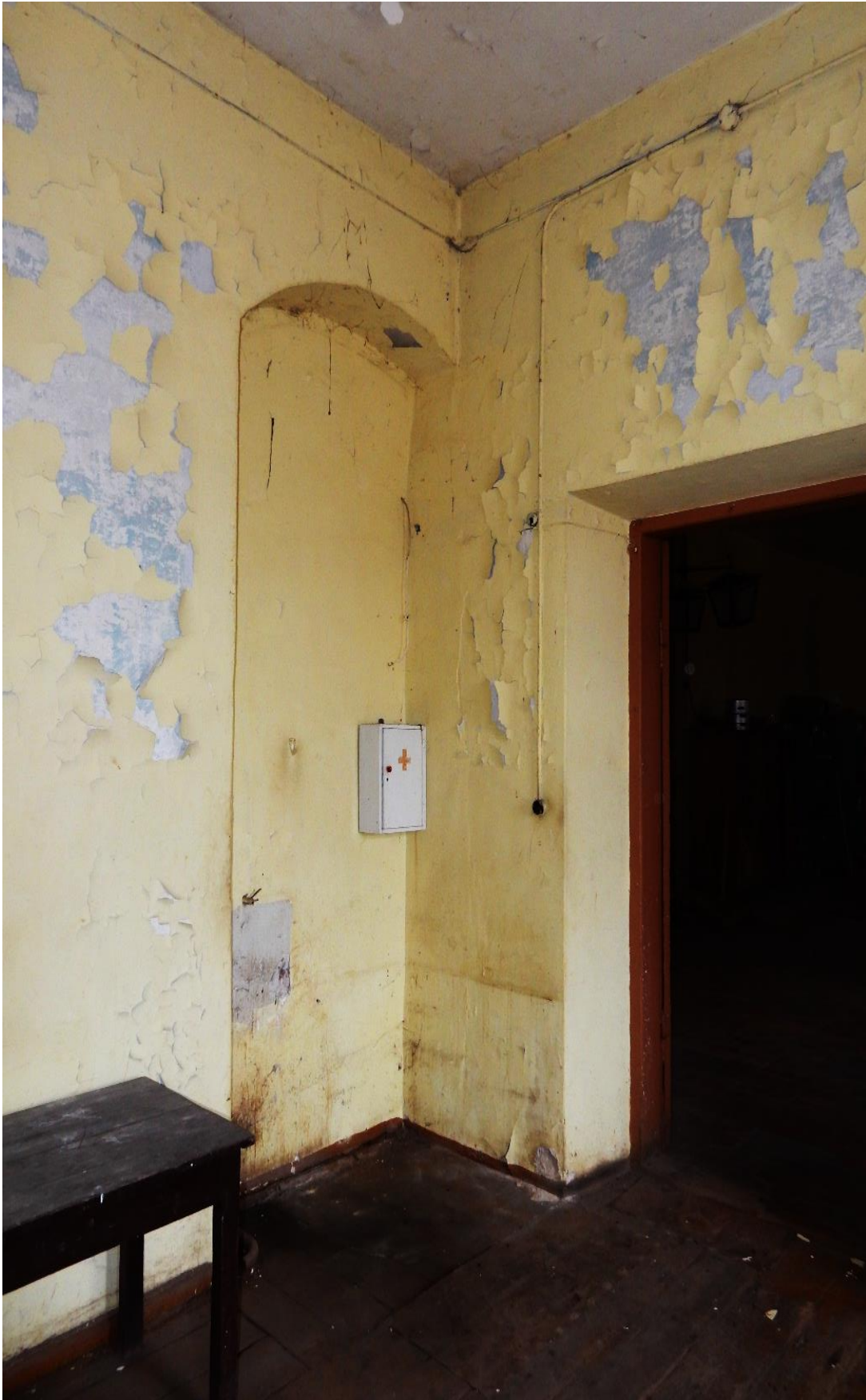
83.Sisevaade endises aadlike puhkeruumis nr 6 ahjukohale ja uksele U1, 25.03.2017
