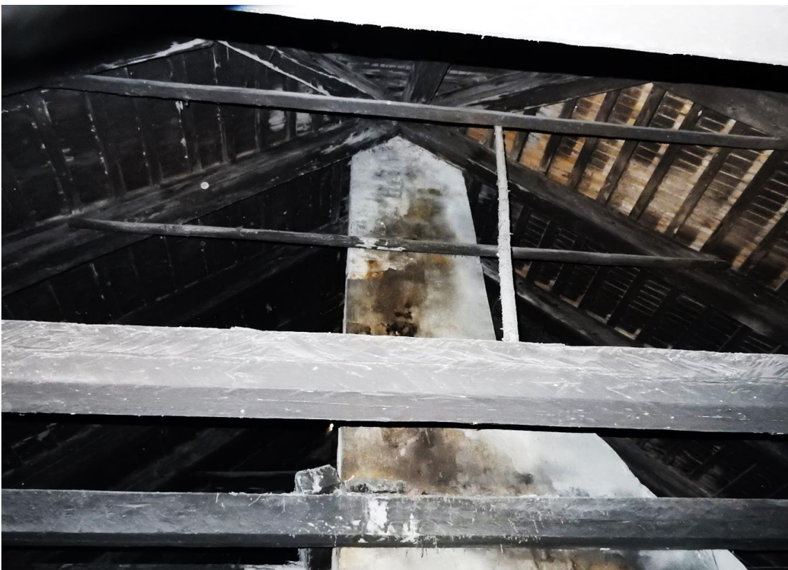
105. Tartu-poolne korsten pööningul, 25.03.2017
