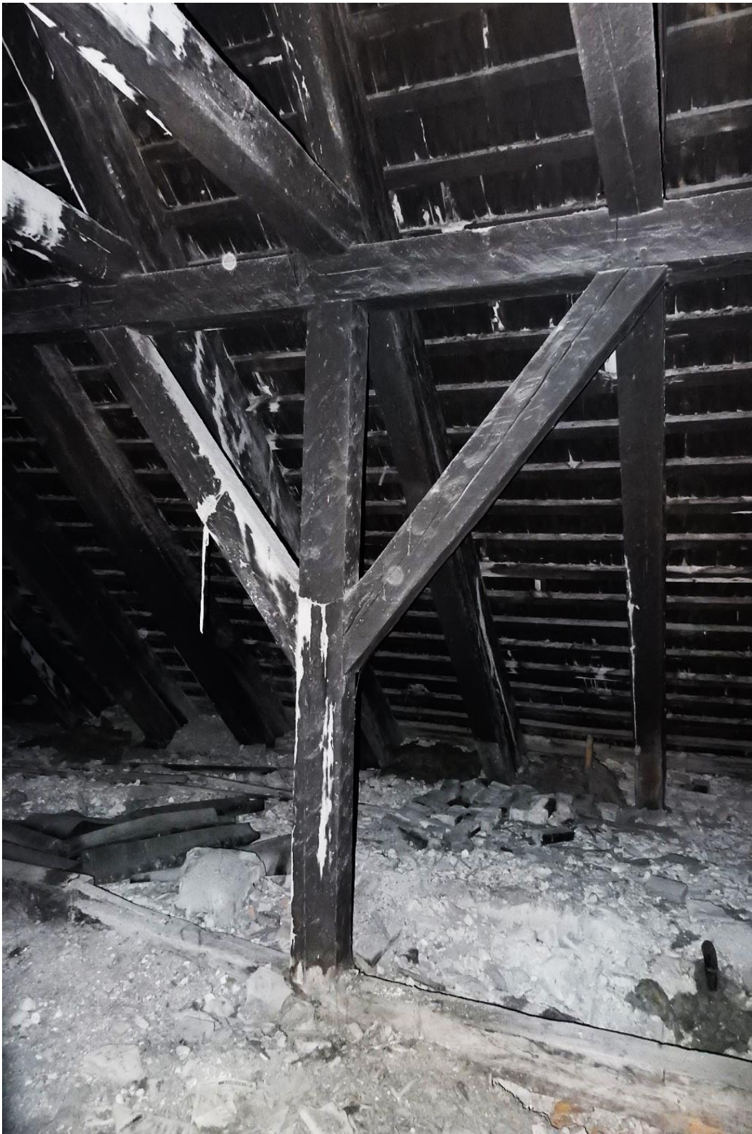
103.Pööninguvaade tugiraamistiku alumisele vööle, tugipostile, tugikäppadele, ülemisele vööle, pennidele, sarikatele ja roovidele, 25.03.2017
