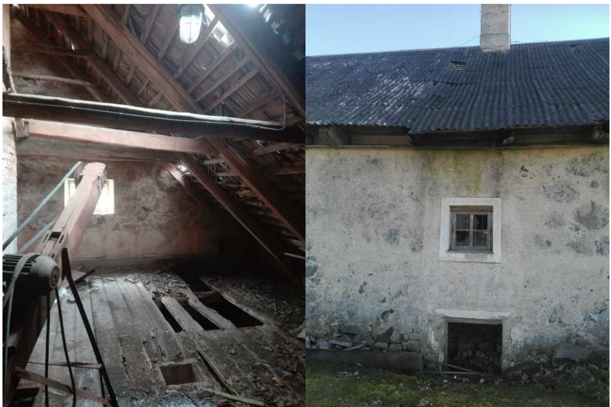
Foto 11 ja 12: Läbisaju piirkond korstnast N-pool – sise- ja välisvaade.
