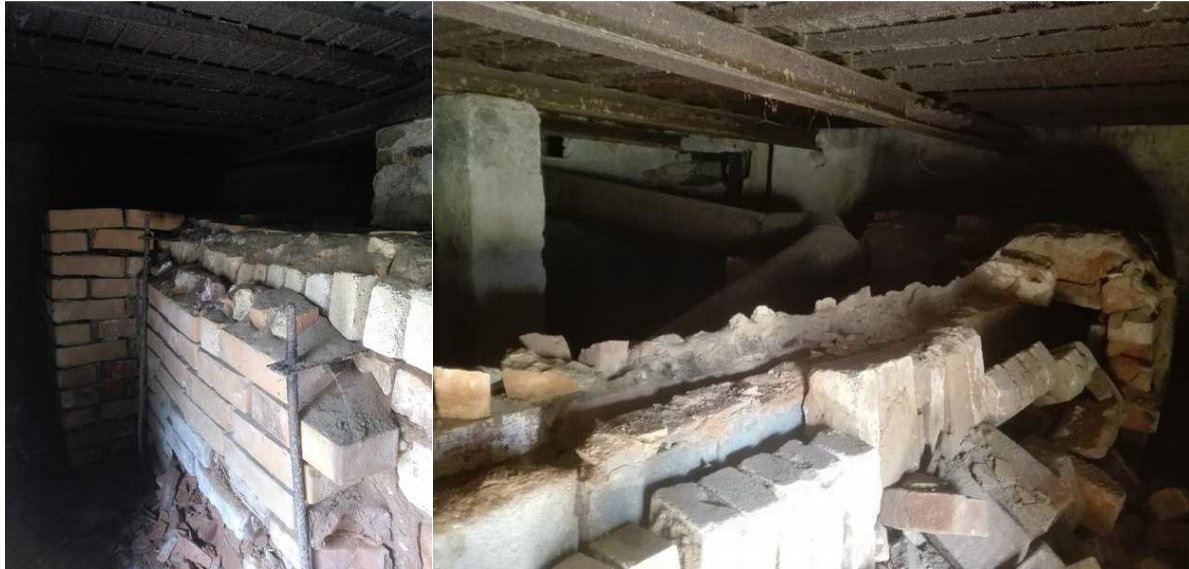
Foto 20 ja 21: Kuivati ahi ja kanalid ning metalltaladele toetuv vilja rest.
