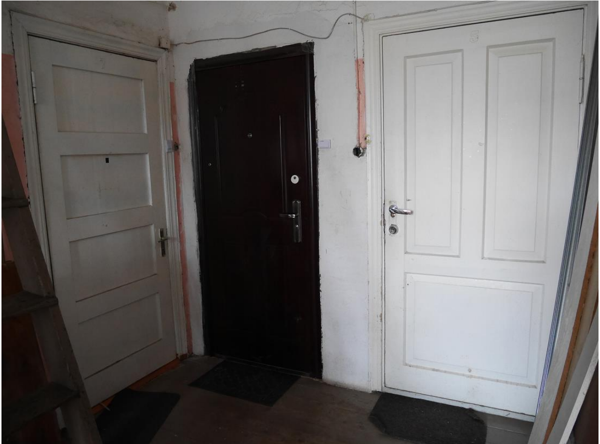
Foto 79. Siseuksed SU-17, SU-18, SU-19. Aprill 2017.
