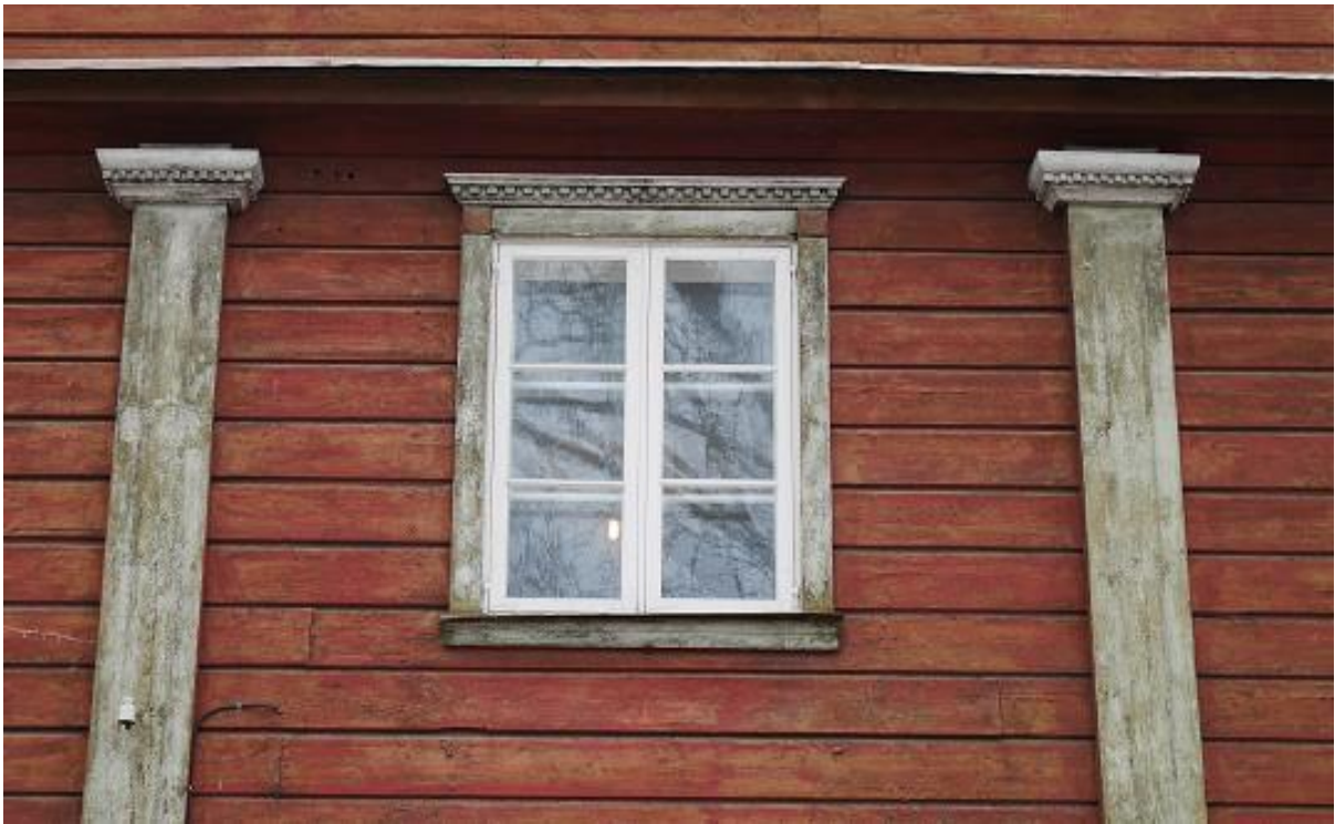
Foto 15. Pilastrid ja karniisid. Aprill 2017.
