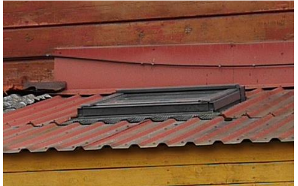
Foto 59. Katuseaken KAA-1. Aprill 2017.
