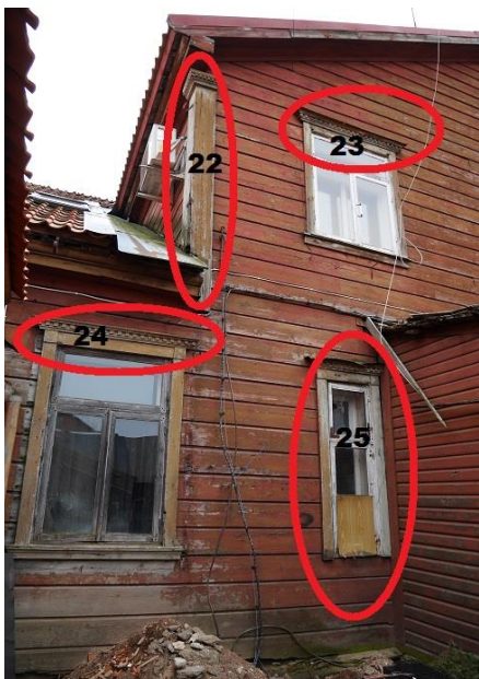
Väärtuslike detailide asukoht hoovipoolsel fassaadil.
