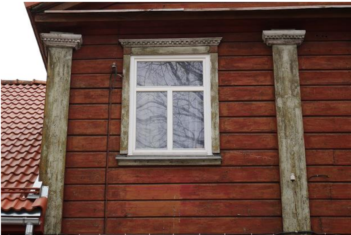
Foto 14. Pilastrid ja karniisid. Aprill 2017.
