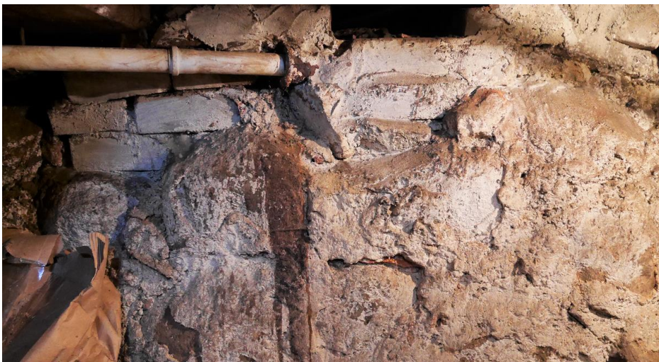
Läbi vundamendi viidud veetoru. Aprill 2017.
