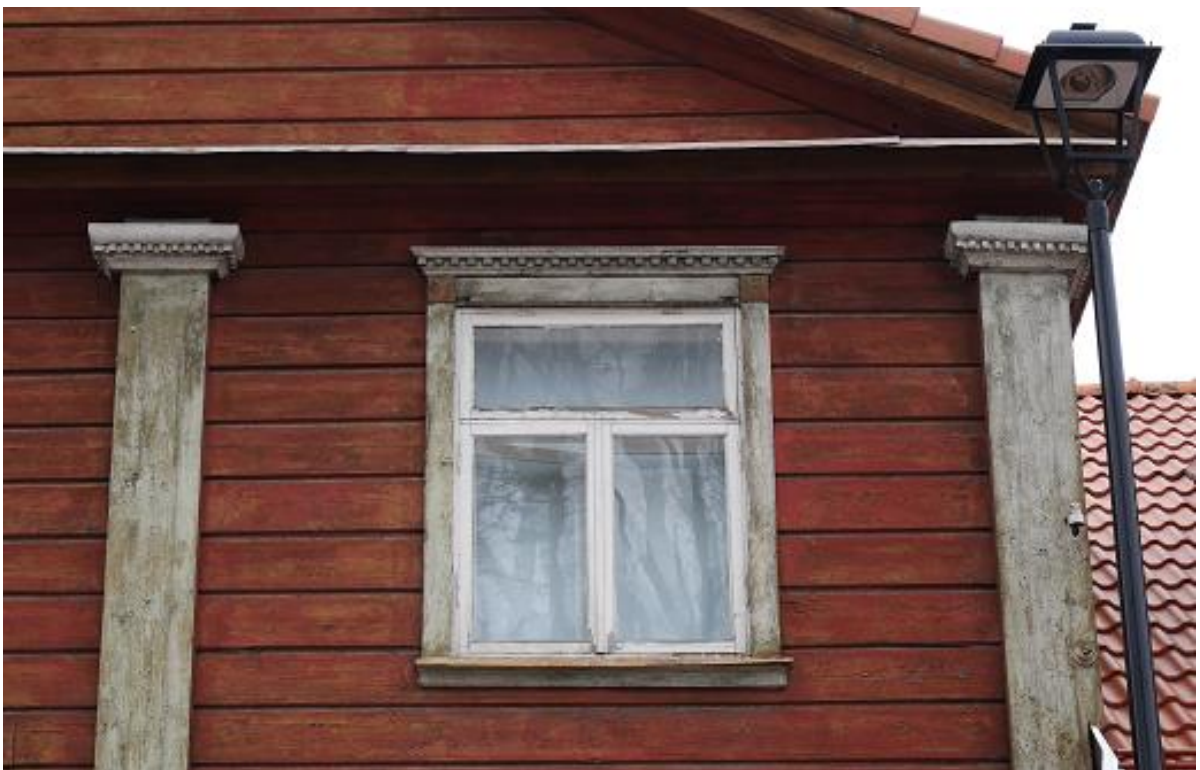
Foto 16. Pilastrid ja karniisid. Aprill 2017.
