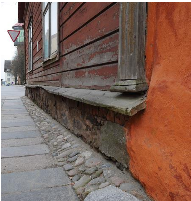
Foto 22. Veelaud ja sokkel Kauba tn poolsel fassaadil. Aprill 2017.
