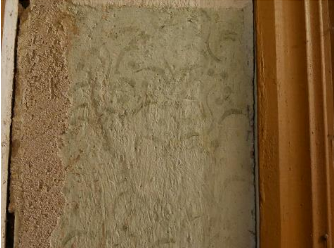
Foto 84. Trafarettmaaling koridori seinal. Aprill 2017.
