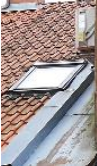
Foto 60. Katuseaken KAA-2. Aprill 2017.
