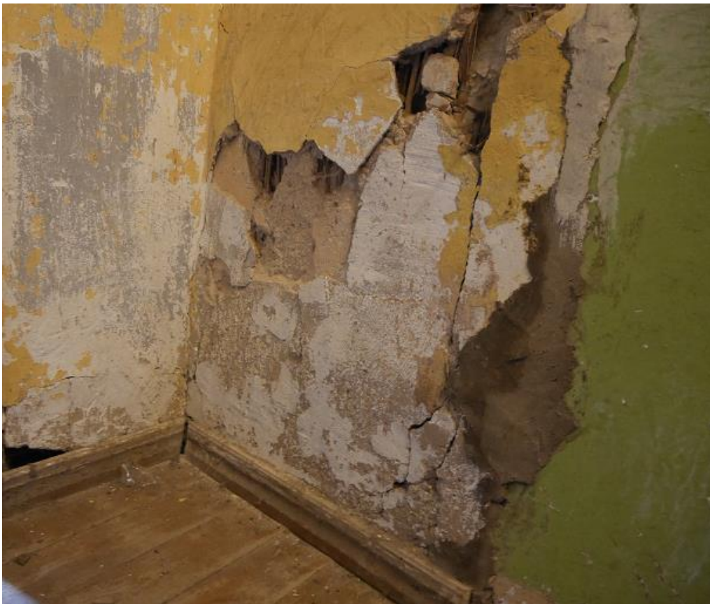
Foto 86. Koridori seinad ja põrand. Aprill 2017.
