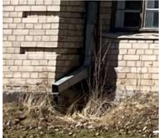
Foto 14 Pilt samast kohast 13.04.2025. Horisontaalse kaldega toruosa on hilisem lisandus ja pole samast materjalist mis ülejäänud toru.
