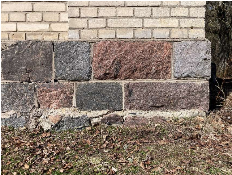
Foto 12 Tahutud maakividest vundament
