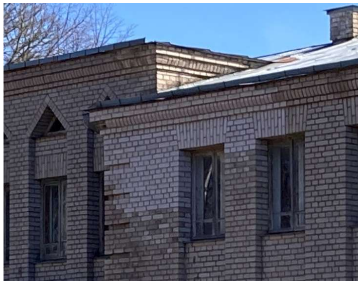
Foto 20 Suuremahuliseim välisseina müüriparandused hoone Jaama tn poolsel küljel.
