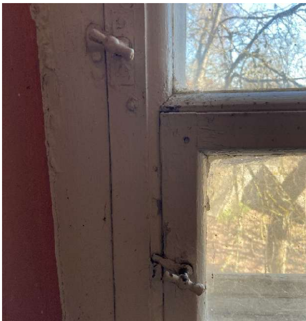
Foto 26 Algupärase akna siseakna ja tuulutusakna sulused. Foto Rauno Silm erakogu
