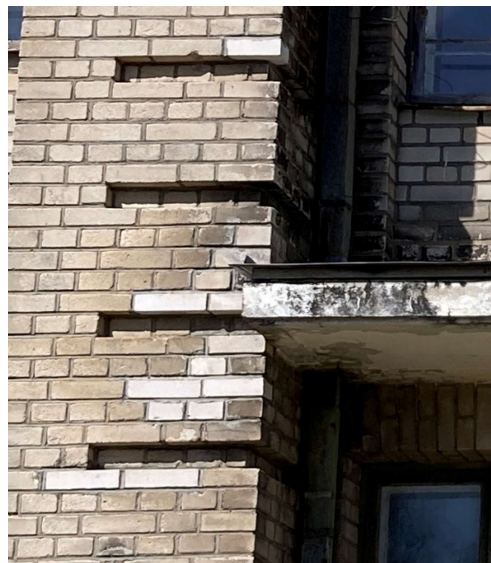
Foto 21 Väiksemahulised - ühe ja mõnekivilised parandused
