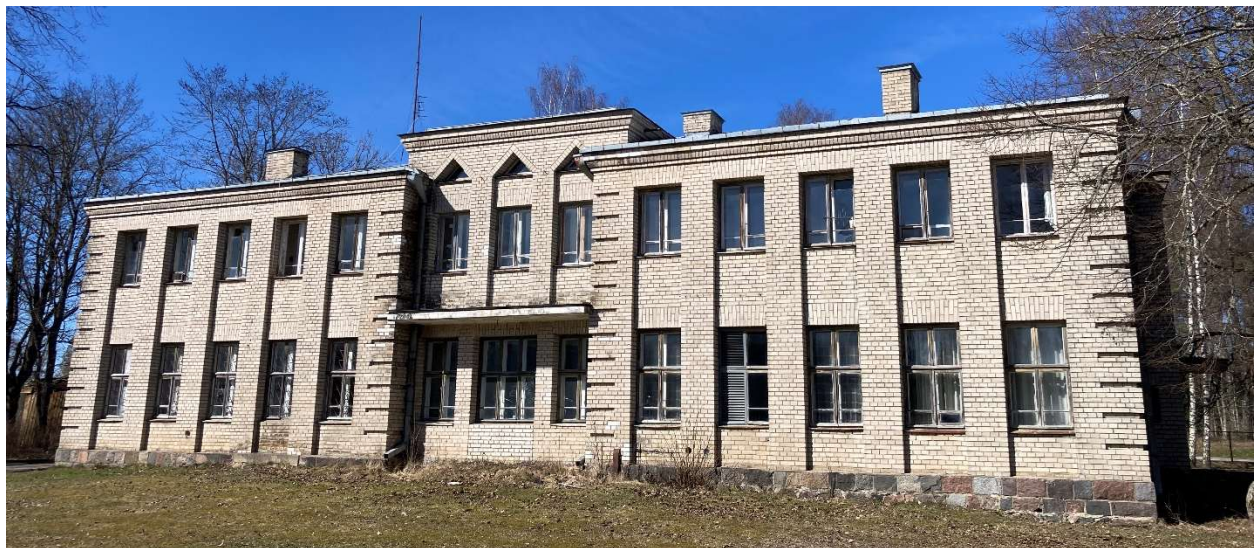
Foto 9 Peahoone raudteepoolne fassaad
