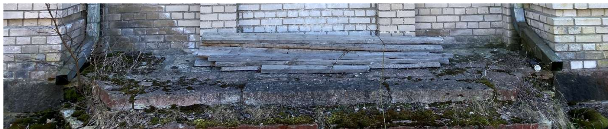
Foto 46 Hoone Jaama tn küljel on sissepääsu trepp paremini säilinud kui vastasküljel.
