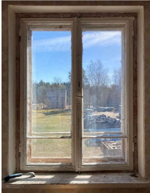
Foto 23 II-korruse aken. Näha on ka lai ja paks aknalaud
