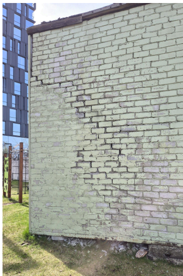
ill 52 Hoone ida küljes on näha tõenäoliselt nõukogude ajal sinna ehitatud tellisseina. Selle asemel peaks olema sarnane viisnurkne laiendus, nagu hoone lääne küljel. Tellisseinas on märgata suuri pragusid ja värvi koorumist.
