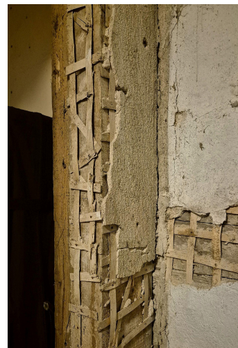
ill 114: enne parandamist tasub teha seina kihistuste uuring ja see dokumenteerida. Väärtuslikuks tunnistatud krohvikihit kannab endas ajaloolist väärtust ja tuleb kindlasti näidisenä eksponeerida.
