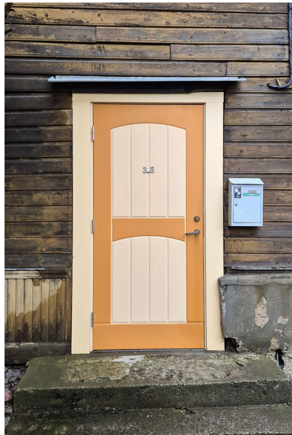
ill 93: Originaal puituks on välja vahetatud metallukse vastu.
