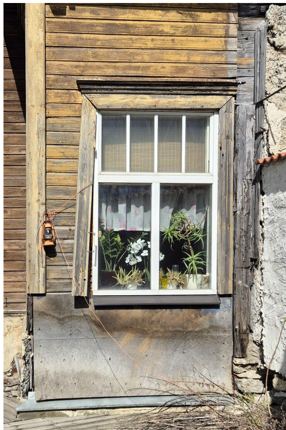
ill 63: Vana puitaken on vahetatud plastikakna vastu välja.
