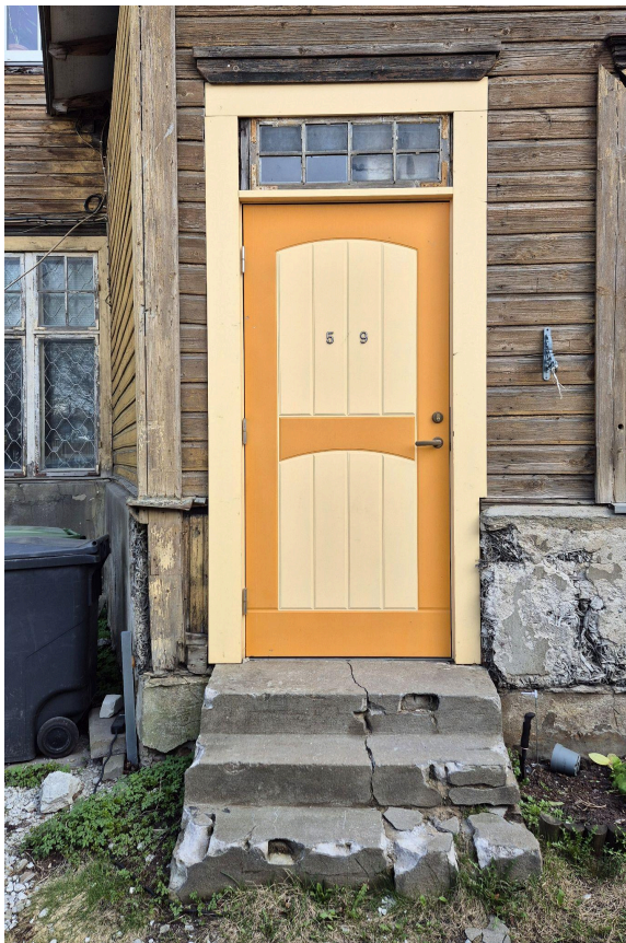
ill 92: Originaal puituks on välja vahetatud metallukse vastu. Säilinud on valgmikuaken.
