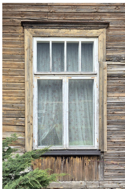
ill 60: Pildil nähtuv aken ja seda ümbritsevad liistud on selgelt paremas olukorras, kui hoone nurgas asetsev aken. Siiski on ka siin märgata värvi koorumist. Paremal pool asetsev akna ääris on kokku ehitatud kahest jupist. Akna all asetsev veelaud on sinna lisatud hilisemas etapis.
