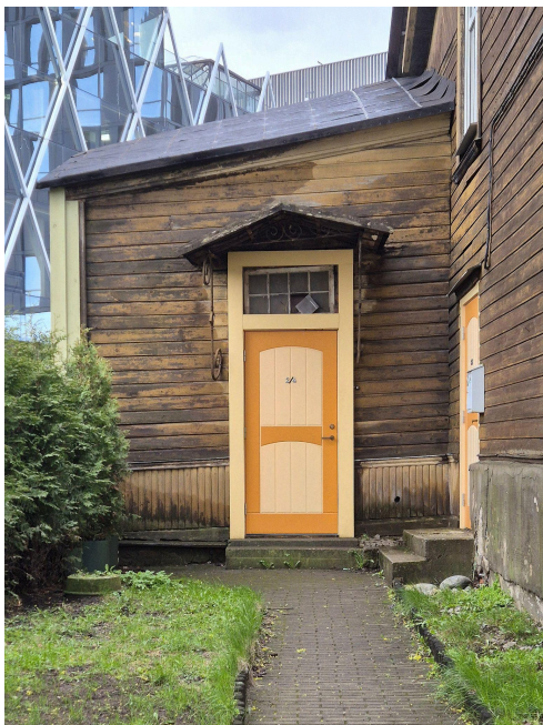
ill 88: Originaal puituks on välja vahetatud metallukse vastu. Säilinud on valgmiikuaken ja sepiastatud varikatus.
