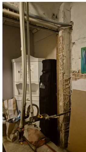
ill 115: Krohvi taastamisel on soovitatav kasutada lubimörti. Ka lõplik viimistlus on soovitatav teostada lubimördiga.
