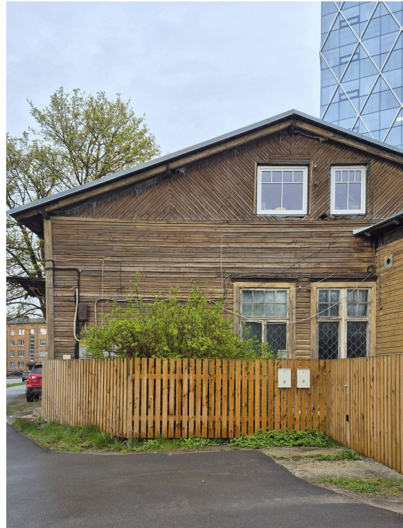
ill 69: Ülemised puitaknad on asendatud plastikakendega
