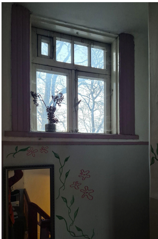
ill 85: Koridoris paiknev puitaken, millel on säilinud ka algupäraseid kremoonid
