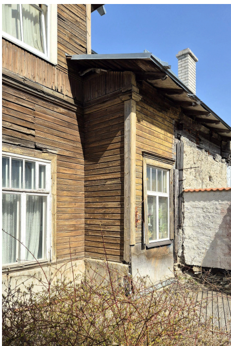
ill 23: Puuduliku vihmaveesüsteemi tõttu voolab vihmavetsi katuselt otse alla ja pritsib vastu seina, tekitades pikaajalist niiskuskoormust.
