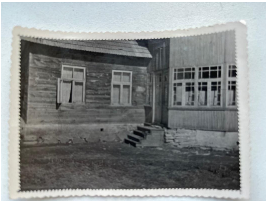
Lisa 25. Vanad aknad, fasaad ja katuseserv
