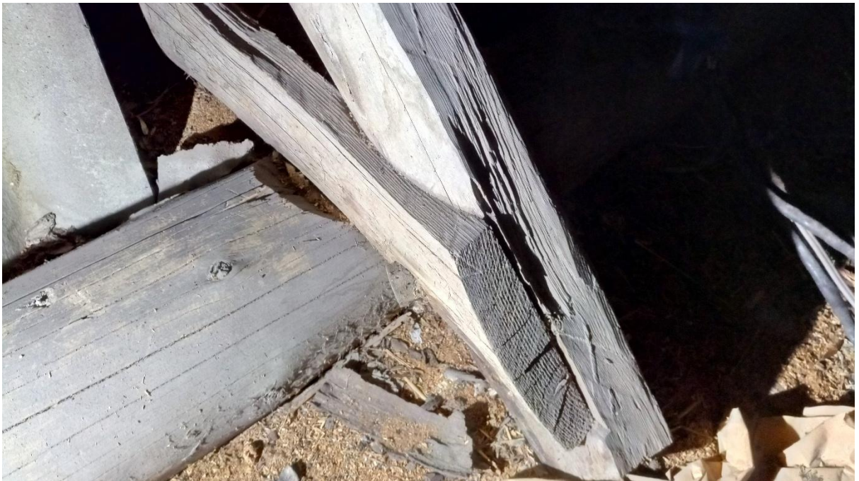
22. Ärklikorruse laetala ja ülemise palgirea ning poolsarika liitekoht puupunniga
