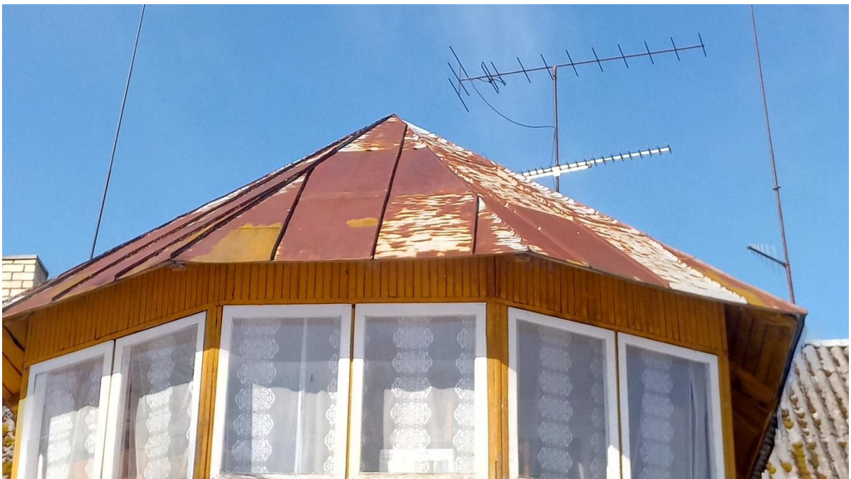
18. Hoone chitusaegne veranda valtsplekk-katus
