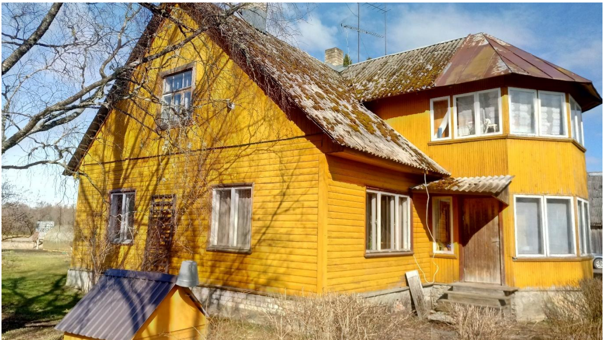
10. Lõunakülg, ärkliaken ja ärklikorruse fasaadi vertikaalselt kattev täispunn laudis
