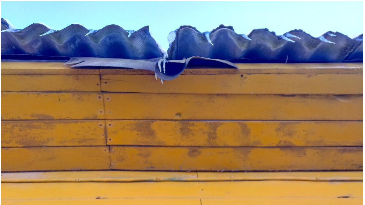
17. Katkine räästas ja kahjustunud tuulekastilauad
