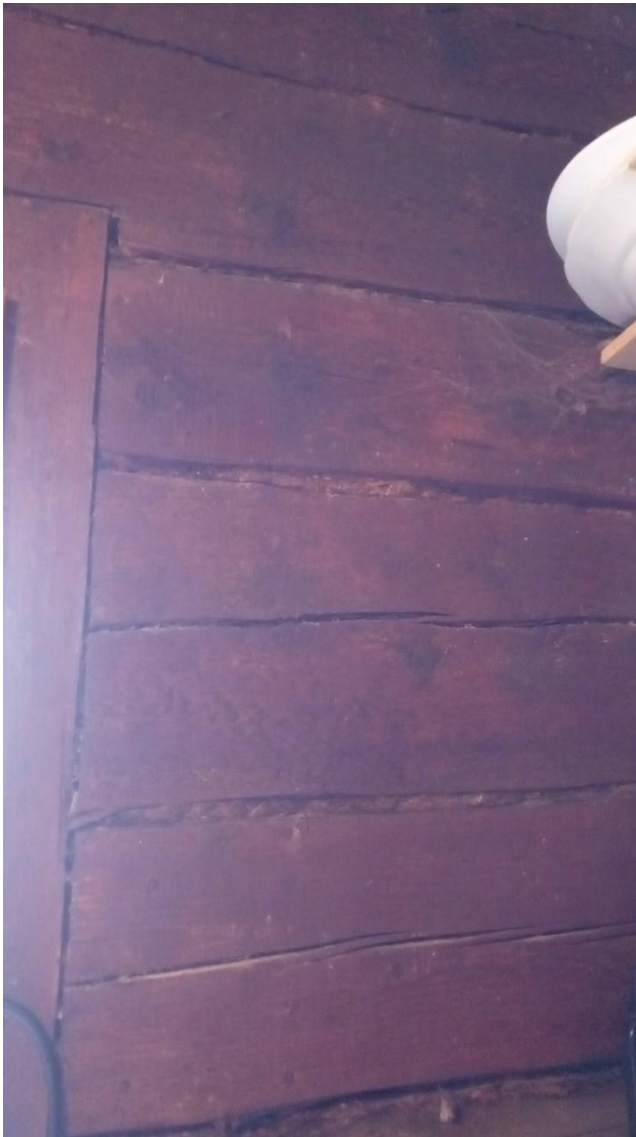
37. Sahnri ilma katteta vana originaal palksein ja akna tenderpost
