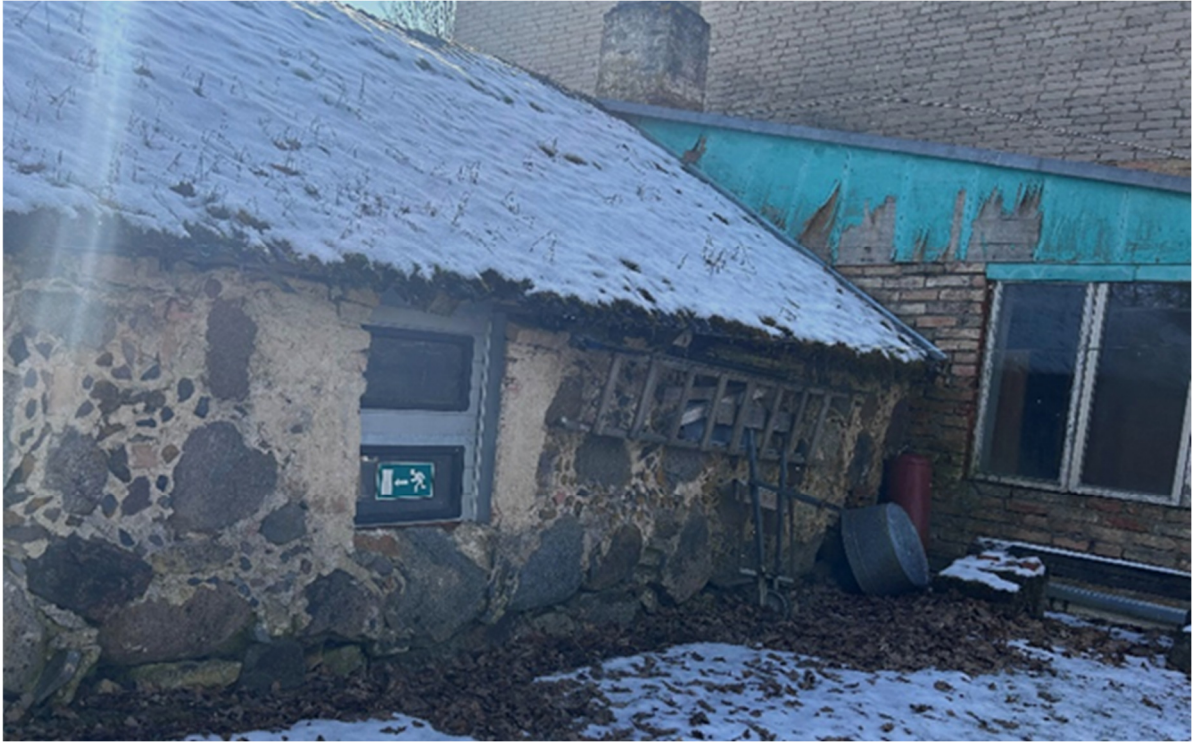
Pilt 11: Vaade põhjakülje maakivimüüritisest, milles on tekkinud aja jooksul välja vajumine. Foto: K. Saarse 19.12.2024
