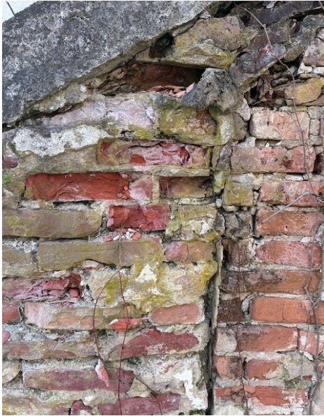
Pilt 13 ja 14: Näiteid asukohtades, kus tellispinnad on liigselt lagunenud ja tuleb teostada asendus. Foto: K. Saarse 19.12.2024
