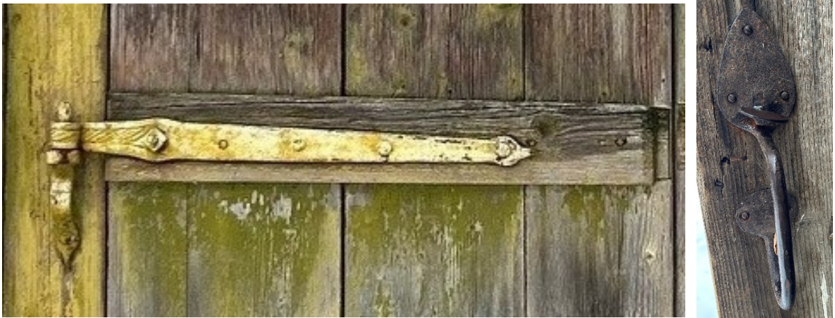
Pilt 23 ja 24: Säilinud furnituur, millest peaks eeskju võtta restaureerimistöodel. Foto: K. Saarse kevad 2025.
