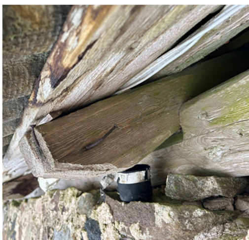
Pilt 17: Põhjapoolsel küljel säilinud sarikad koos müürilatiga. Foto: K. Saarse 19.12.2024
