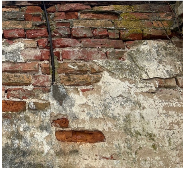
Pilt 13 ja 14: Näiteid asukohtades, kus tellispinnad on liigselt lagunenud ja tuleb teostada asendus. Foto: K. Saarse 19.12.2024
