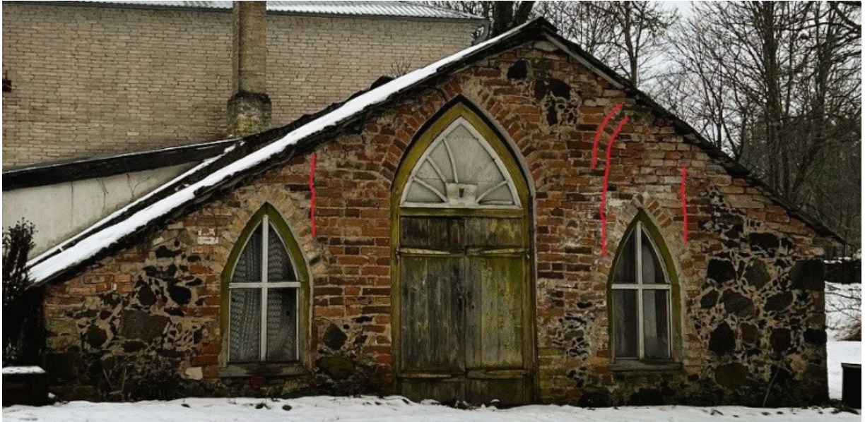
Pilt 12 : Idaküljel asuvad aknaavad. Markeeritud algse ava asukoht ja kõrgus. Foto: K. Saarse 19.12.2024
