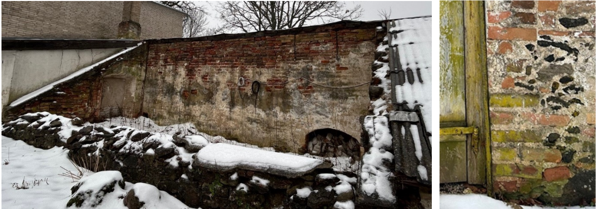
Pilt 8 ja 9: Müüritisseinte kahjustused, mis on tekkinud liigniiskusest ja orgaanikast. Foto. K. Saarse 19.12.2024
