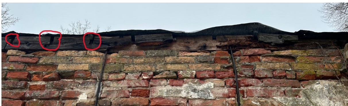
Pilt 16: Lõunapoolsel küljel säilinud katusetala. Foto: K. Saarse 19.12.2024
