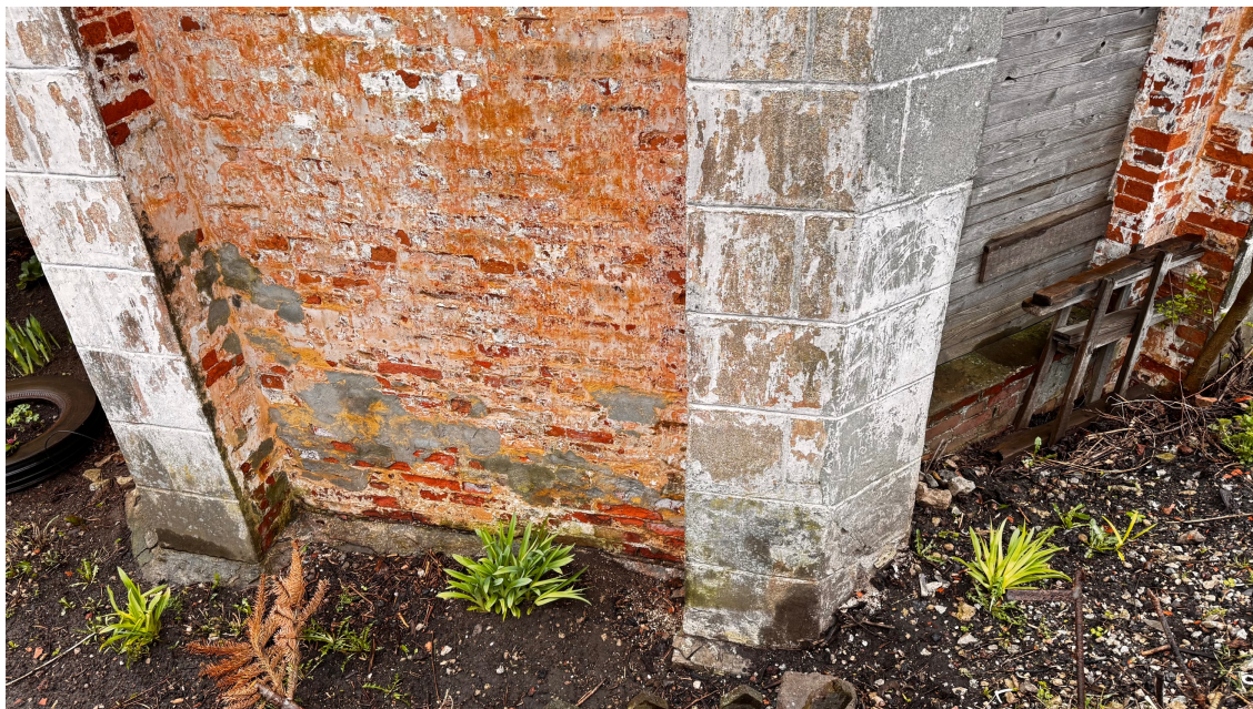
Foto 11. Pinnase kuhjumine müüride lähedale. Niiskus pääseb kaitsmata müüridele ligi.
