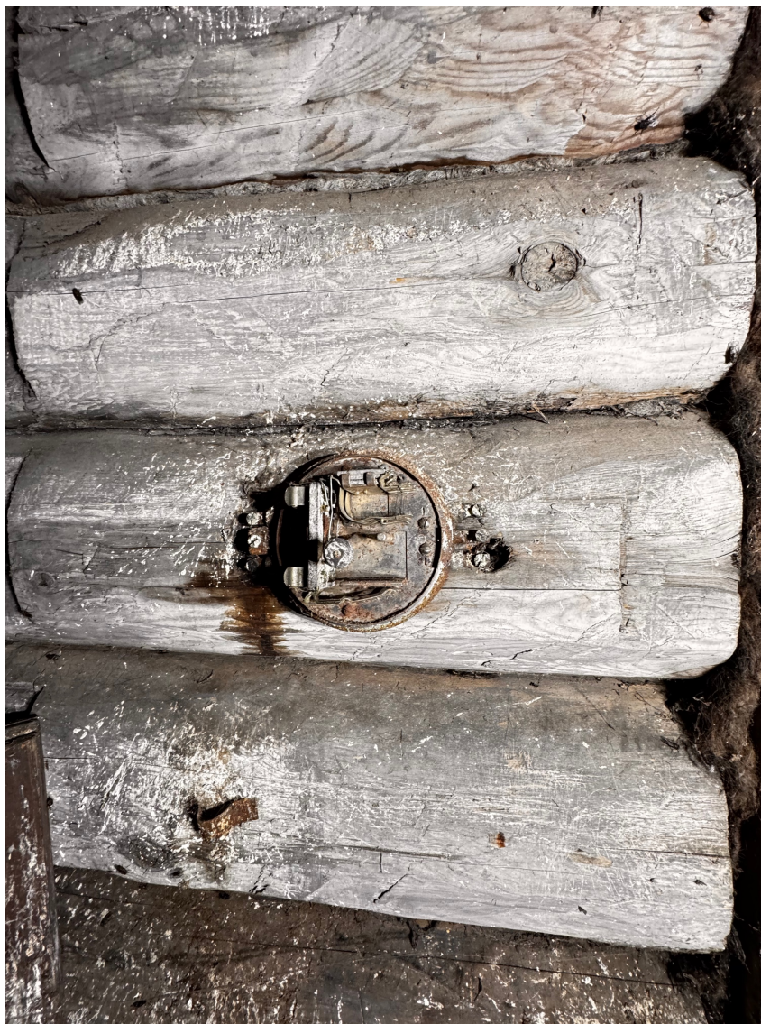
Foto 39. Ilmastiku mõjul pleekinud palksein.
