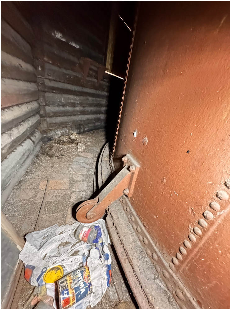
Foto 51. Käiguruum kolmandal korrusel mahutite ja seina vahel. Mahuti kaetud kruntvärviga.
