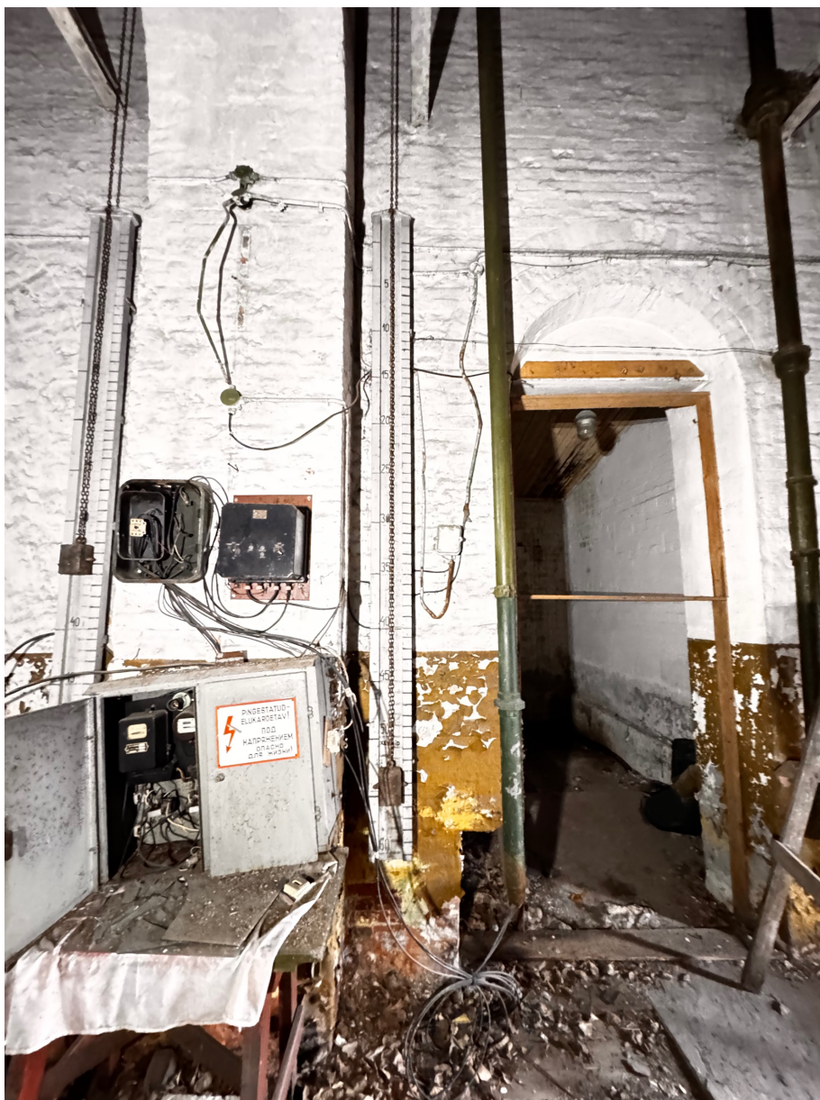
Foto 55. Veetaset mahutites näitavad puidust mõõdikud
