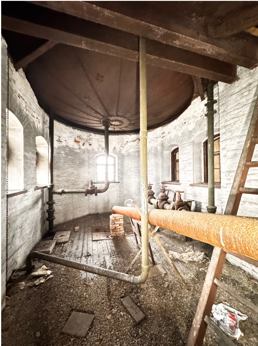
Foto 50. Vaade idapoolse mahuti suunas. Teise korruse põrand on kaetud lindude väljaheidetega. Mahuti lähedal müüri ülemises servas on märgata niiskuskahjustusi.
