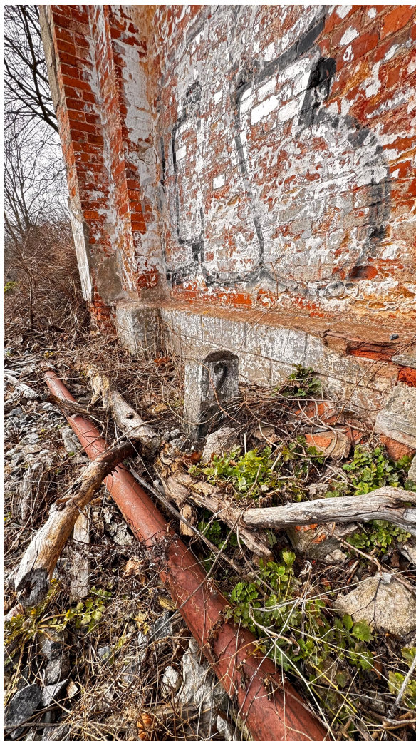
Foto 16. Ja 17. Vundamendilt irdunud krohvikihhi alt paljastub kahjustunud müüritis.
