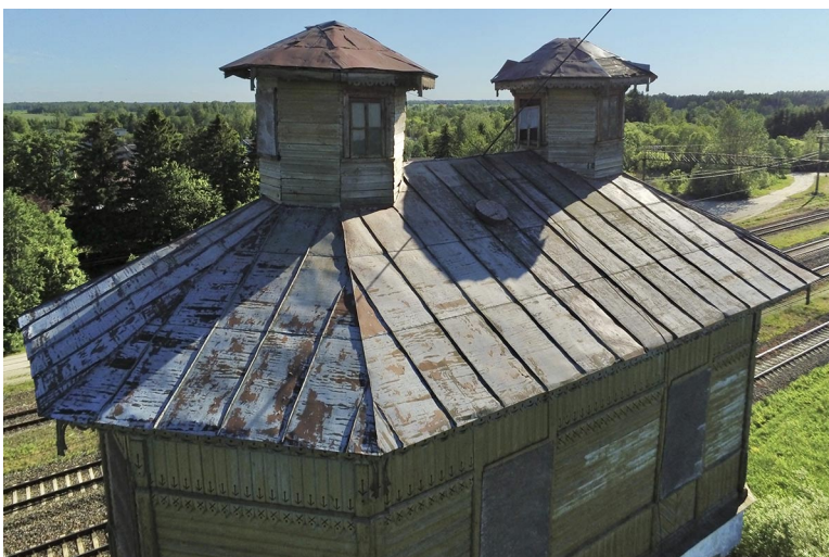
Foto 10. Raasiku torni katuse ventilatsiooni pealisehtis
