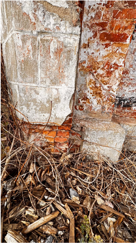
Foto 25. Alumisest otsast lagunenud nurgakvaader.
