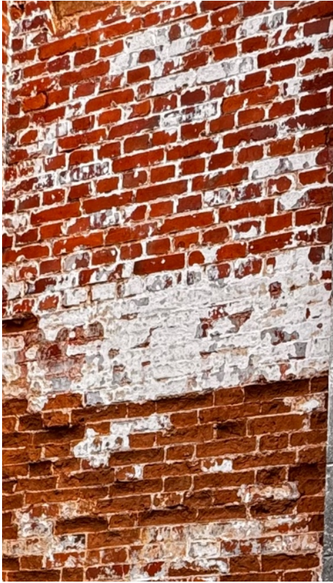
Foto 20. Kahjustunud müüri osa sussex laotis ja ülemine ristseotisega laotis (iga teine rida on seotud).
