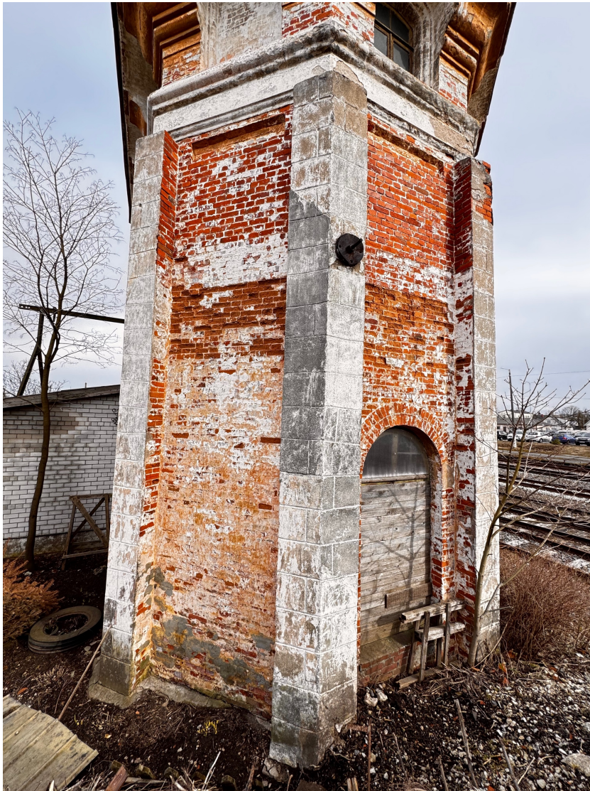
foto 19. Kahjustunud seinaosa selgelt eristumas. (Pildil tumepruunid tellised)
