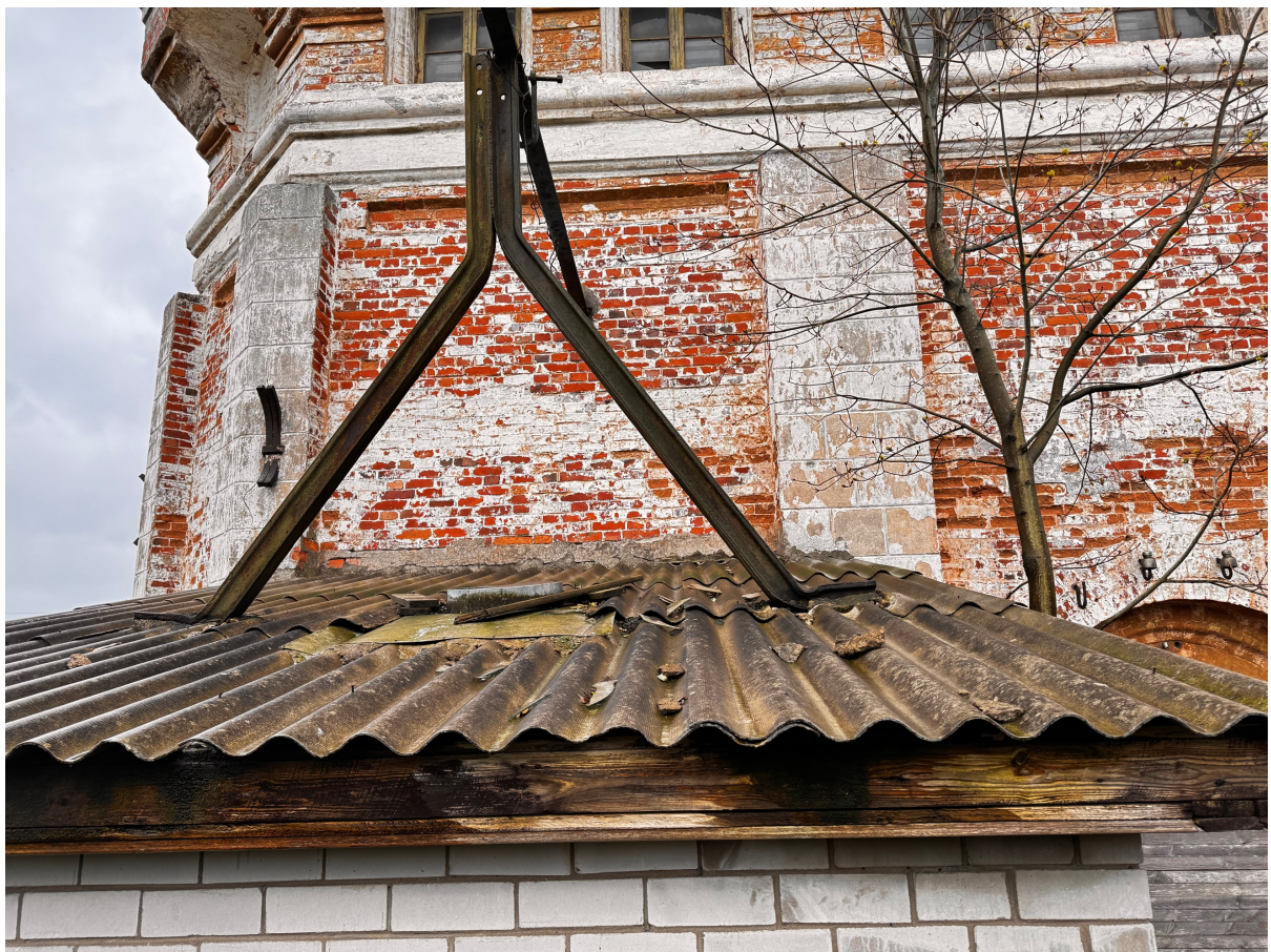
Foto 30. Juurdeehituse katusel paiknev kitsarööpmelise raudtee relssidest ehitatud seadeldis.
