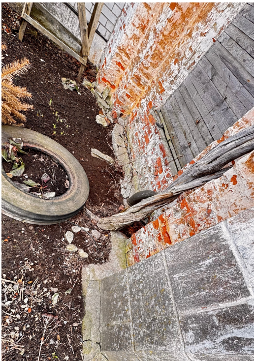
Foto 27. Puud vundamendile liiga lähedal.
