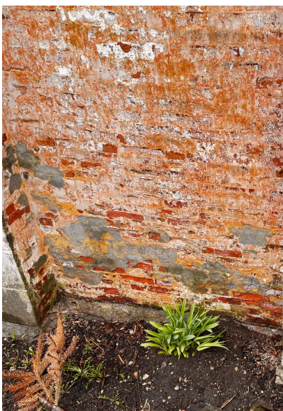
Foto 21. Ja 22. Tsementmördiga tehtud parandused
