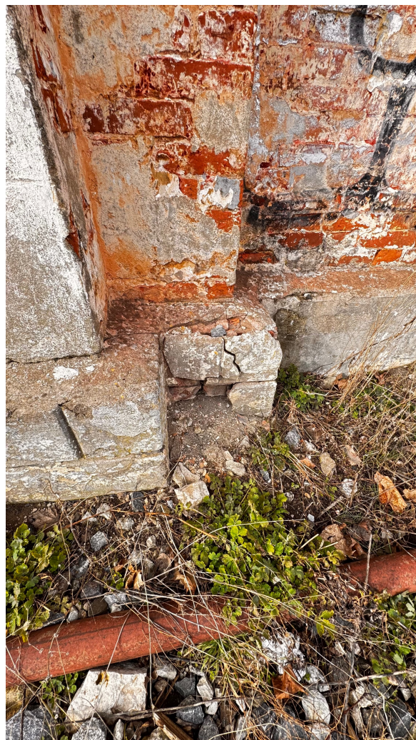
Foto 16. Ja 17. Vundamendilt irdunud krohvikihhi alt paljastub kahjustunud müüritis.
