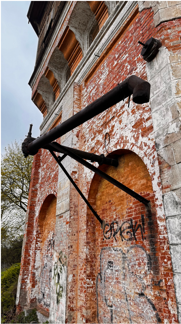
Foto 56. Veetorni põhifunktsiooni täitev veetoru.
