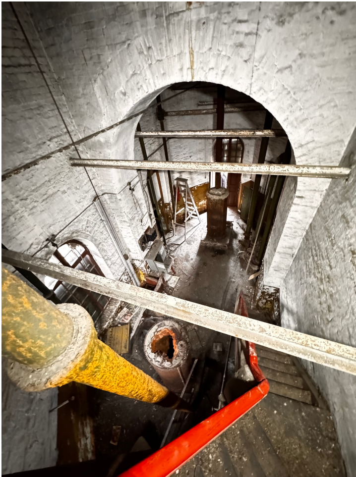
Foto 47. Hoone keskelt läbiv võlvkaar ja raudteerelssidest tõmbid
