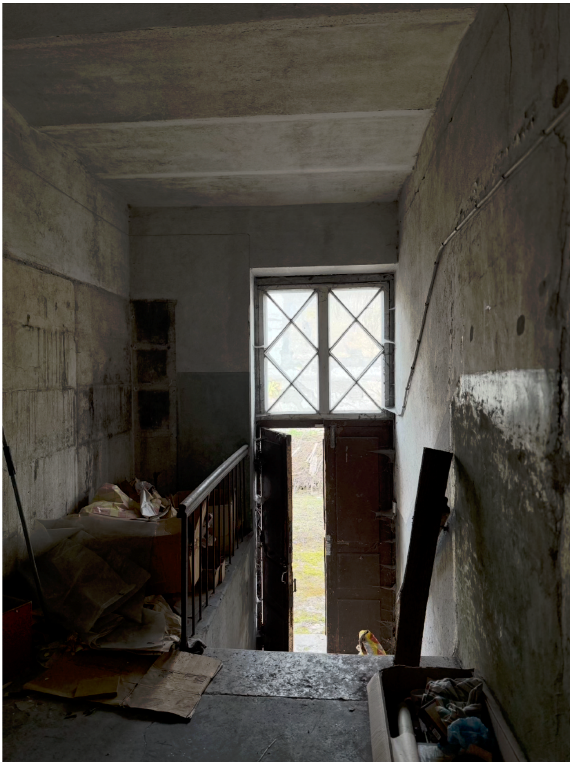
19. Vaade välisuksele ja völvlagedele õue suunas.
