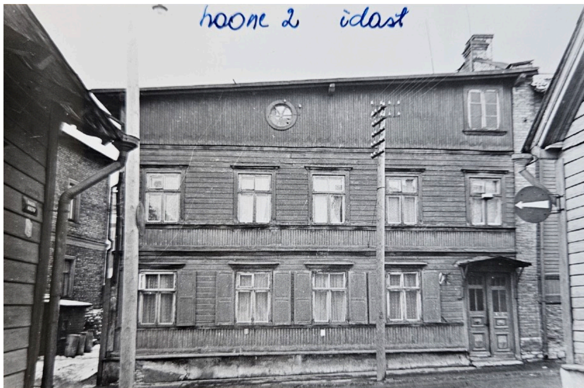
8. Lammutatud puithoone esifassaad vaadelduna Naeri tänavalt.
