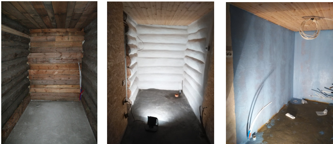
17. Vannituba on rajatud endisesse aganikku ja nõ tuba-tuppa meetodil, vasakult 1 ja 3 vaade idapoolsesse ruumiossa, 2 foto on vaatega läände- krohvitud ümarpalk ja veekontakt seinaga puudub
