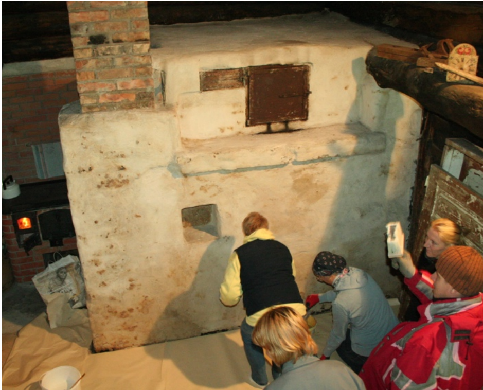
13. Reheahju ühisvõõpamine Eesti Vabaõhumuuseumi korraldatud koolituse “Viimistlus: värvid ja värvikeetmine” Jüri Kuusmann juhendamisel septembris 2012 26
