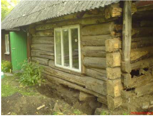
9. Hoone kagunurk laudise eemaldamisel ning palgivahtetusel (vt ill 6 elamu plaanil 7 ja 8 vahel)
