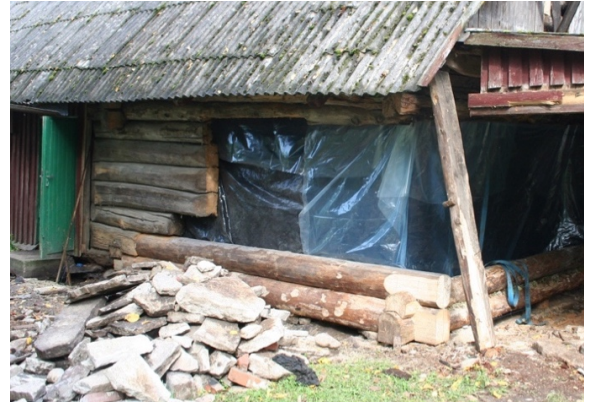
9. Hoone kagunurk laudise eemaldamisel ning palgivahtetusel (vt ill 6 elamu plaanil 7 ja 8 vahel)
