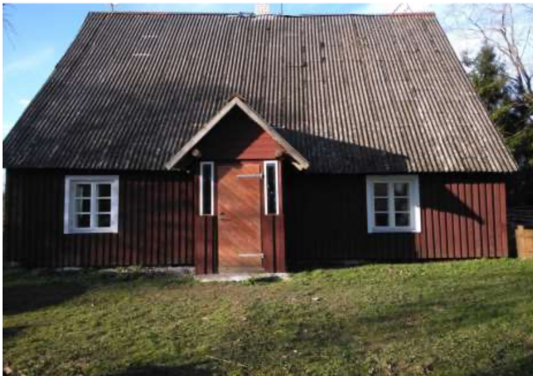
18. Ülase talu eluhoone peale suuremaid renoveerimistöid
