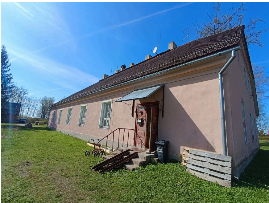
Joonis 7. Hoone lõunaküljel algne peasissepääs, mille ees oli kunagi veranda.
