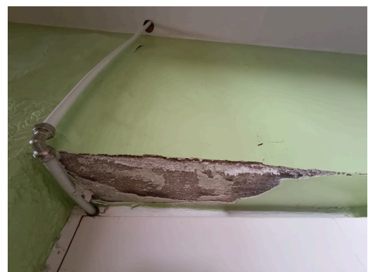
Joonis 13. Koos krohviga koorunud viimistluskiht
