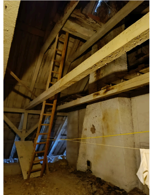
Joonis 28. Pööningul näha olev mantelkorsten
