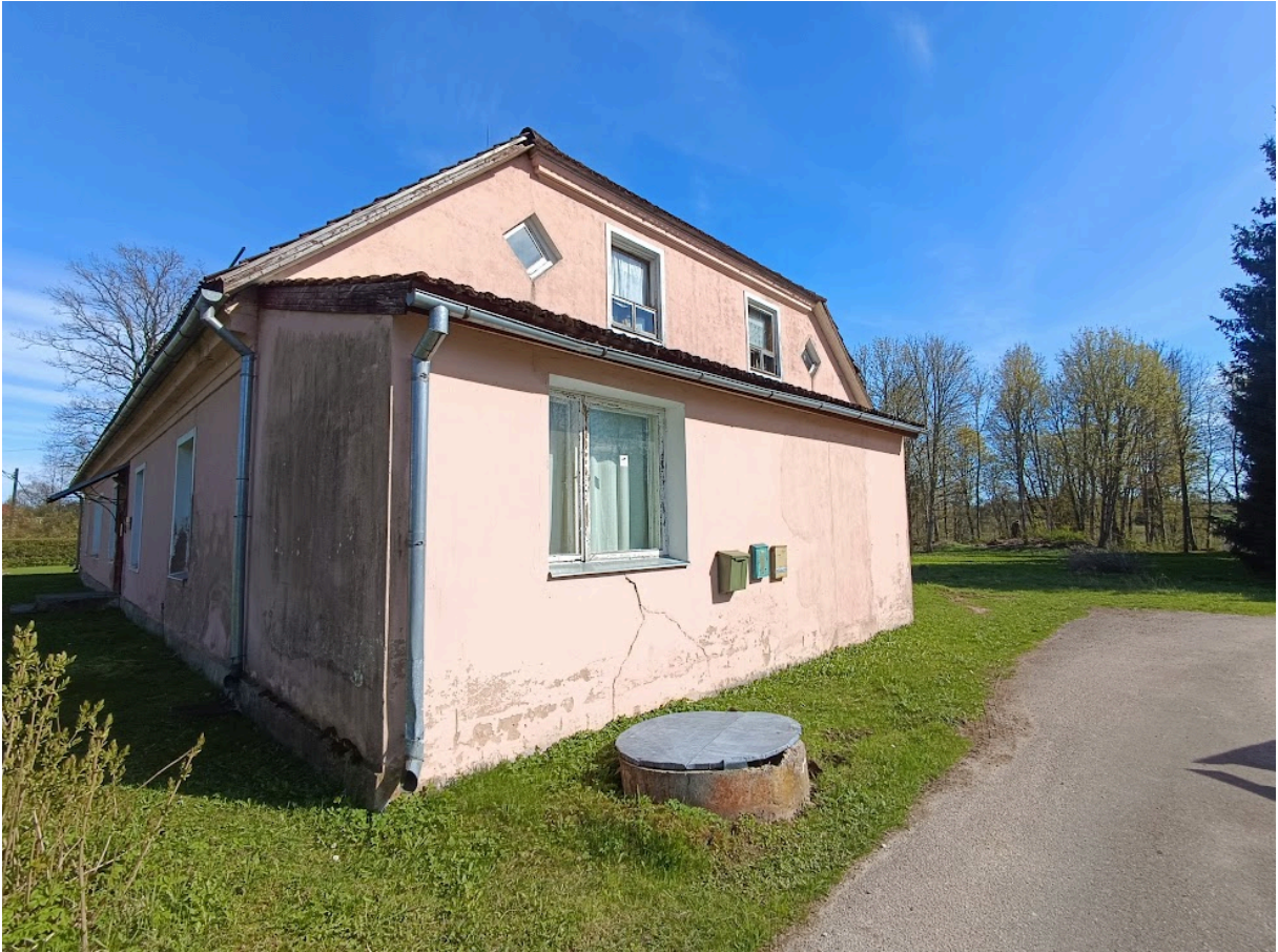
Joonis 10. Vundamendi vajumisest seintesse tekkinud praod
