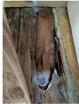
Joonis 17. Mädanenud põrandalaud
