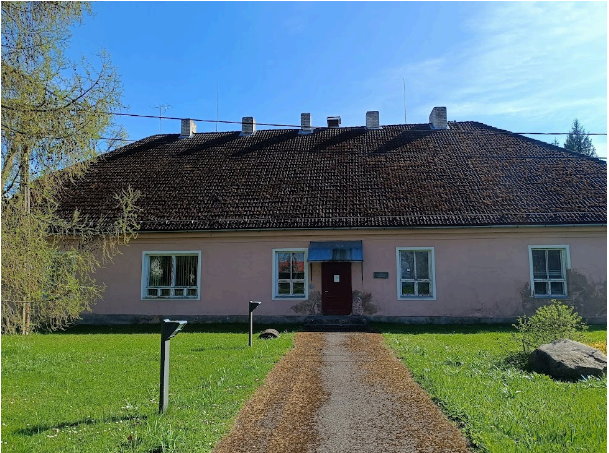
Joonis 19. Visuaalselt hinnatud katus, sammaldunud põhjapoolne külg
