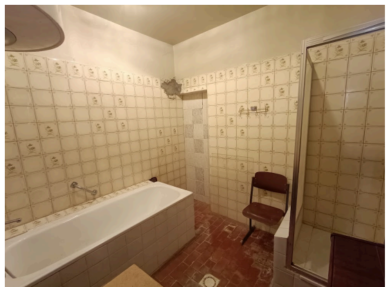
Joonis 33. Vannitoaks ehitatud tuba
