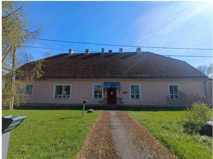
Joonis 21. Fassaadi põhjapoolne vaade
