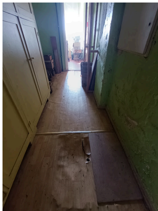
Joonis 15. Sisse vajunud põrand läänepoolses maja otsas
