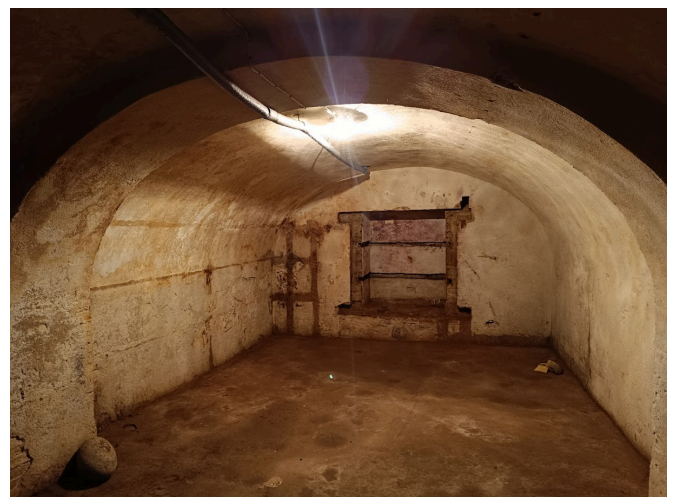
Joonis 29. Vaade keldrile
