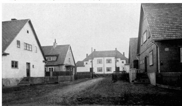
162. E. Habermann. Ehituslaenuka ehitatud majad Tallinnas Vaikse tänaval, 1925 Eugen Habermann. Dwellings built on the home loan programme in Vaikne Street, Tallinn, 1925
