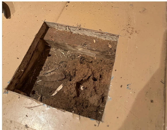
24) Hoone kirdenurgas asuva I korruse puitpõrandasse tehtud avang. Mai, 2025
