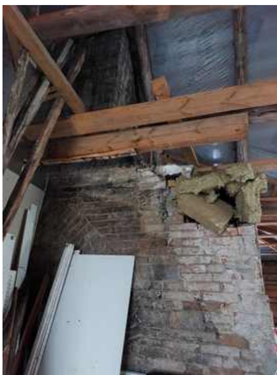
51-52. Püskorstna haru 1. korrusel ja pööningul. Teine haru jääb sümmeetriliselt Suur-Mere 11 majapoolde.
