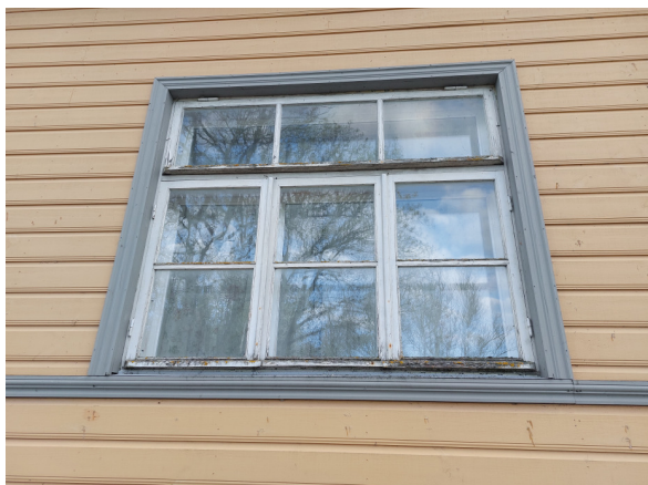
55-56. Vasakul tänavapoolne (idakülg), paremal hoovipoolne (läänekülg) aken. Aknad on renoveeritud 19. aastat tagasi ja vajavad uuesti renoveerimist. Rohkem on kannatada saanud hoovipoolne aken, mis jääb päikese kätte.
