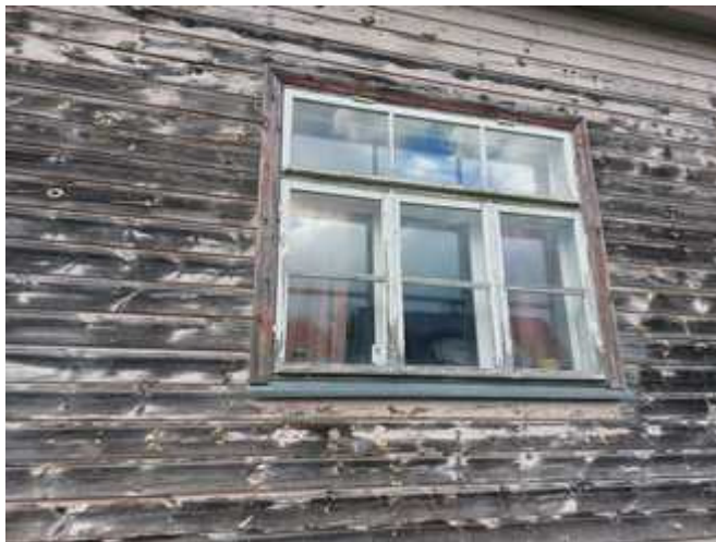
44. Kahjustatud läänesein. Värv on irdunud ja päike on ka juba lõhestanud puidupinda.
