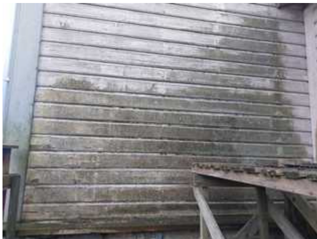
42-43. Sammaldunud välissein elamu tänavapoolses põhjapoolses nurgas. Parempoolsel pildil on sammal juba osaliselt eemaldatud samblaeeemaldajaga. Laudis on vahendiga üle pritsitud ning nädala pärast kuivanud sammal harjaga maha pühitud.
