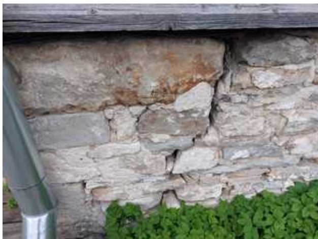
33-34. Hoone väljavajunud vundamendi nurgad hoovi- ja tänavapool
