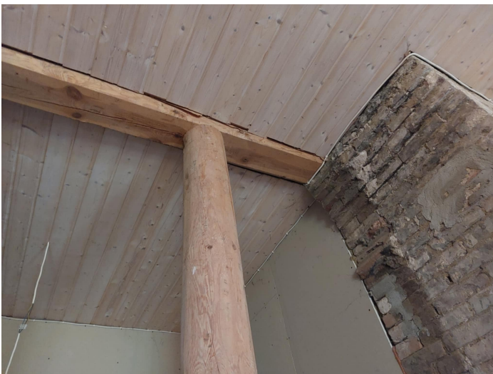
58. Tala ja puitpost 1. korrusel
