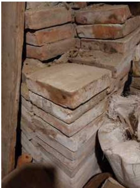
38. Keldripõrandal olnud tellisplaadid, mis on kavas tagasi oma asukohta paigaldada. Samasugused plaadid on ka teise majapoole keldris põrandal mõnes ruumis.
