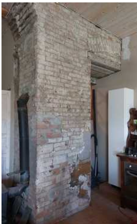
51-52. Püskorstna haru 1. korrusel ja pööningul. Teine haru jääb sümmeetriliselt Suur-Mere 11 majapoolde.
