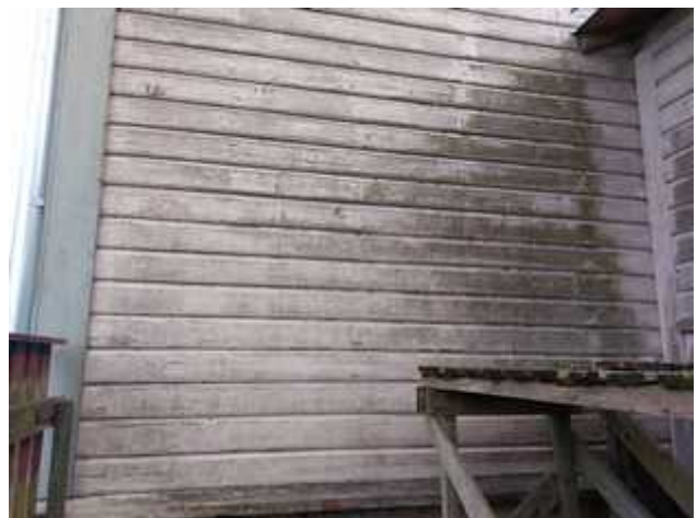
42-43. Sammaldunud välissein elamu tänavapoolses põhjapoolses nurgas. Parempoolsel pildil on sammal juba osaliselt eemaldatud samblaeeemaldajaga. Laudis on vahendiga üle pritsitud ning nädala pärast kuivanud sammal harjaga maha pühitud.
