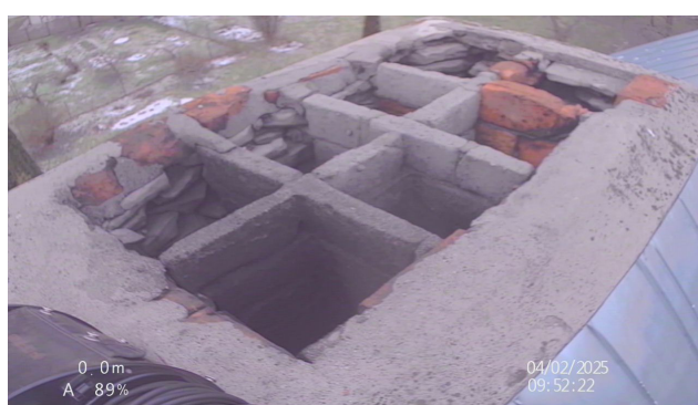
51-52. Püskorstna haru 1. korrusel ja pööningul. Teine haru jääb sümmeetriliselt Suur-Mere 11 majapoolde.
