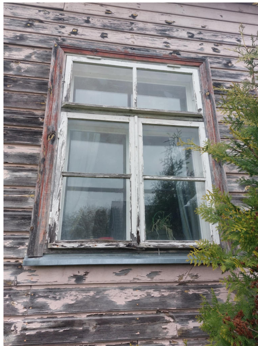
55-56. Vasakul tänavapoolne (idakülg), paremal hoovipoolne (läänekülg) aken. Aknad on renoveeritud 19. aastat tagasi ja vajavad uuesti renoveerimist. Rohkem on kannatada saanud hoovipoolne aken, mis jääb päikese kätte.
