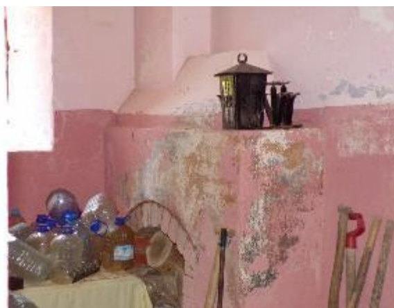
Joonis 36. Kaminaruumi kaminal on jäljed hallikasrohelistest alumisest värvikihist
