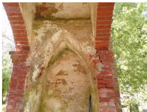
Joonis 24. Väravaaluse ruumi seinad ja lagi (autori foto).
