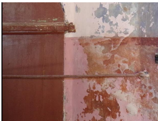
Joonis 29. Ukse seestpoolt kinnitamise haak (autori foto).
