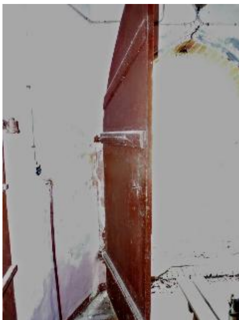
Joonis 27. Välisukse sisevaade (autori foto).
