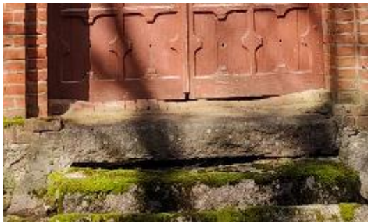
Joonis 18. Lõunapoolse ukse kulunud tellistest lävepakk (autori foto).
