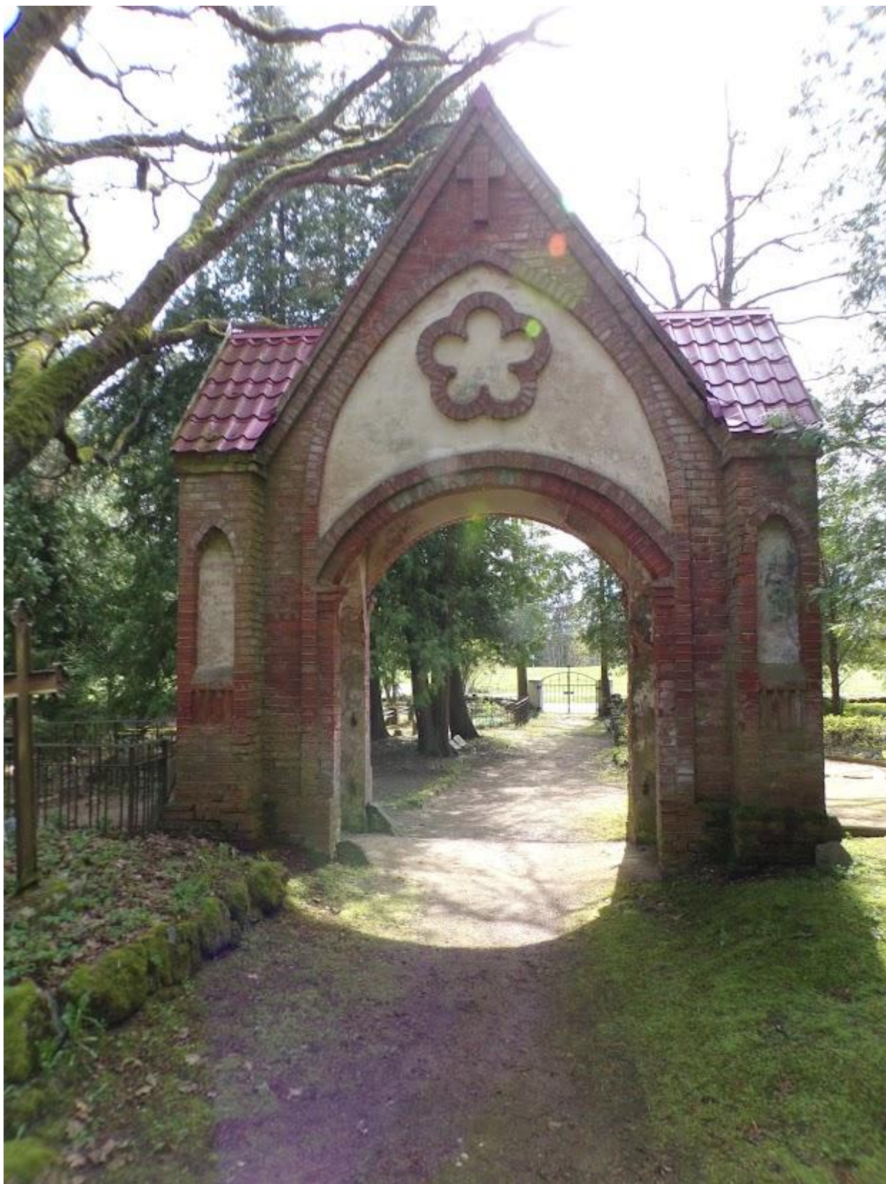
Joonis 43. Värava vaade põhja poolt (autori foto).
