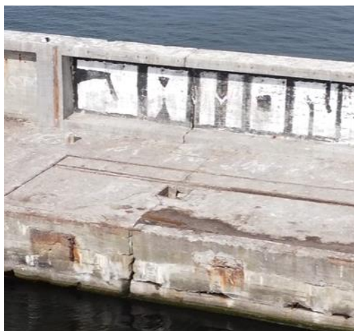
Foto 6, 7. Vaade kagust ja loodest. Piltidel nähtav kai tsentrit läbiv pragu. Autori fotod, Aprill 2025
