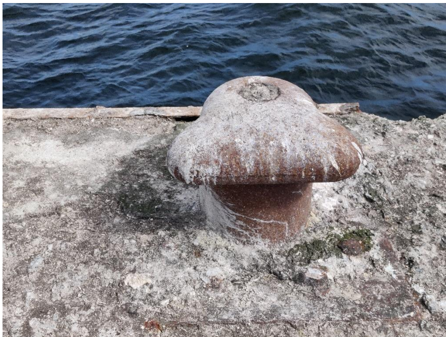
Foto 18. Üks kahest eelmainitud pollarist. Näha on betoonikahjustused mille tulemusena pollari ankurdusplaat on nähtav. Autori foto, Aprill 2025
