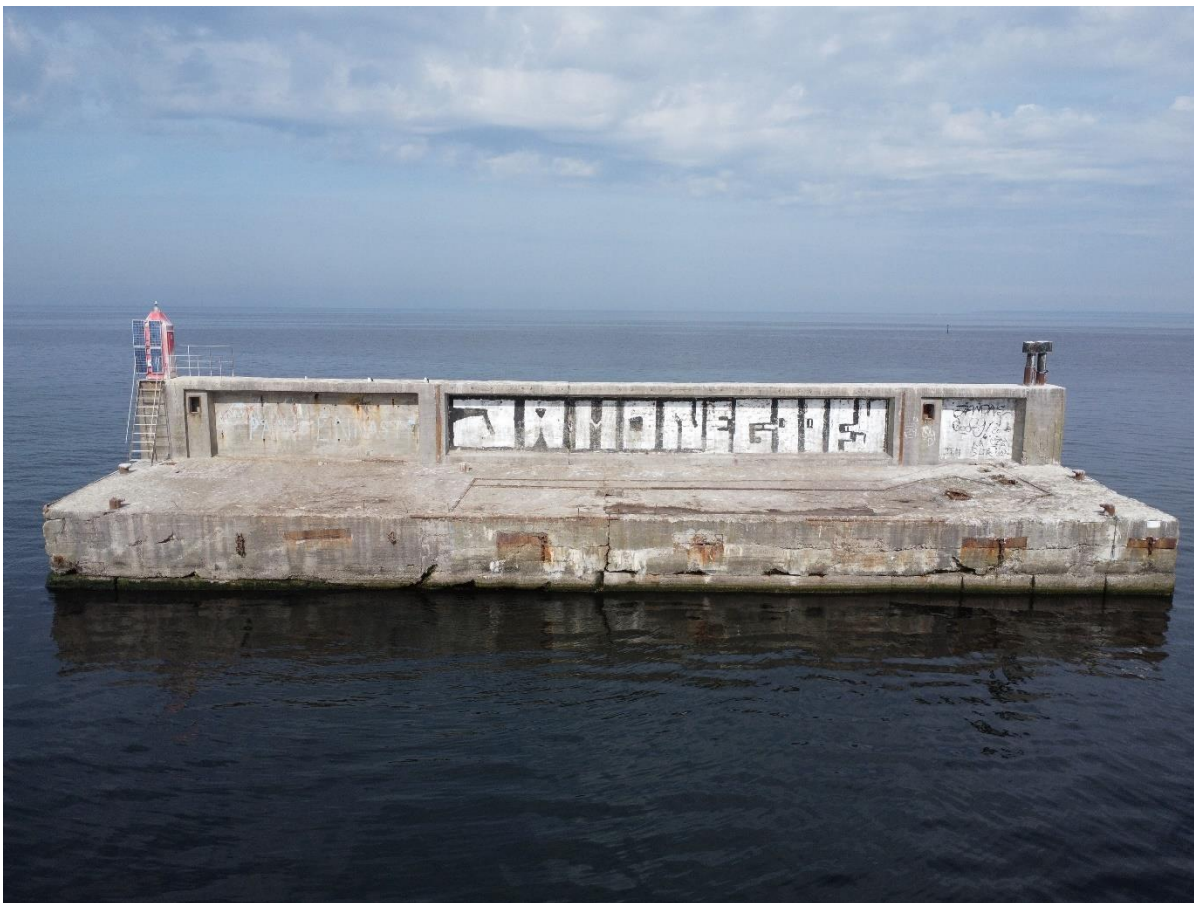
Foto 17. Vaade kagust (Pirita sadama poolt). Näha on olemasolevad viis vendriketti ning puudulike siluetid. Autori foto. Aprill 2025
