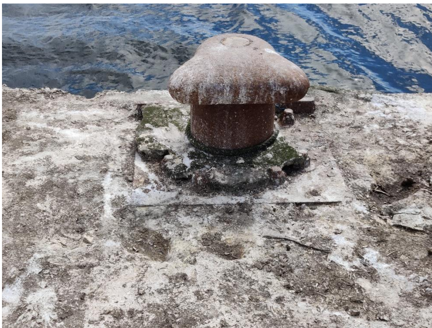
Foto 19. Üks kahest eelmainitud pollarist. Näha on laialdane betoonikahjustus mille tulemusena pollari ankurdusplaat on nähtav. Autori foto, Aprill 2025
