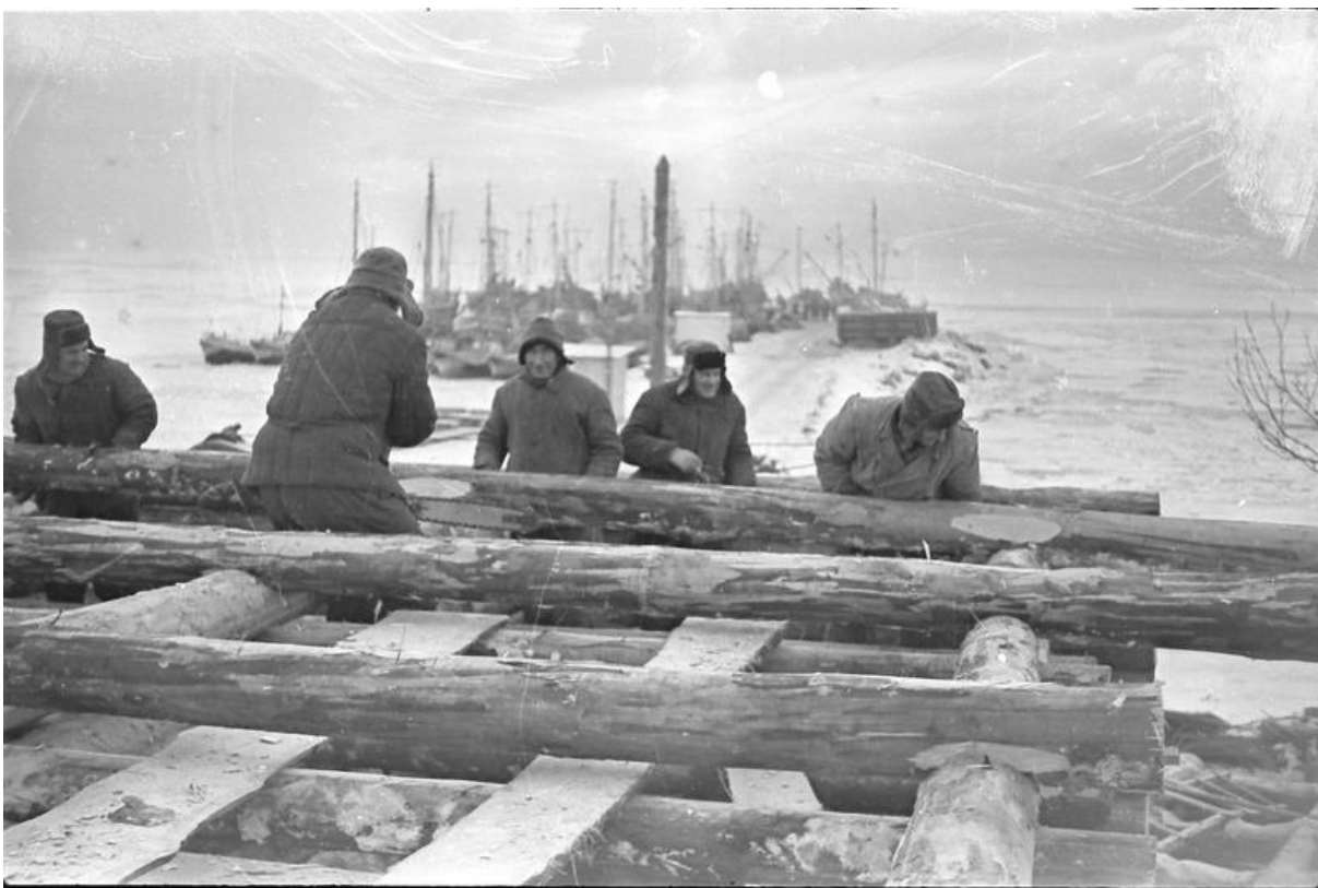
Foto 1. Kirovi kalurikolhoosi Miiduranna sadama ehitusel. Pildil näha kärgkastide ehitust 20
