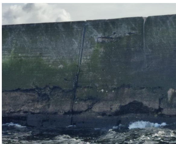
Foto 6, 7. Vaade kagust ja loodest. Piltidel nähtav kai tsentrit läbiv pragu. Autori fotod, Aprill 2025
