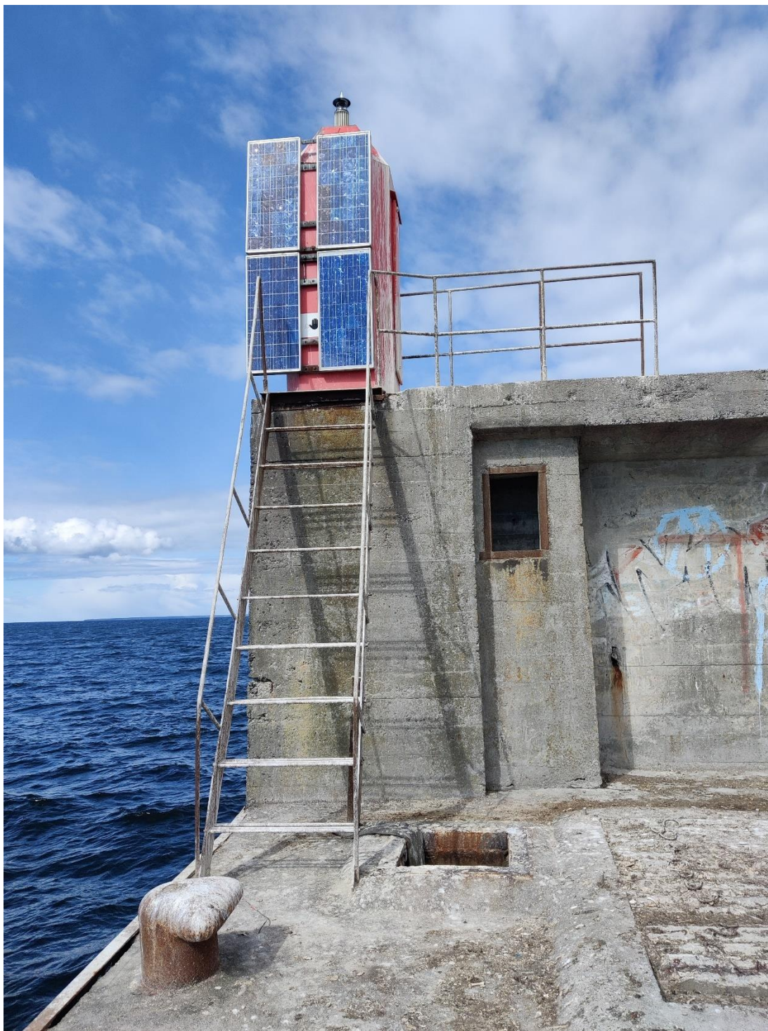
Foto 22. Vaade Tulepaagile ja redelile. Näha on veel metallpollarit ja ühe ruumi ligipääsu- ja teenindusluuki. Autori foto. Aprill 2025
