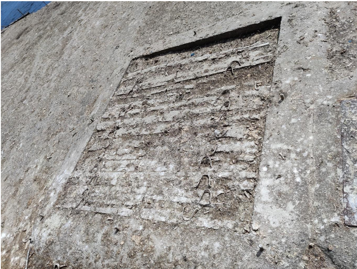
Foto 20. Tulepaagi poolse ruumi teenindusluuk, mis kaetud mustuse ja linnu väljaheidetega. Autori foto. Aprill 2025
