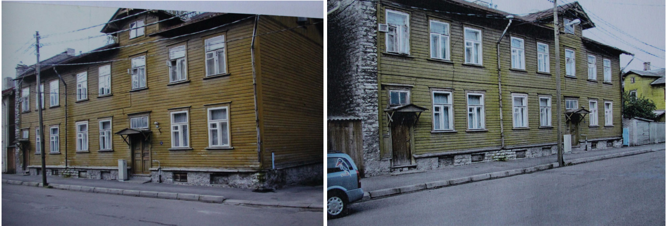
58–59. Õle 19/1 fassaadilahendus 2004. a fotodel. Autor Eeteprojekt OÜ.
