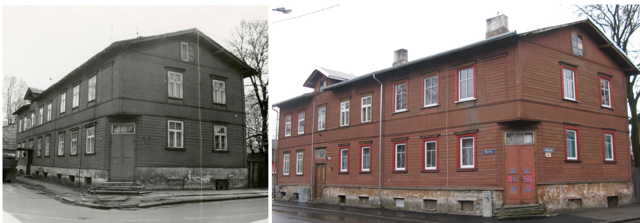
102–103. Rohu 31 fassaadilahendus 1987. a fotol. Autor Tenno, Ann. Rohu 31 fassaadilahendus 21.11.2011 fotol.
