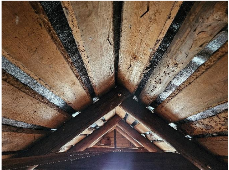
Foto 12. Pööning. Vasakul lahtine saepuru täide, paremal pööningu lagi. 13.04.2024
