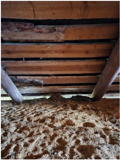
Foto 12. Pööning. Vasakul lahtine saepuru täide, paremal pööningu lagi. 13.04.2024
