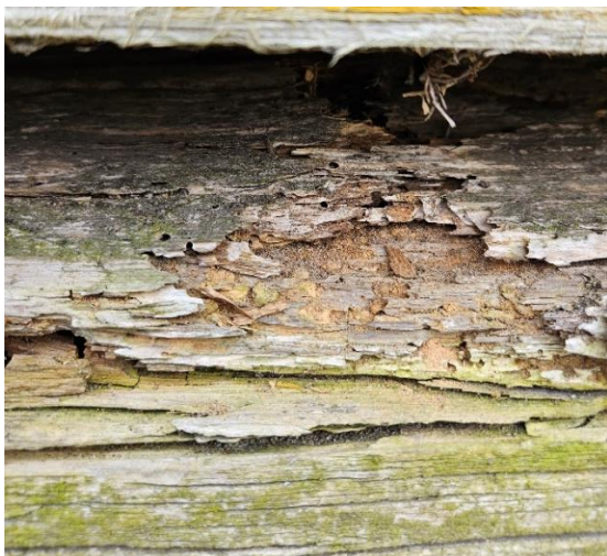
Foto 8. Näide hoone alumise palgi mädanemisest ja putukakahjustustest, 13.04.2024. Autori foto.
