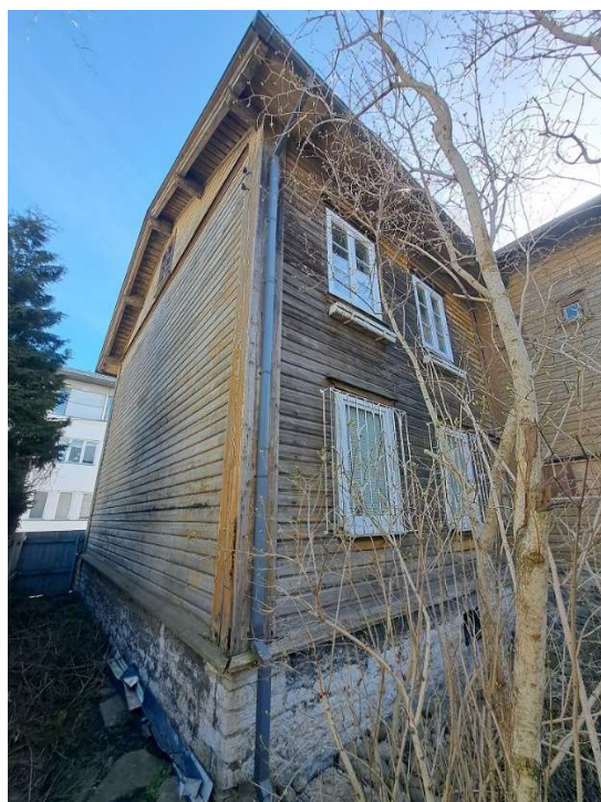
Joonis 19. Fassaadi nurga foto ja sadeveesüsteem
