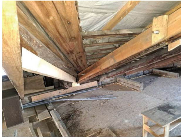
Joonis 43. Parandatud katuse konstruktsioonid
