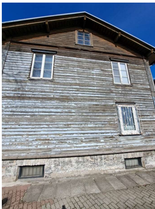
Joonis 15. Hoone fassaadi foto ja sillutisriba paekiviplaatidest
