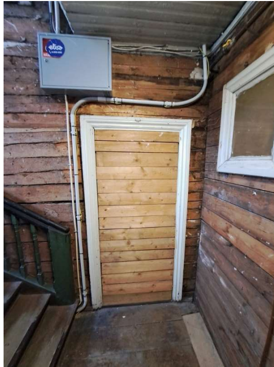
Joonis 34. Kinni ehitatud uks
