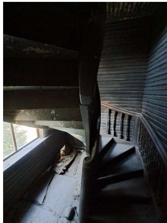
Joonis 35. Teine trepikoda. Puitkarkass- seinad.
