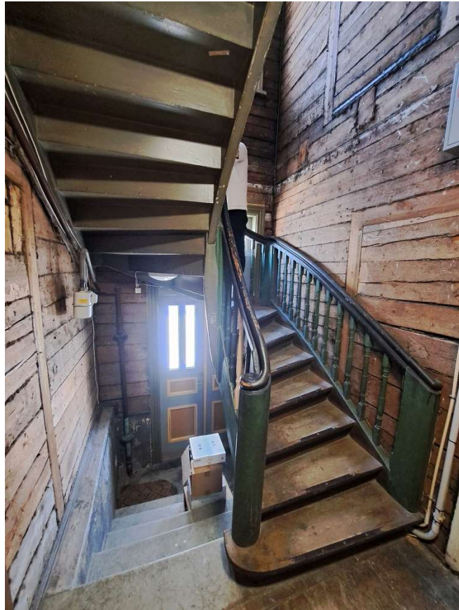
Joonis 28. Peatrepikoja 1. korrus foto
