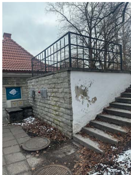
Foto 14. Betoonplaatidest sillutis (Allikas: autor)
