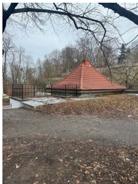
Foto 16. Betoonplaatidest sillutis (Allikas: autor)
