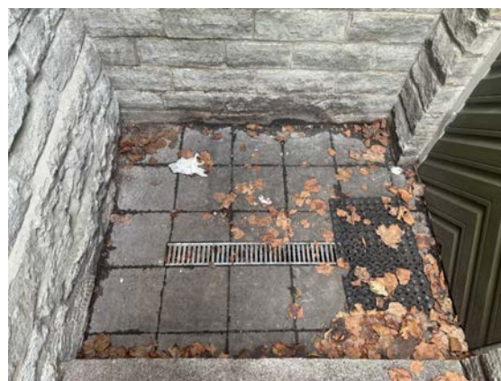
Foto 18. Lisatud vee äravoolutrapp (Allikas: autor)
