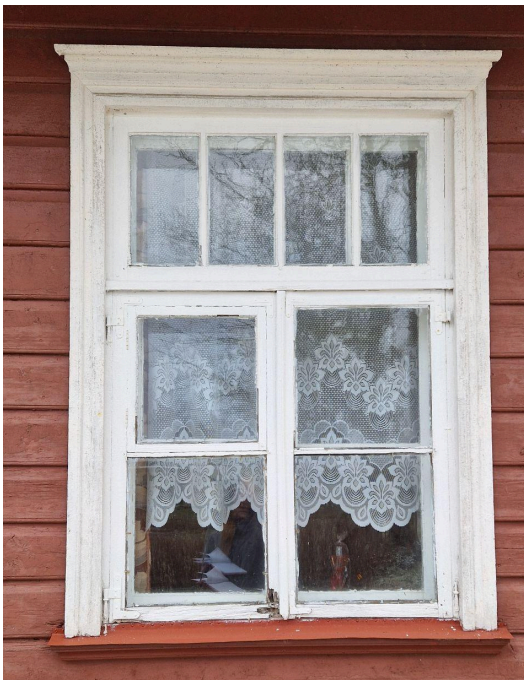
Foto 46. Lääne külje originaal topeltaken (A-2B). Foto 47. Ida külje originaal topeltaken (A-2) 03.2024. Allikas: autor.
