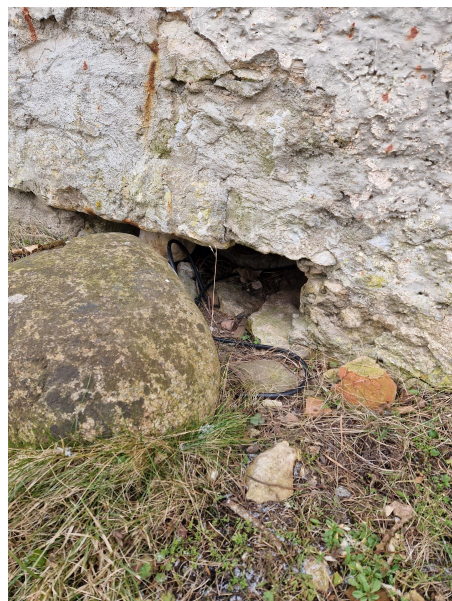
Foto 23. Vundamendi tuulutusaava. Foto 24. 2014 tehtud ava kaablitele. 03.2024. Allikas: autor.
