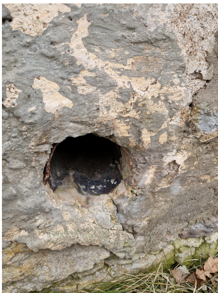
Foto 23. Vundamendi tuulutusaava. Foto 24. 2014 tehtud ava kaablitele. 03.2024. Allikas: autor.
