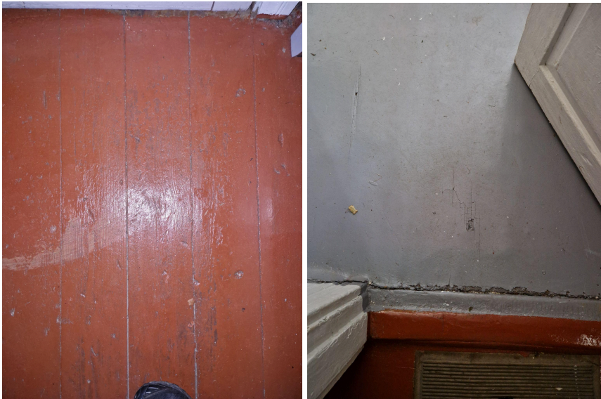
Fotod 76. Värvitud põranda laudis. Foto 77. Värvitud papp. 03.2024. Allikas: autor.
