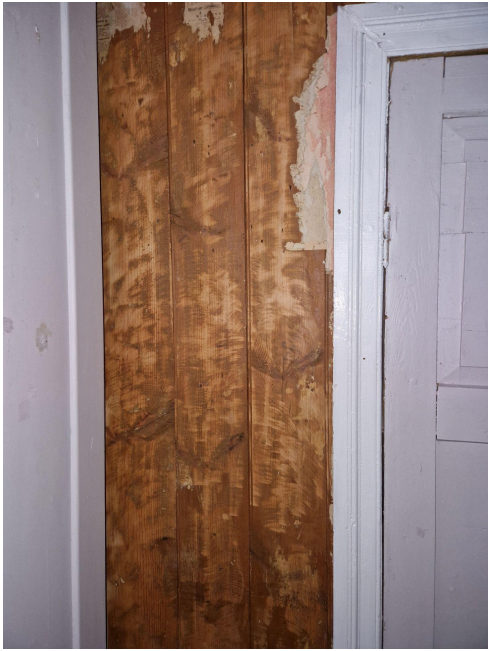
Foto 75. Palgi peal olev lai laudis, kus tapeet eemaldatud. 03.2024. Allikas: autor.
