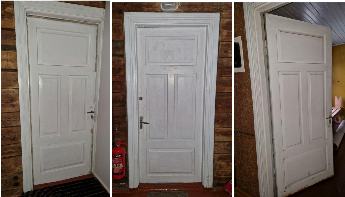
Fotod 83-85. Ühepoolne originaal tahvelluks (SU-1). 03.2024. Allikas: autor.
