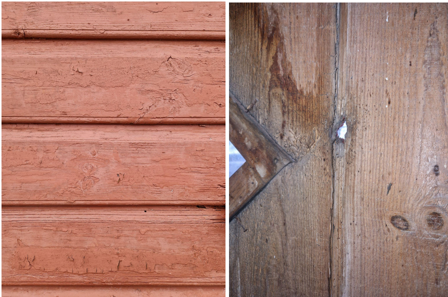
Foto 25. Horisontaalne punaseks värvitud fassaadi laudis. Foto 26. Pööningu vertikaalne välislaudis. 03.2024. Allikas: autor.
