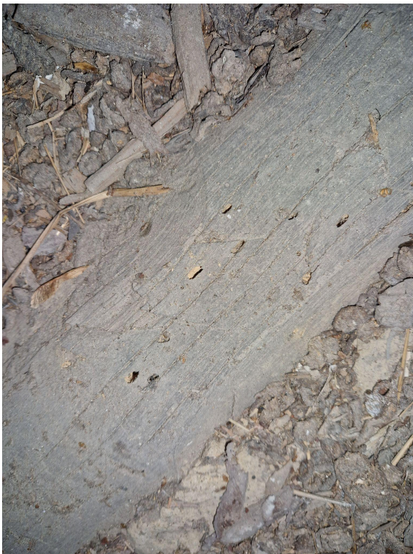
Foto 82. Vahelae talas sikkude lennuavad. 03.2024. Allikas: autor.
