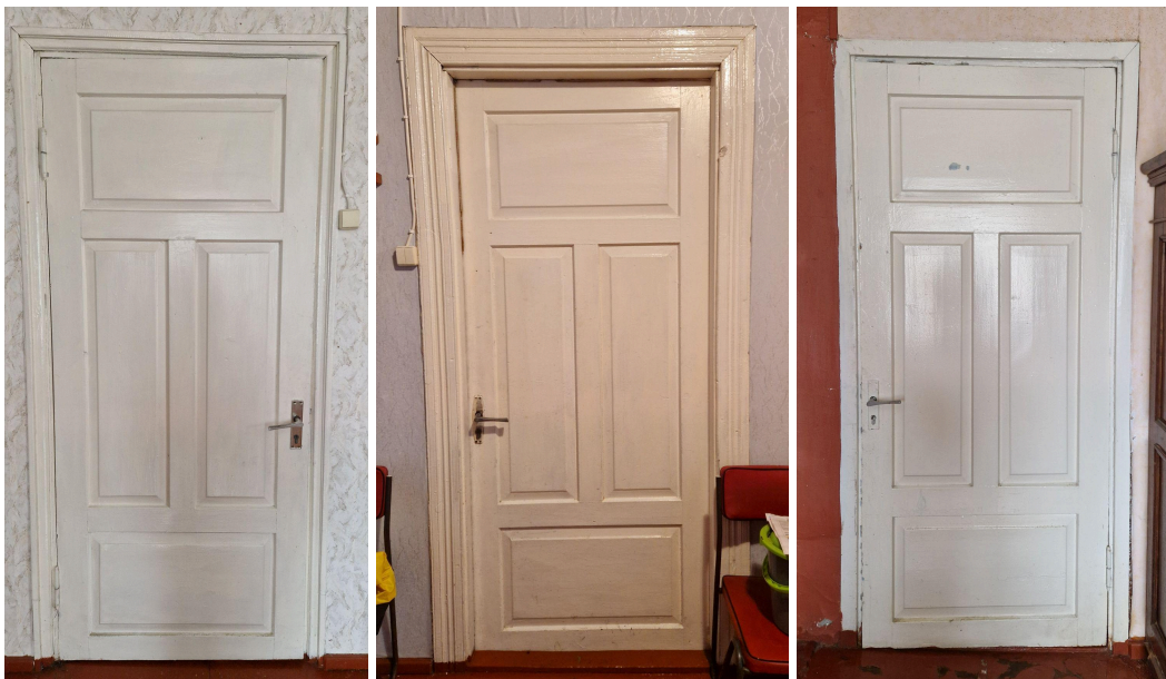
Fotod 83-85. Ühepoolne originaal tahvelluks (SU-1). 03.2024. Allikas: autor.
