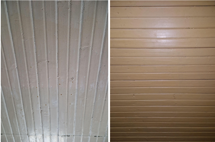
Fotod 78 ja 79. Värvitud lae laudis siseviimistluses. 03.2024. Allikas: autor.
