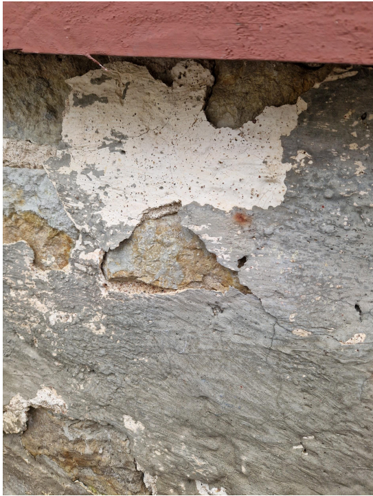
Foto 21. Soklist pudisev krohv. Foto 22. Pääs põranda alla. 03.2024. Allikas: autor.
