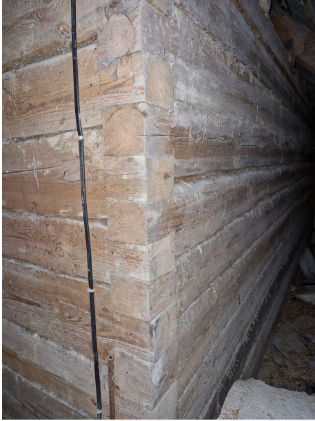
Foto 66. 2. korruse palgi tappliited. 03.2024. Allikas: autor.
