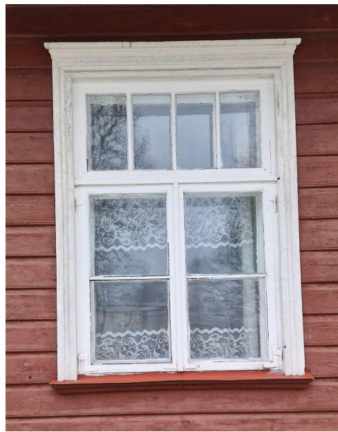
Foto 44. Lääne külje originaal topeltaken (A-2B). Foto 45. Lääne külje originaal topeltaken (A-2). 03.2024. Allikas: autor.
