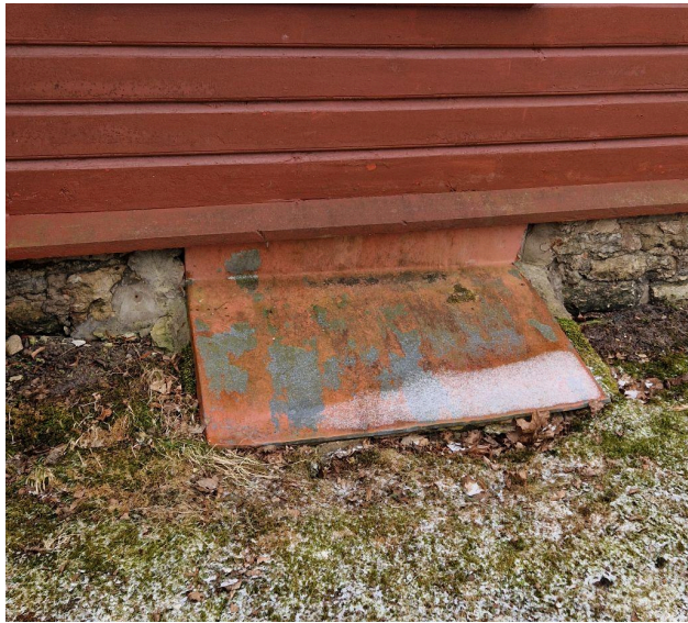
Foto 21. Soklist pudisev krohv. Foto 22. Pääs põranda alla. 03.2024. Allikas: autor.
