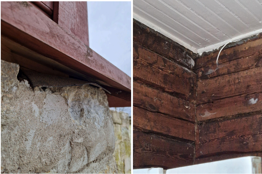
Foto 27. Veranda välisseina ja sokli sõlm. Foto 28. Välisseina ja sisesena palkide liitumine. 03.2024. Allikas: autor.
