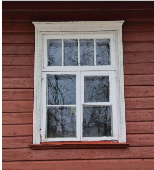
Foto 42. Lääne külje originaal topeltaken (A-2). Foto 43. Lõuna külje originaal topeltaken (A-2B) 03.2024. Allikas: autor.
