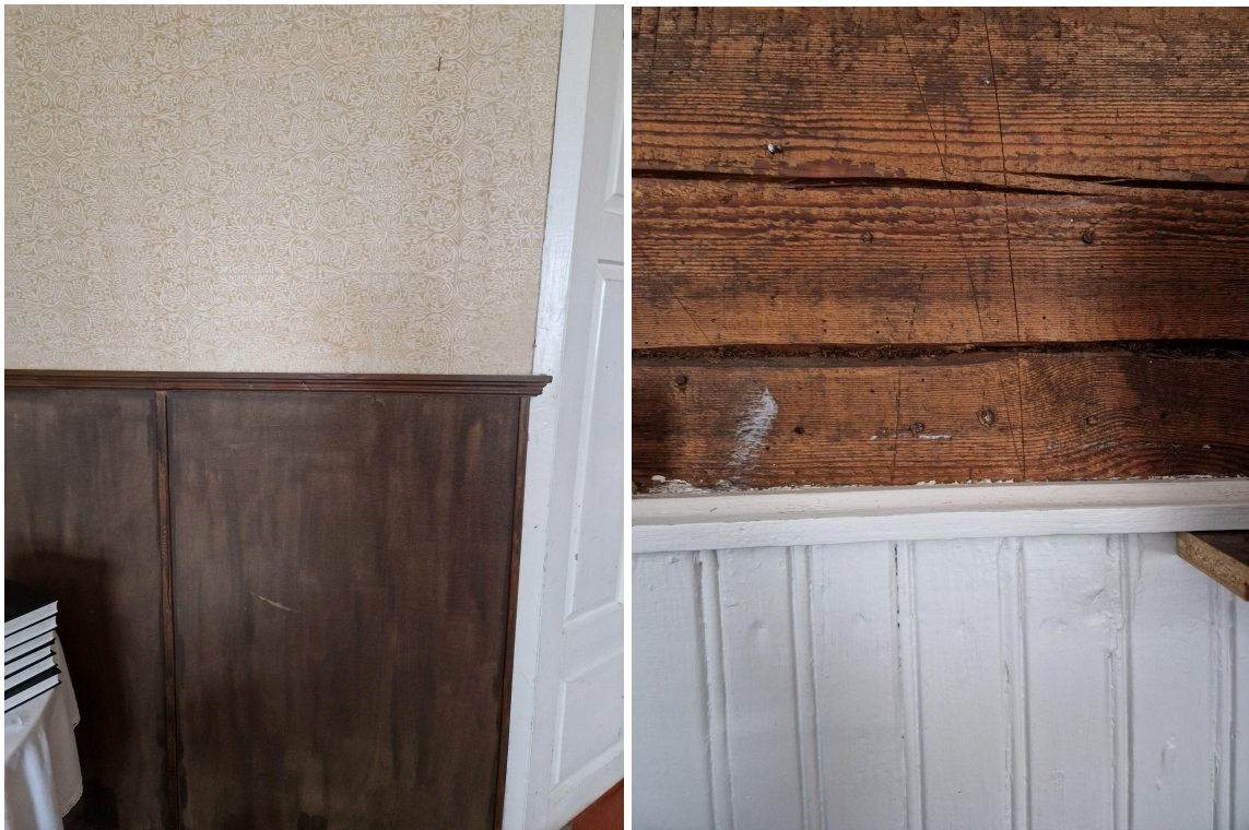
Foto 73. Siseviimistluses kasutatud vineer. Foto 74. Siseviimistluses kasutatud vertikaalset seelikut. 03.2024. Allikas: autor.
