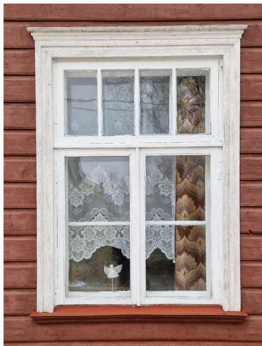
Foto 46. Lääne külje originaal topeltaken (A-2B). Foto 47. Ida külje originaal topeltaken (A-2) 03.2024. Allikas: autor.
