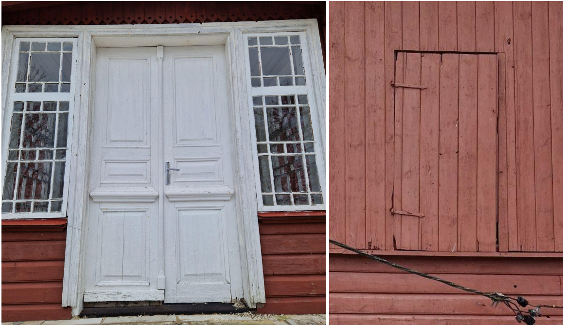
Foto 37. Lõuna külje kahepoolne tahveluks (VU-1). Foto 38. Ida külje pööningu lauduks (VU-2). 03.2024. Allikas: autor.
