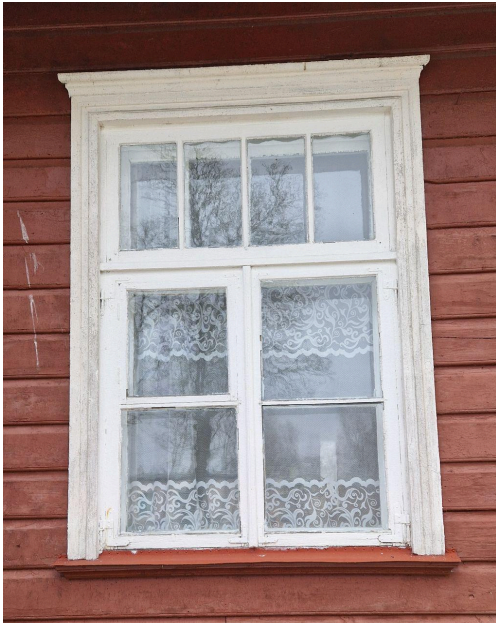
Foto 44. Lääne külje originaal topeltaken (A-2B). Foto 45. Lääne külje originaal topeltaken (A-2). 03.2024. Allikas: autor.
