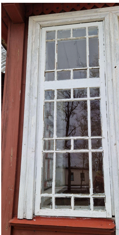
Fotod 53 ja 54. Lõuna külje veranda originaal aknad (A-5). 03.2024. Allikas: autor.
