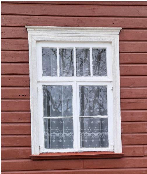
Foto 42. Lääne külje originaal topeltaken (A-2). Foto 43. Lõuna külje originaal topeltaken (A-2B) 03.2024. Allikas: autor.
