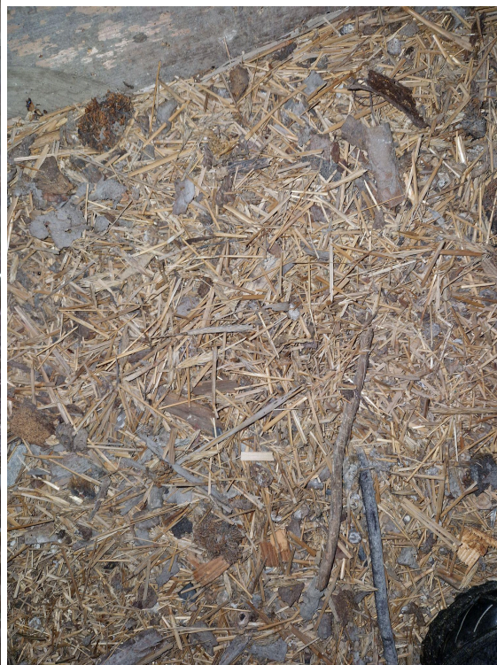
Foto 31. Katusekonstruktsioon. Foto 32. Võimalikud vana õlgkatuse õled pööningul. 03.2024. Allikas: autor.
