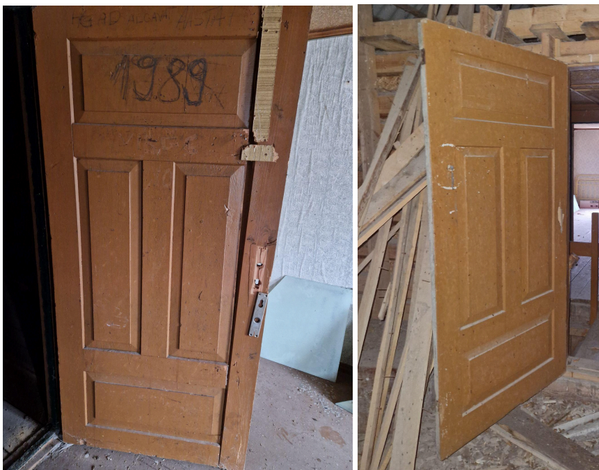
Fotod 97 ja 98. Ühepoolne tahveluks teisel korrusel (SU-1) 03.2024. Allikas: autor.
