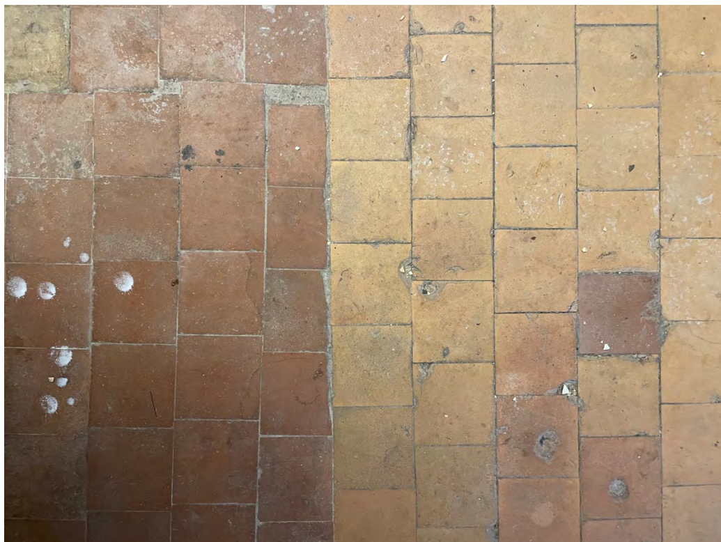
58. Küpsisevabriku põrandaplaadid. Autori foto.
