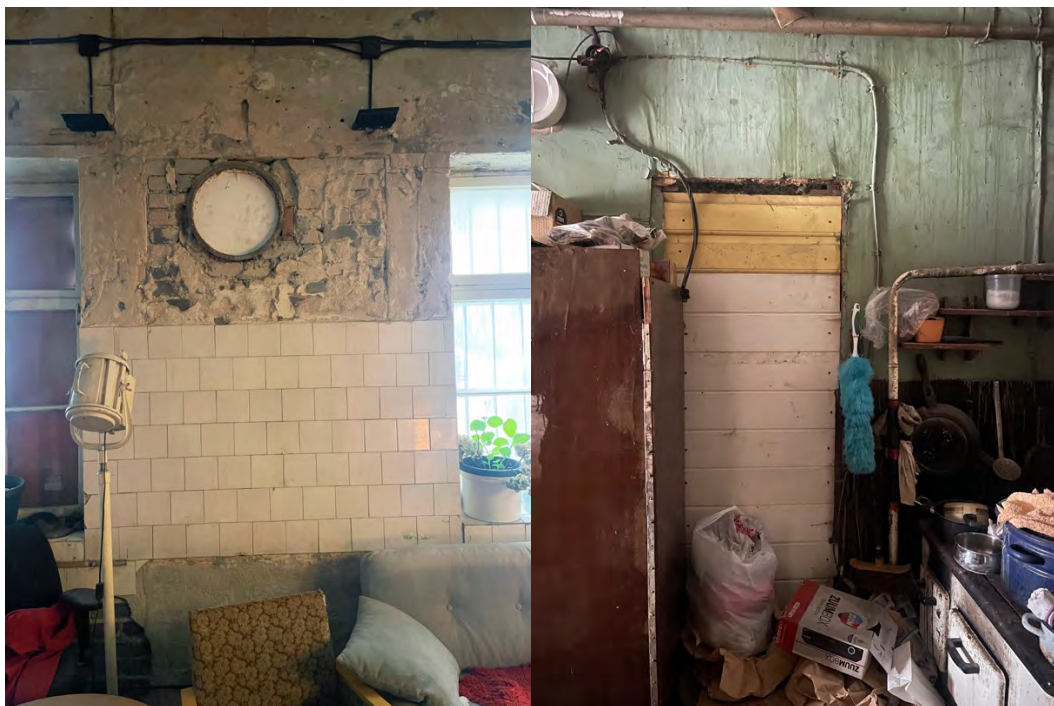
77. Kinni müüritud ukseava küpsisevabriku loodeseinas ja laudisega kinni löödud ukseava korterite 1 ja 1A vahel. Autori fotod.
