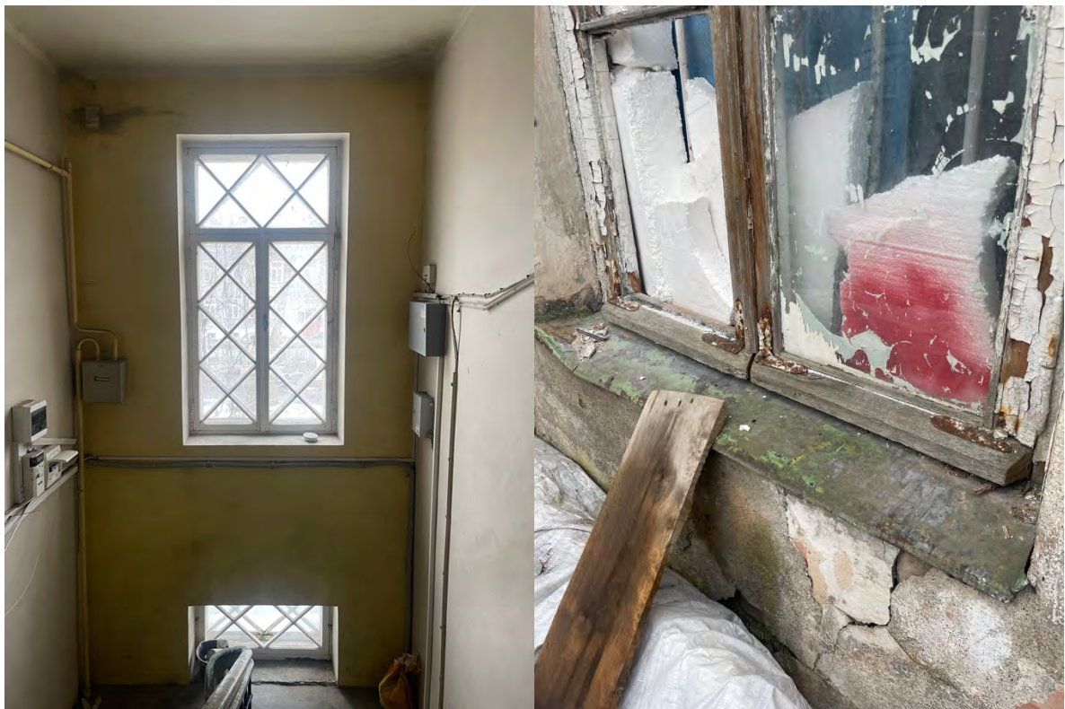
81. Trepikoja rombistikuga aknad seest poolt ja väga kehvast seisust küpsisevabriku aknad. Autori fotod.
