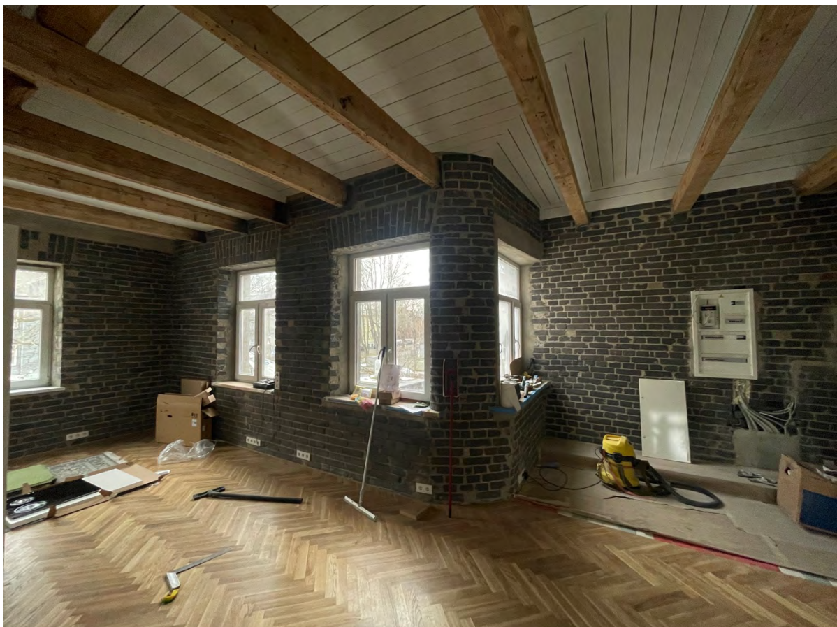
55. Renoveeritud ruum teisel korrusel. Puhastatud tuhttellis ja talad. Uus värvitud laelaudis. Autori foto.
