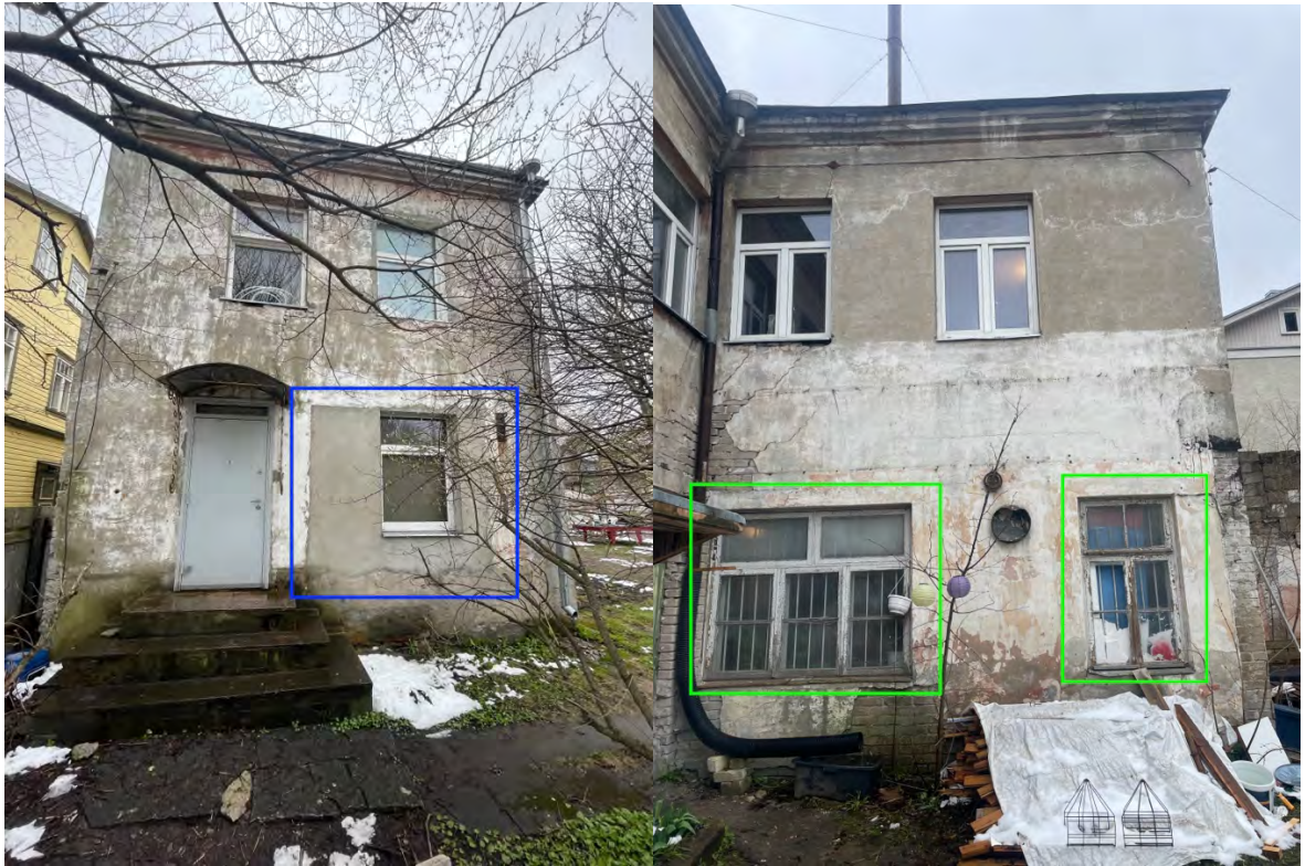
80. Korter 1A sissepääsu kõrval vahetatud ja kinnimüüritud ava (sinisega) ja küpsisevabriku vanimad aknad (rohelisega). Autori fotod.
