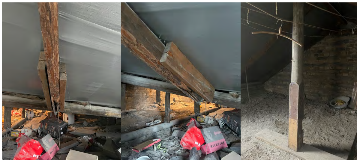
65. Toestatud sarikad, tahatud post. Autori fotod.
