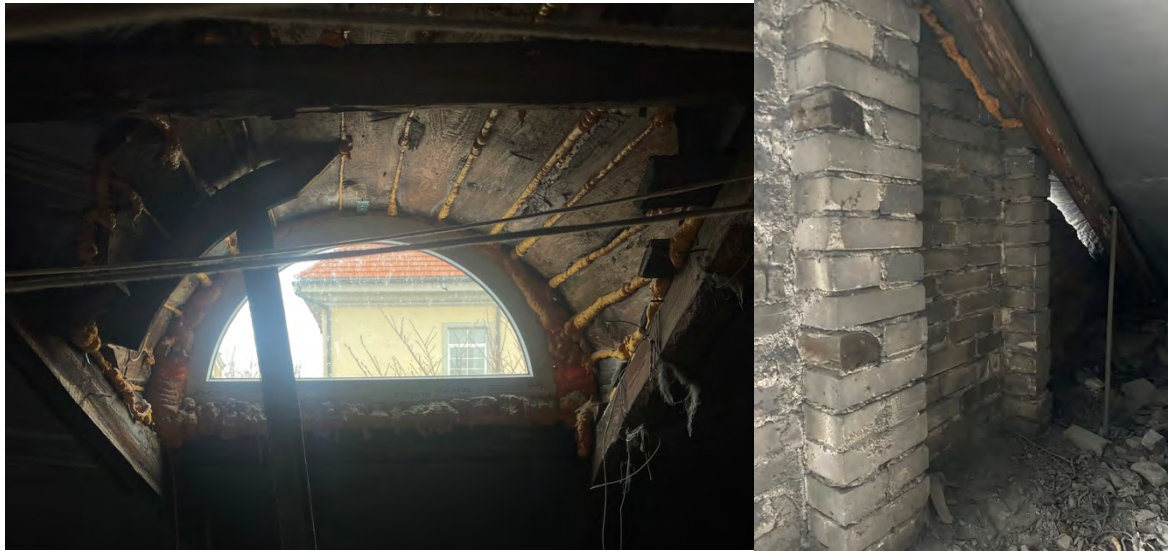
66. Vahetatud katuse plastaken ja korstnalõõr. Autori fotod.
