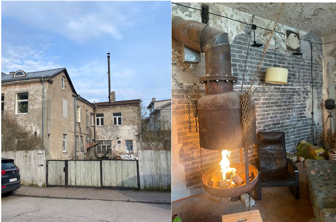
68. Küpsisvabriku korsten ja kaasaegne sepistatud tulease. Autori fotod.
