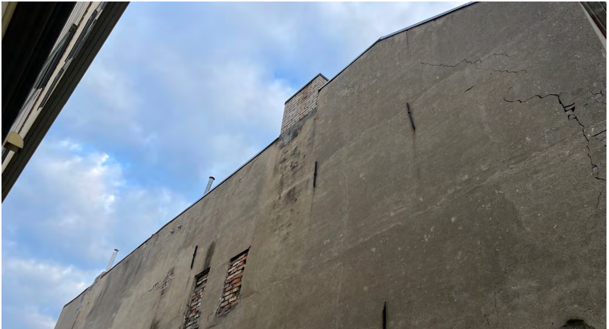
67. Korstnalõõrides ventilatsioonilõõrid ja korsten. Autori fotod.
