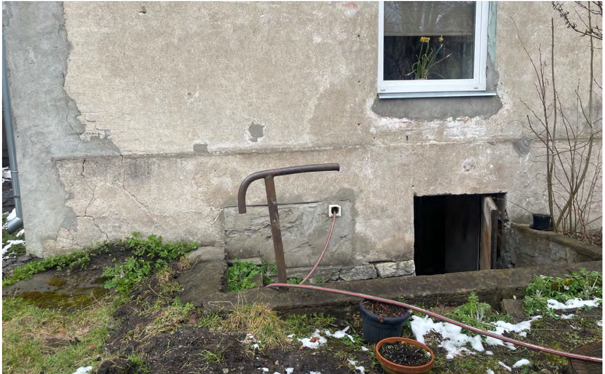
88. Keldri sissepääs: lagunenud astmed ja käsipuu. Autori fotod.
