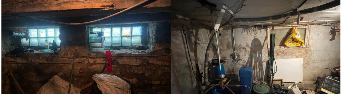
84. Keldri kinni müüritud aknad väljast ja keldrist. Autori fotod.
