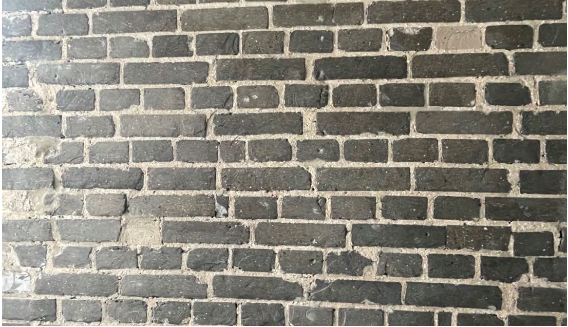
46. Puhastatud, lihvitud ja vesiklaasiga kaetud tuhttellis hoone renoveeritud siseruumides. Autori foto.
