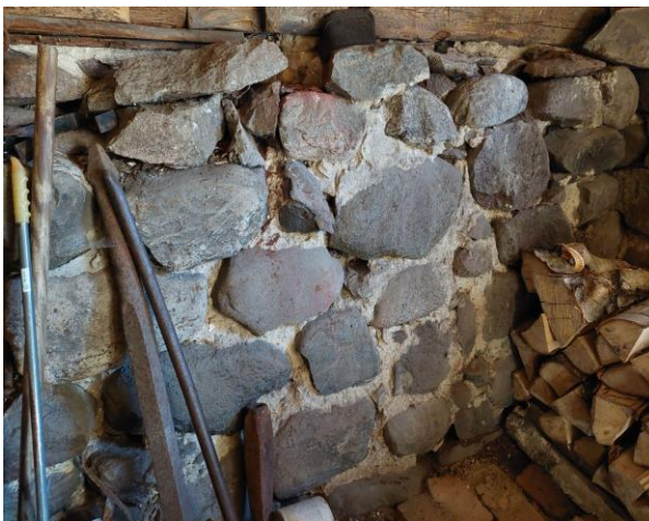
22. Maakivimüüritis kuurist seest vaadatuna. 23. Varasema juurdeehituse säilinud vundament. Autori fotod.
