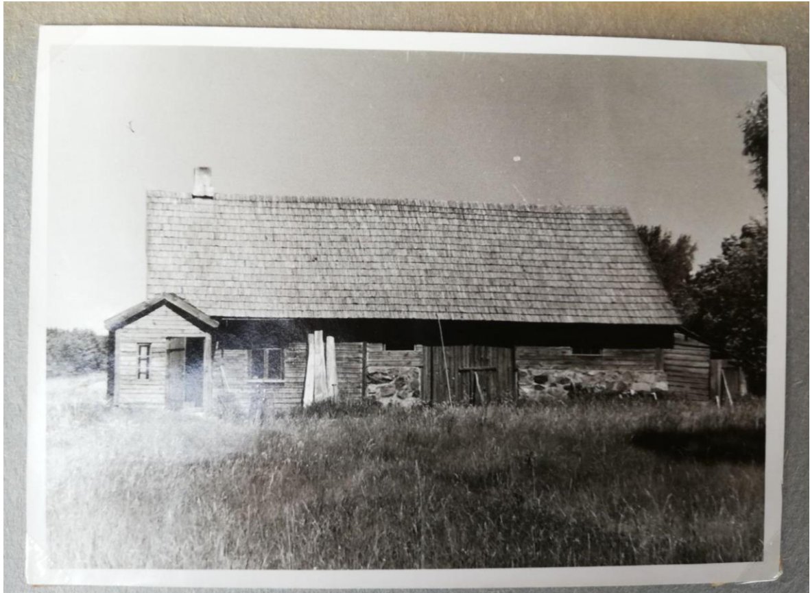
15. Foto elamu lõunafassaadist. Kinnistu omaniku foto.
