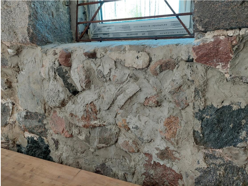
40. Tsementmördiga tehtud parandused interjööris. Autori foto.
