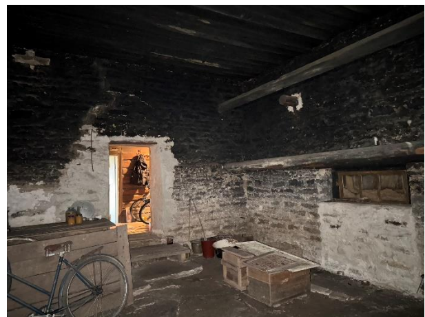
ill 12 Rehetuba. Fotel on näha kahekordsed aampalgid, kinnimüüritud toauks paremal ning "värsked" krohvijäljed ukseaval vasakul. Vasakul üleval nurgas on avaus, mille funktsioon jäi identifitseerimata.
