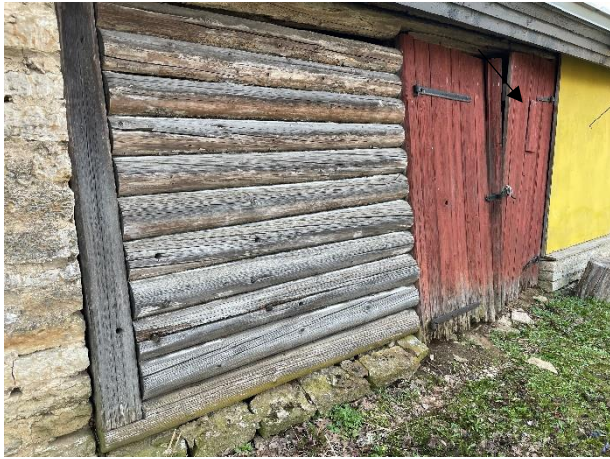
ill 25 Rehetoa esik, mille alt vundament vajub välja. Rõhtpalkidest sein on tugevalt kaldu. Nool osutab lauaga kaetud avausele väravas
