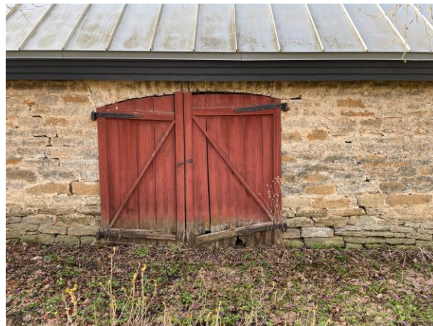
ill 37 Rehealuse uks lõunafassaadil
