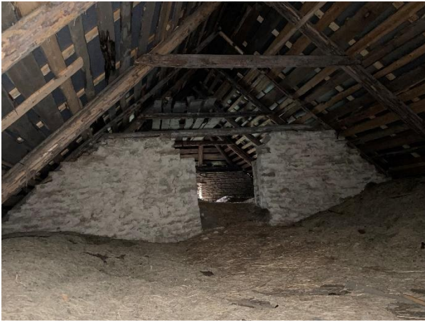
ill 15 Rehealuse endises otsaseinas säilinud luugi avaus, mille sillus on lammutatud.
