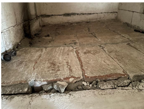
ill 39 Lesanka istumisalus, mis on tugevalt amortiseerunud ja ohtlikuks muutunud.
