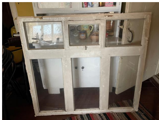
ill 33 Köögiakna talveaken, mis on üheraamne, kuid järgib köögiakna jaotust.
