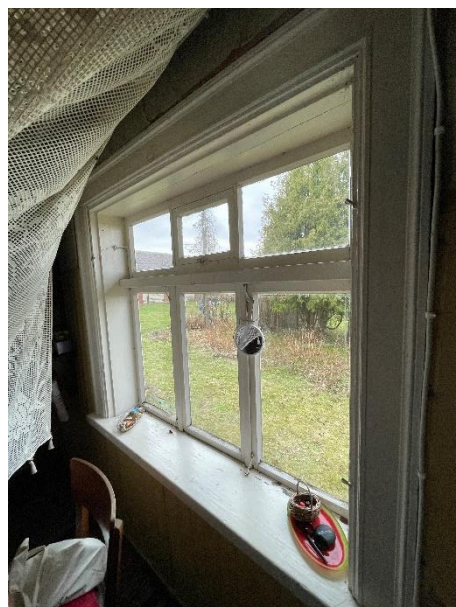
ill 34 Köögiaken siseruumist vaadatuna. Alumisel jaotusel hoiavad külmised raamid keskmist raami haakidega kinni.
