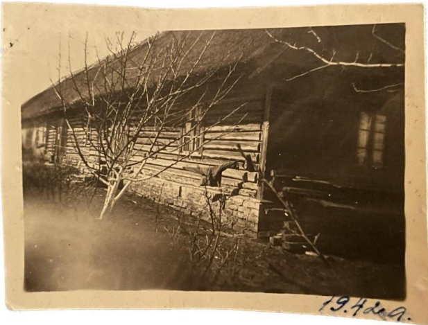
ill 6 Jõesaare talu lõunafassaad 1942.aastal. Valgustatud fassaadil puudub laudis, kuid nurkades on püstlauad kaitsmaks puhasnurkadega nurga seotist.
