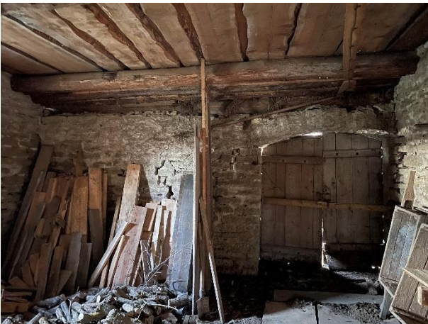
ill 21 3 kõrvuti palki on laotatud müüritise külgedele. Lauda põhjavärav, mis avaneb siseõuele, on kaarja päisega.
