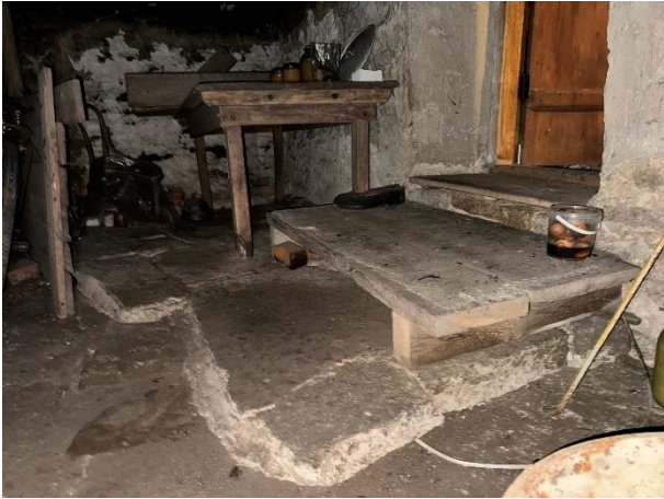
ill 13 Rehetoa põrand ja lammutatud ahju tõenäoline asukoht. Paeplaatidest põrandal on kuni 10 cm kõrgune aste.
