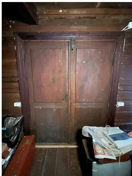
ill 18 I eeskoja tahveldistega kaheleheline uks, mis oli kunagi peauks. Uksel on säilinud metalldetailid. Uks on vaadeldav vaid siseruumist.
