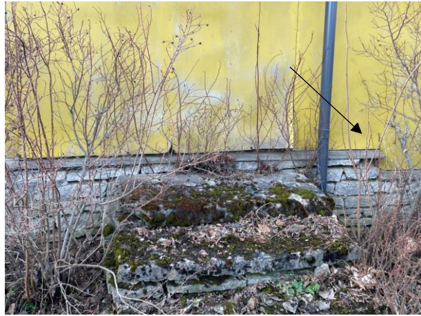
ill 16 Lõunafassadi poolne külg, kus on näha endise sissekäigu trepimade ning sokli kõrguste vahekorda (osutatud noolega)
