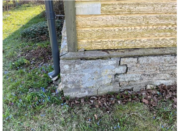
ill 24 Pragu nurgamüüritises. Nii laudiselt kui ka soklit kaitval veelaulal koorub värv avaldades alumise kihistuse või puidu.. Laudist on parandatud metall-lehega.
