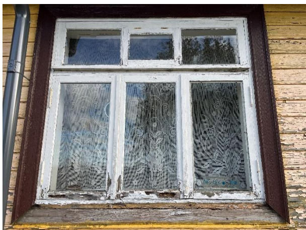
ill 32 Köögiaken väljast. Raami aluspuud on tugevalt kahjustada saanud ning neil puudub veenina, nagu oli 70ndate fotol. Kahjustus on mõjutanud ka alumist piirdelauda.
