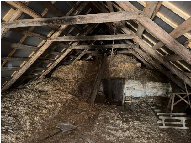
ill 30 Katusealune, kus on näha eenduvat rehetuba ning seismajäänud õlgesid.
