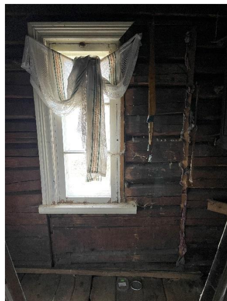
ill 17 Sahvri 3-ruudustikuga aken, mille küljelt on näha endise avause piirjooni.
