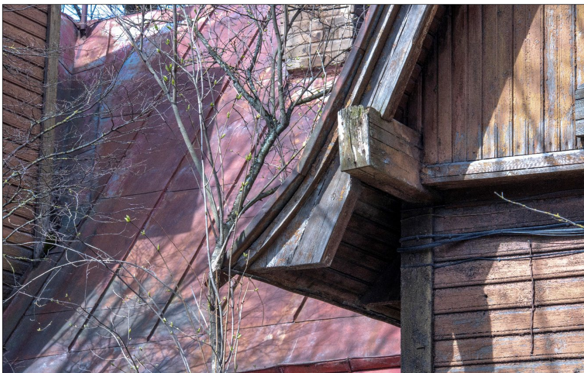
Foto 31 – puu on kasvanud katusele liiga lähedale ja vajub selle peale
