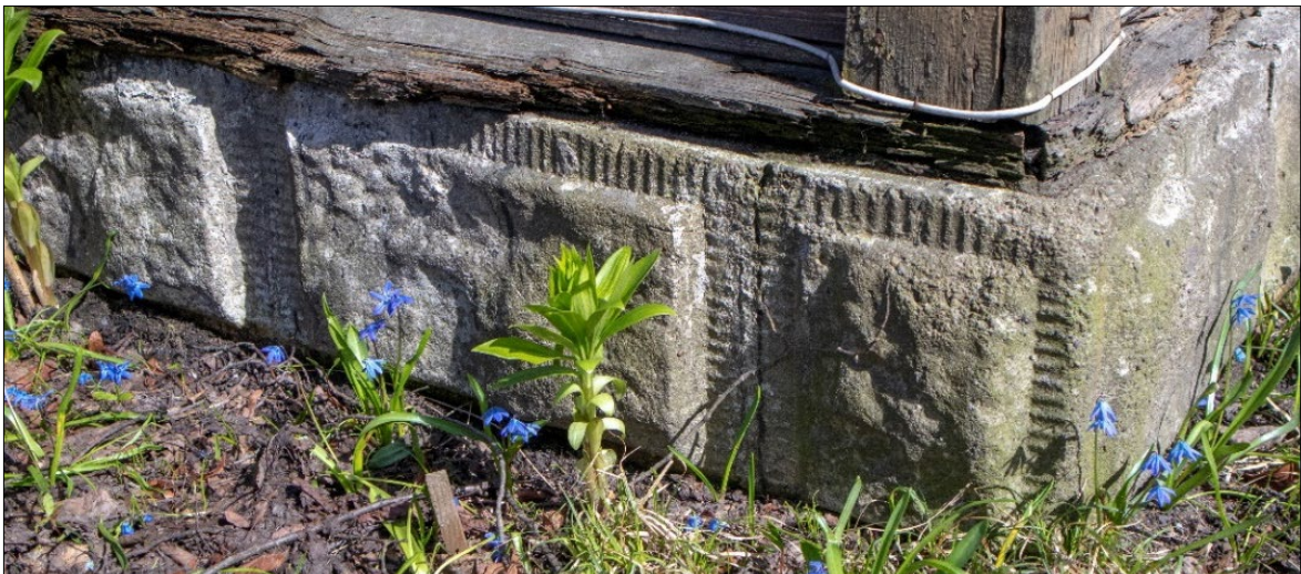
Foto 10 – põneva kujundusega soklikivid paiknevad tihedalt üksteise kõrval
