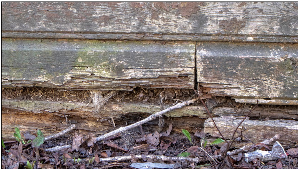
Foto 51 - soklita majaosa alumised lauad on väga halvas seisus
