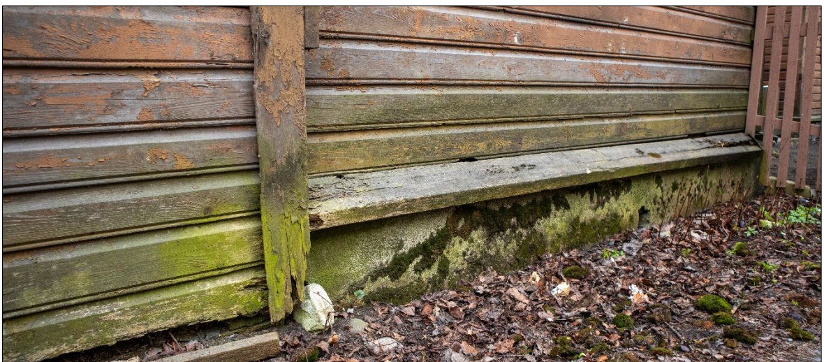
Foto 26 – uue hoonemahu sokkel on kaetud samblaga
