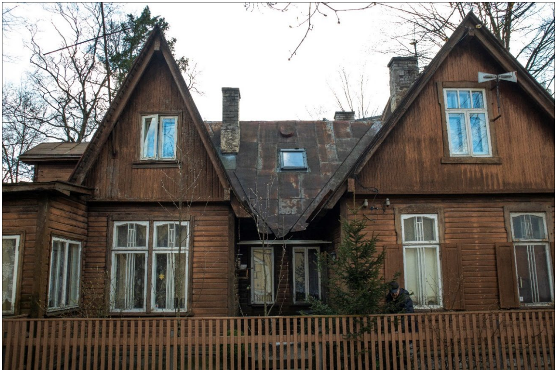
Foto 46 - vaade maja tagant, näha on katusekorruse uued aknad
