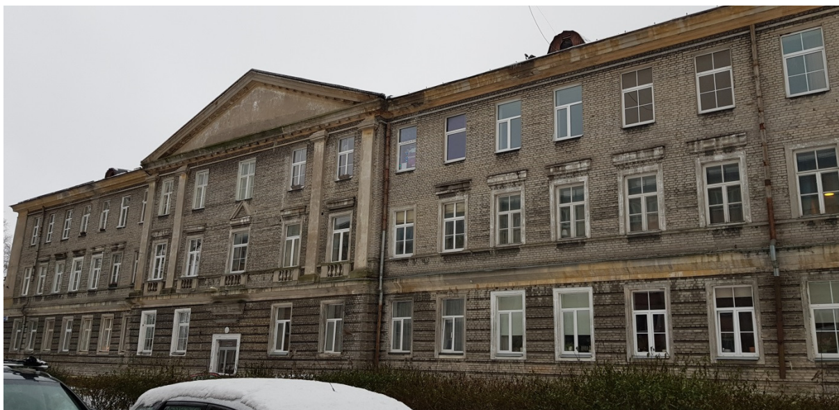
Fotol keskmises reas paremalt esimesed viis akent on kahekordse raamiga puitaknad (ehitusjärgsed aknad). 29.12.2023. K.Kaldam
