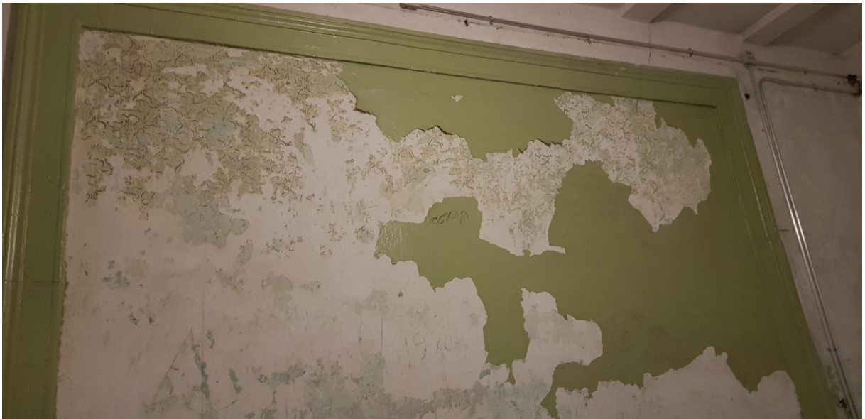
Fotol trafarettmaalingud stukkraamis keskmises trepikojas. 08.11.2023. K.Kaldam
