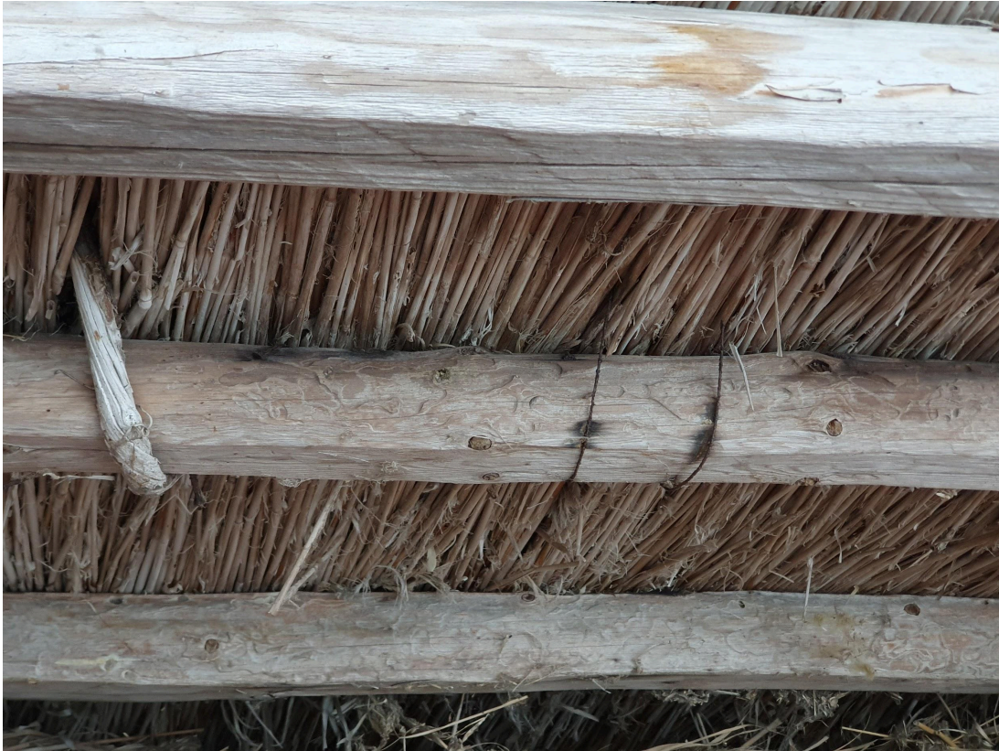
Illustratsioon 11 Roogkatuse ja vitstest ning traatidest roovitused. Foto autor: Cäroly Anton, november 2023.
