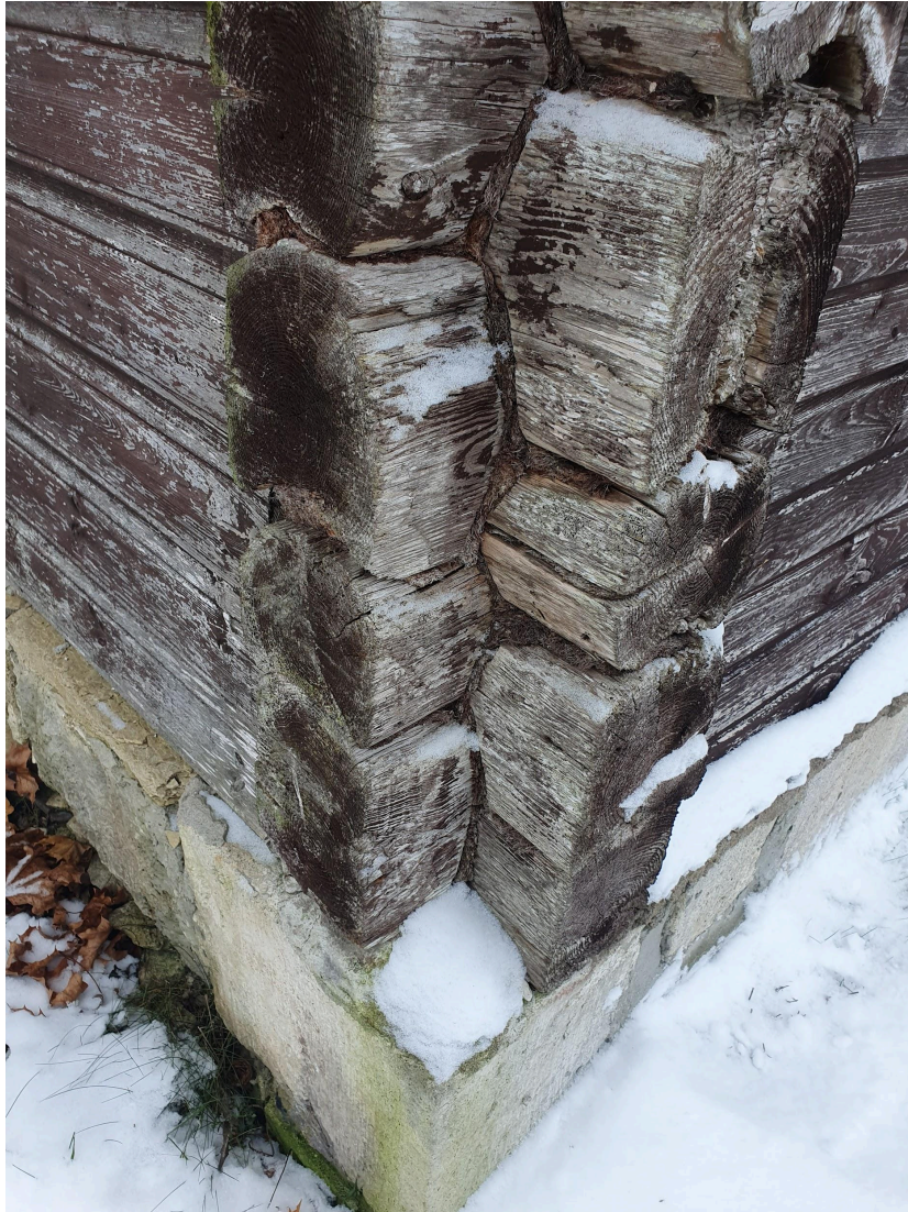
Illustratsioon 8 Hoone koerakaeltapid ja osa vundamendist. Foto autor: Cäroly Anton, november 2023.
