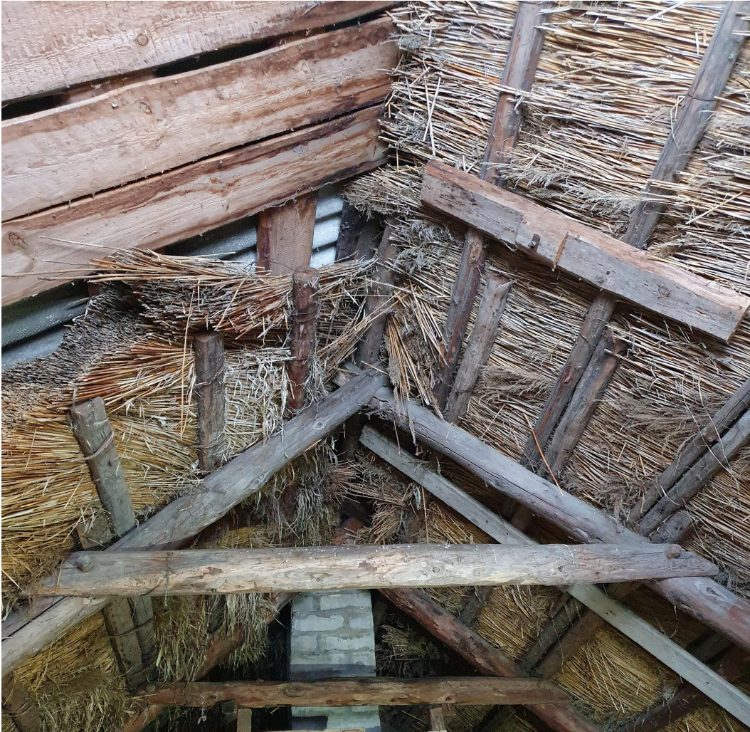
Illustratsioon 12 Kelpkatuse väljaehitatud katusealune nurk ning nähtavad pilliroo äralõikamise nurgad. Foto autor: Cäroly Anton, november 2023.
