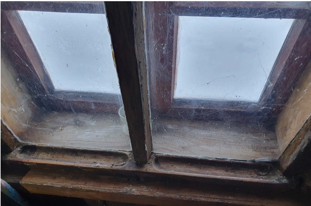
Illustratsioonid 16 ja 17 Põhjaseina siseaknad koos oma eriliste “veerennidega”. Näha on ka akende sinist tooni värvi fragmendid. Foto autor: Cäroly Anton, , november 2023.
