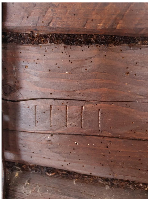
Illustratsioon 5 Veranda siseseina detailivaade. Näha on kuidas palgivahed on soojustatud samblaga. Foto autor: Cäroly Anton, november 2023.
