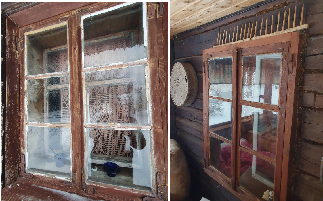
Illustratsioonid 15 ja 16 Kititud 6-ruudulised puitaknad. Vasakul hoone tagafassaad ja paremal veranda sisemine aken. Fotode autor: Cäroly Anton, november 2023.
