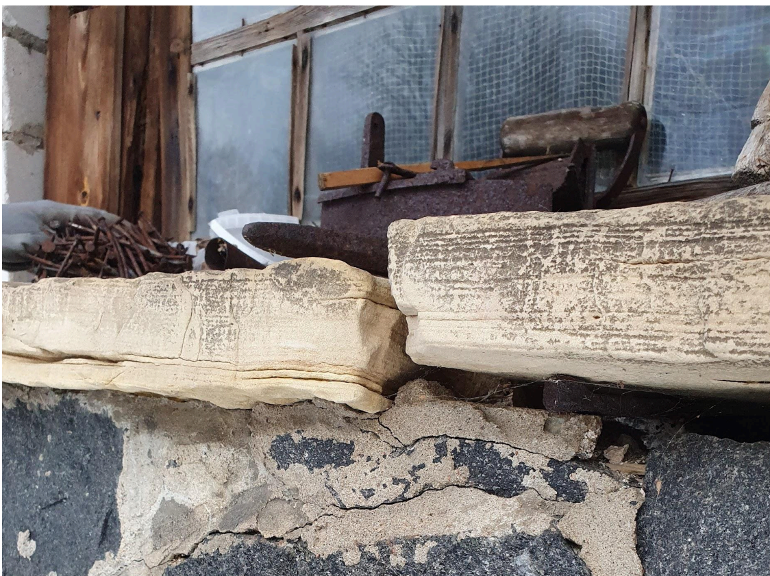
Illustratsioon 21 Ajahambast pragunenud ning osaliselt parandatud laudaosa müüripealne. Foto autor: Cäroly Anton, november 2023.
