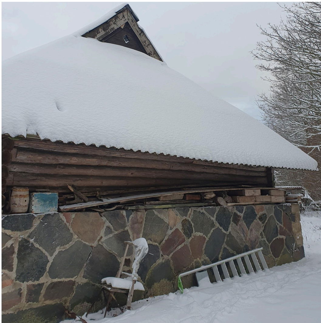
Illustratsioon 14 Muhu stiilis laudaosa kivimüür (hoone idapoolne külg). Foto autor: Cäroly Anton, november 2023.
