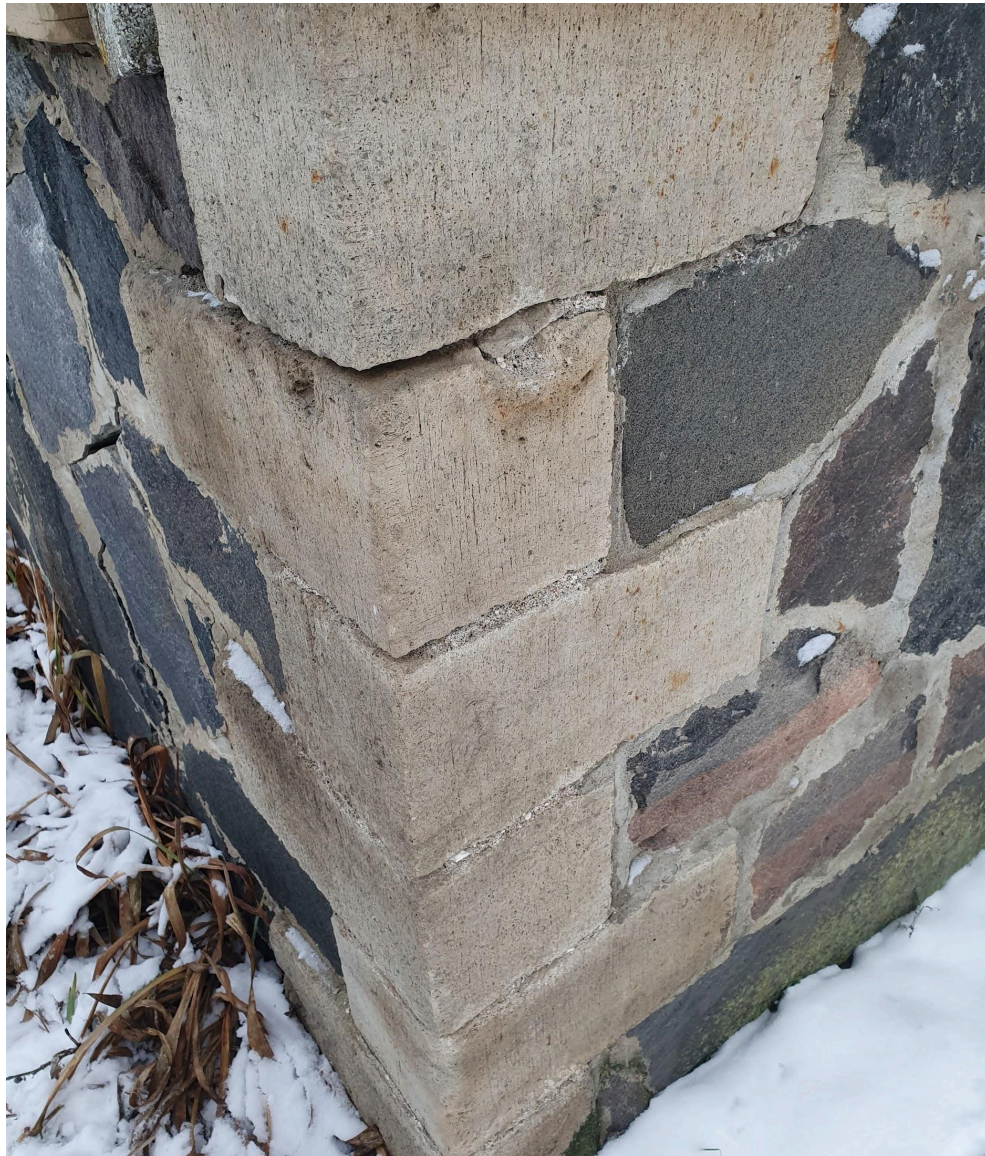
Illustratsioon 18 Muhu stiilis laudaosa nurgakett ja nähtavad vuugivahed, mida on hiljem ka täidetud.
