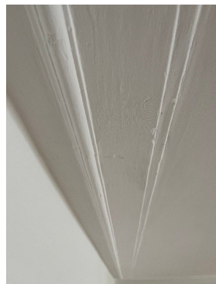
46. Stukk-karniisid peale kipsplaadi ja puitkarkassi eemaldamist. Laes on nähtav ka vana kriitvärviikiht. (Autori foto 2021) / 47. Hästi säilinud stukk-karniisi profiil. (Autori foto 2024)
