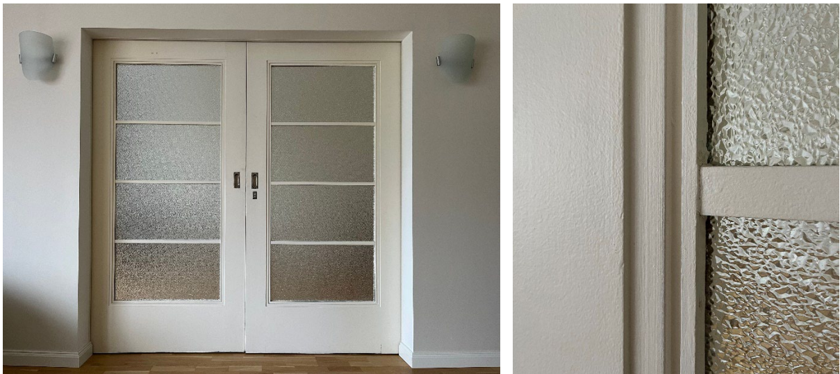
40. Seina seest remonttööde käigus välja ilmunud lükanduks (Autori foto 2024) 41. Ukse detail (Autori foto 2024)
