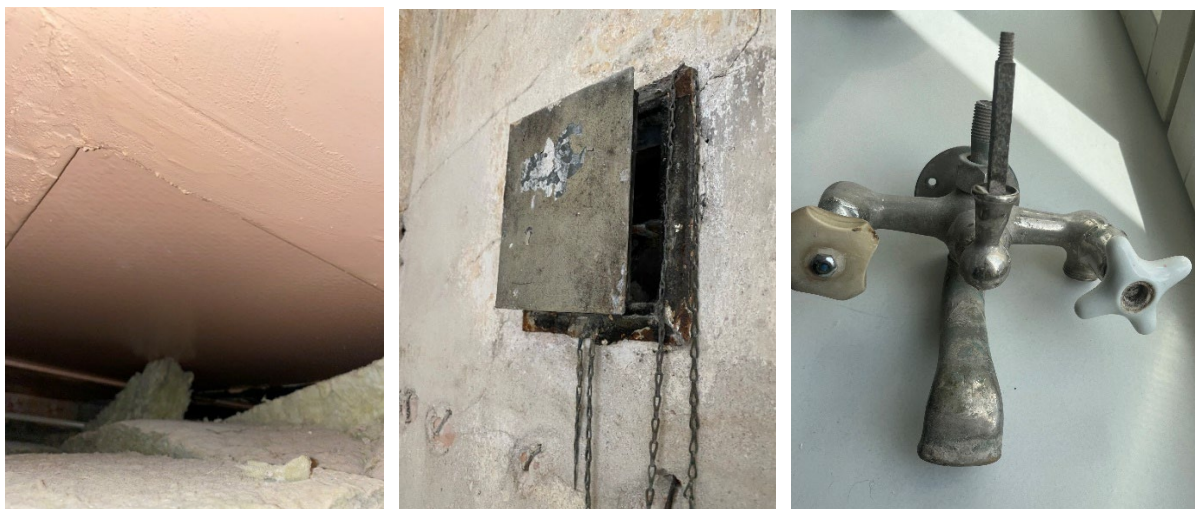
61. Kinniehitatud katuseaken (Autori foto 2021) / 62. Ventilatsiooniklapp (Autori foto 2021) / 63. Segisti (Autori foto 2023)
