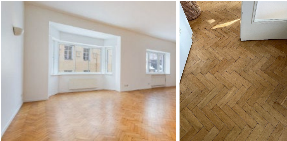
42. Ajalooline kalasabaparkett erkeriga elutoas, mis on kokkuehitatud kõrvaltoaga. (Foto: Kinnisvaraportaali KV.ee) / 43. Ukseavades on lähemal vaatlusel kasutatud asendatud parketilippe (Autori foto 2024)
