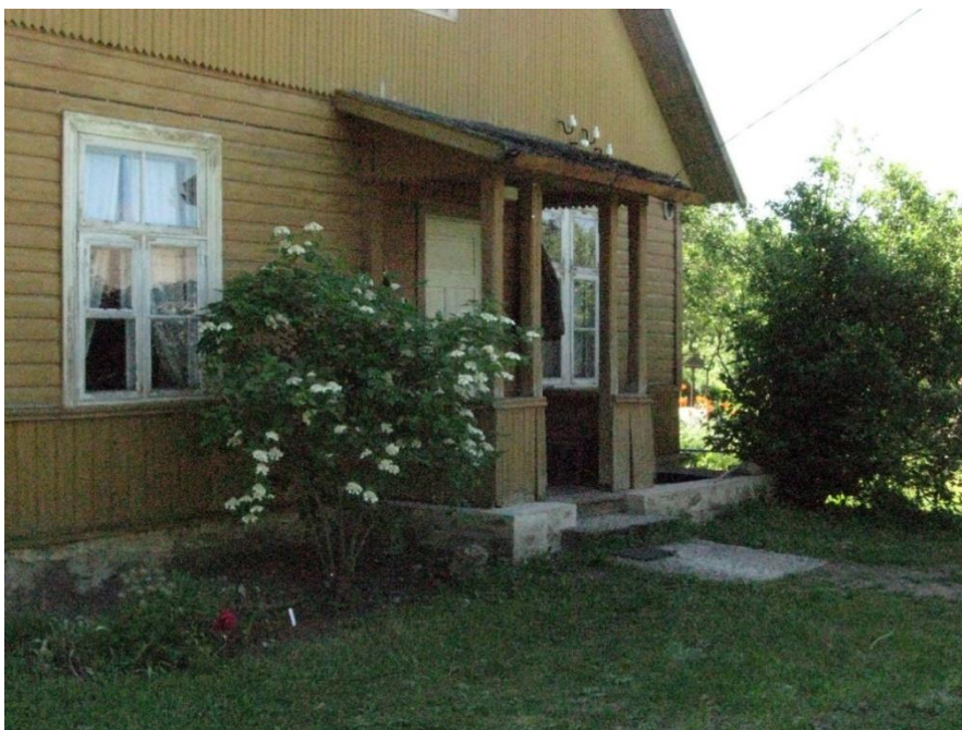
Foto nr 5. Vana eeskoda, mis viib taluhoovi. Uue koja ja vetsu vundament on juba valatud. Pildil näha trepi ees olev suur paeplaat. (Perekond Nõmmik erakogu)
