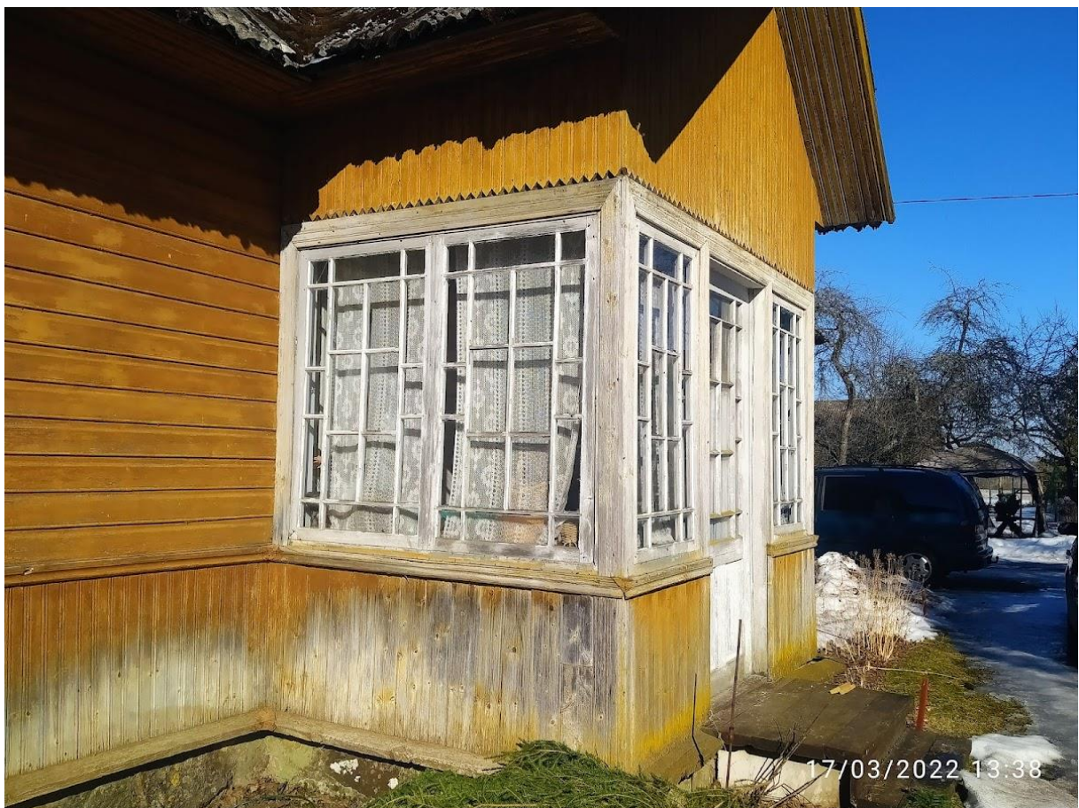
Foto nr 15. Liiva talu eluhoone voodrilaud enne eemaldamist. (Perekond Nõmmik erakogu)
