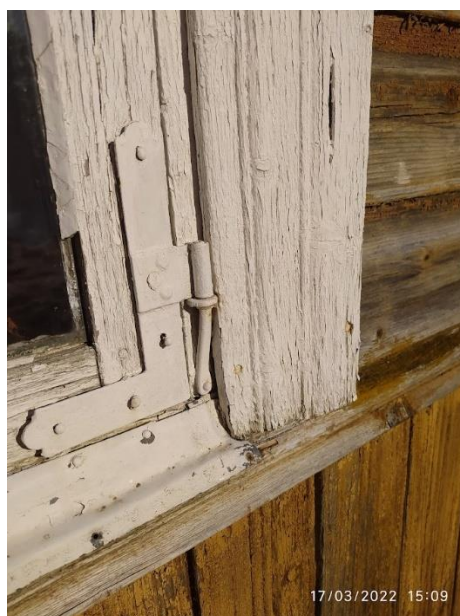
Foto nr 18. Akna nurk hing ja piirdelaua profiil. (Perekond Nõmmik erakogu)
