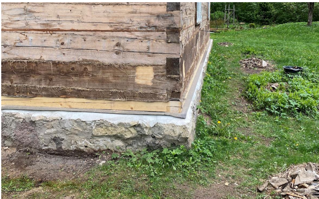
Foto nr 7. Liiva talu elumaja vundament, mille nurk on laotud paekividest ja tasandus tehtud lubimört padjaga. (Perekond Nõmmik erakogu)
