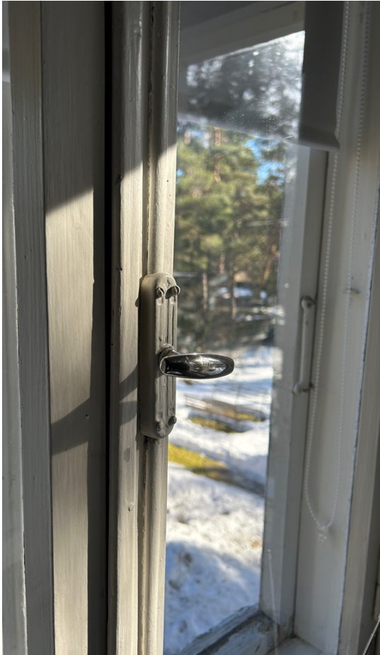
44. algupäraselt säilinud 1.korruse elutoa siseaken koos säilinud kreemooni ja haagiga. Foto: M. Kruus 2024.
