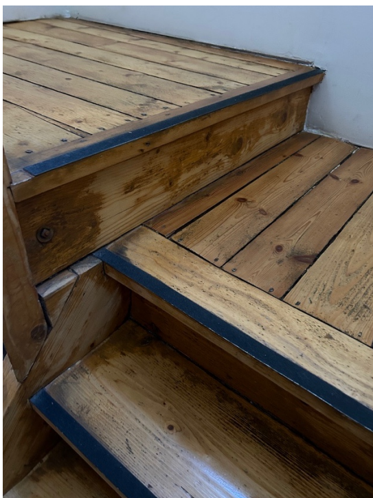
60. tänapäevases mõistes kokkumisohtlik ja ebamugav trepi mademe lahendus. Foto: M. Kruus 2024.
