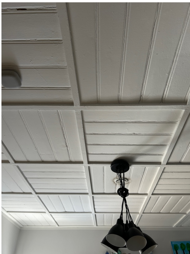
57. kassettlagi 2. korruse hoovi poolses nurga magamistoas. Foto: M.Kruus 2024.
