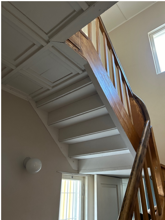
63, 64, 2.korrusele viiv trepp, säilinud kassetlagi trepi all. Fotod:M. Kruus 2024.
