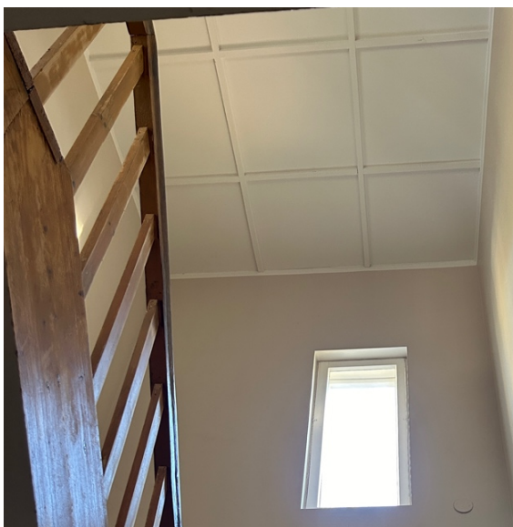
59. 2.korruse trepihalli vineerplaadiga kaetud lagi. Foto: M. Kruus 2024.
