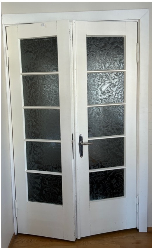
53. 1.korruse tubade vaheline jääklaasiga siseuks. ovaalne lukusilt, koonushinged, originaalne prosspulk, mis jaotab klaasi, küljeriiv ehk spingelett. tuuleliist on uus. Foto:M.Kruus 2024.
