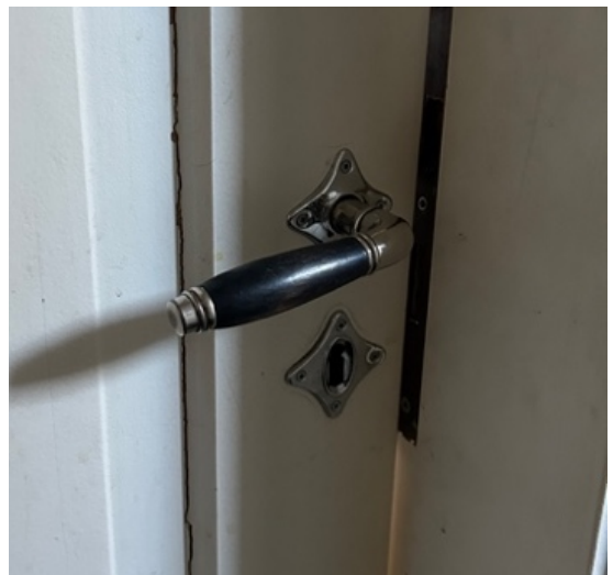
51. originaalsena säilinud puidust käepidemega ukselink. Foto: M. Kruus 2024.
