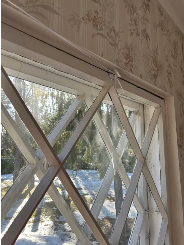
42. algupäraselt säilinud veranda sisemine aken. Näha ka algselt säilinud prosspulgad. Ülemine kinnitushaak ei ole arvatavasti algupärane. Foto: M. Kruus 2024.
