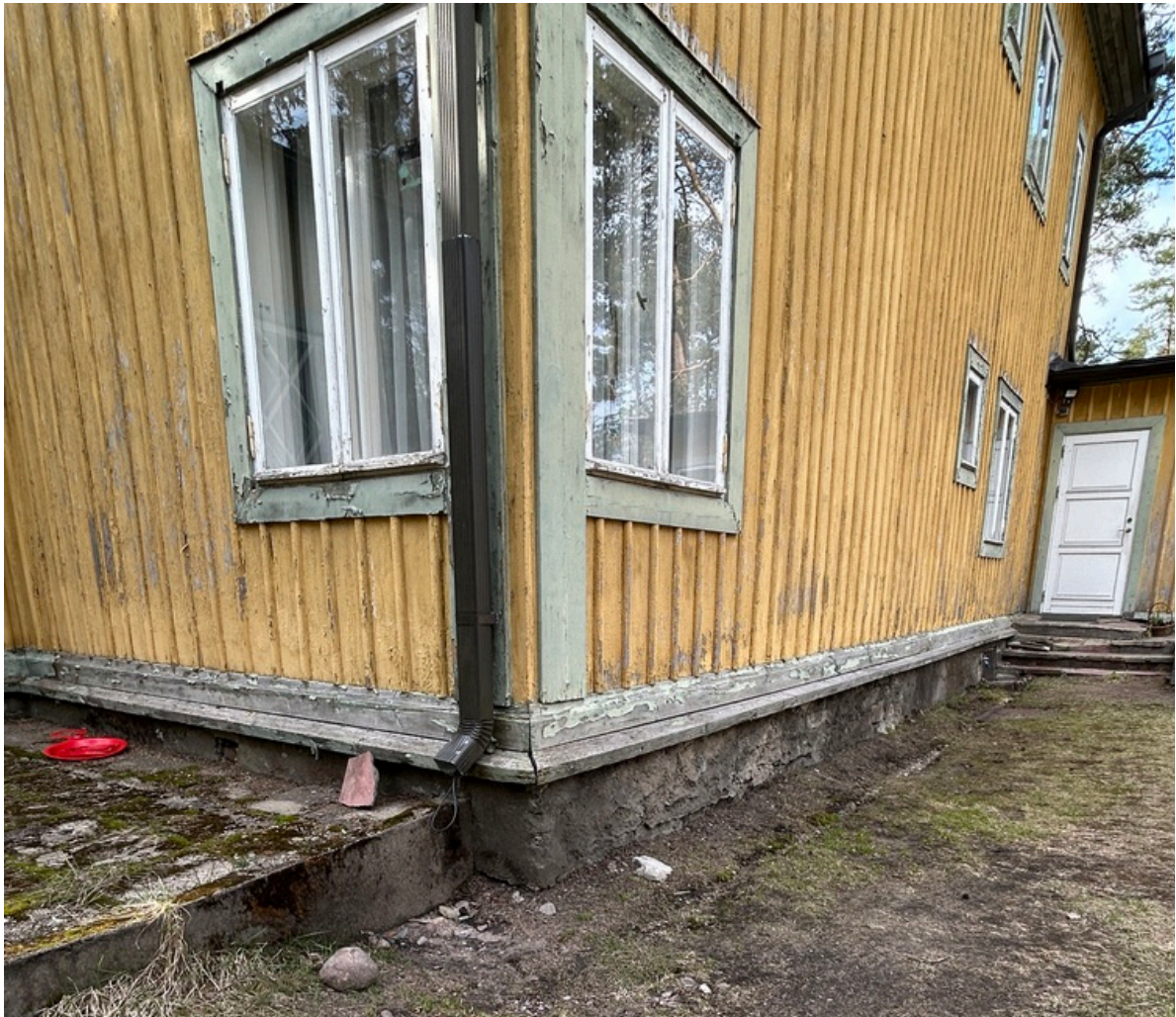
24.krohvitud hoovi poolne vundament ja alates 1962. aasta arhiivi dokumentidest nähaolev kiviplatidega kaetud terrass veranda ja maja nurgas basseini kõrval. Fotod: M. Kruus 2024.
