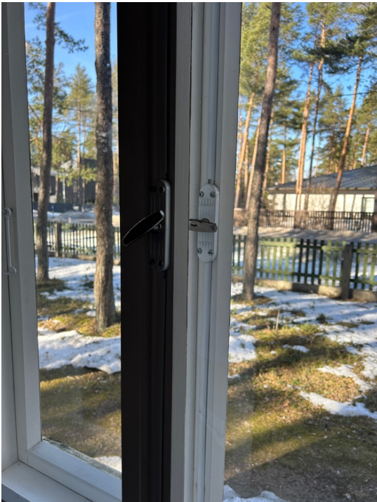
45. algupäraselt säilinud 1. korruse toa sise aken koos säilinud kreemoonidega. Foto: M. Kruus 2024.
