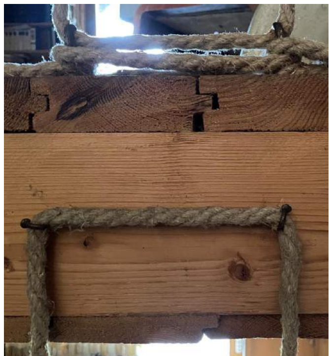
27: Trepi piirde kinnitused. Vaadeldavad on ka 30 mm paksused põrandalauad. Autori foto, aprill 2024.
