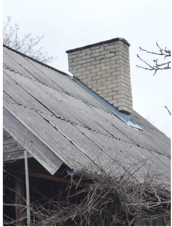
34: Sammaldunud ja kahjustunud harja kattelaud, viilu piirilauad. Autori foto, aprill 2024.
