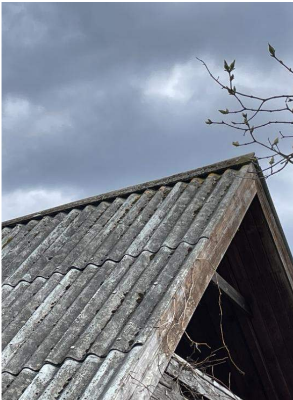
34: Sammaldunud ja kahjustunud harja kattelaud, viilu piirilauad. Autori foto, aprill 2024.
