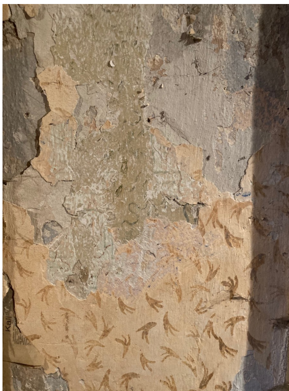
foto 5: keldri seinal paljanduvad rullimustrid
