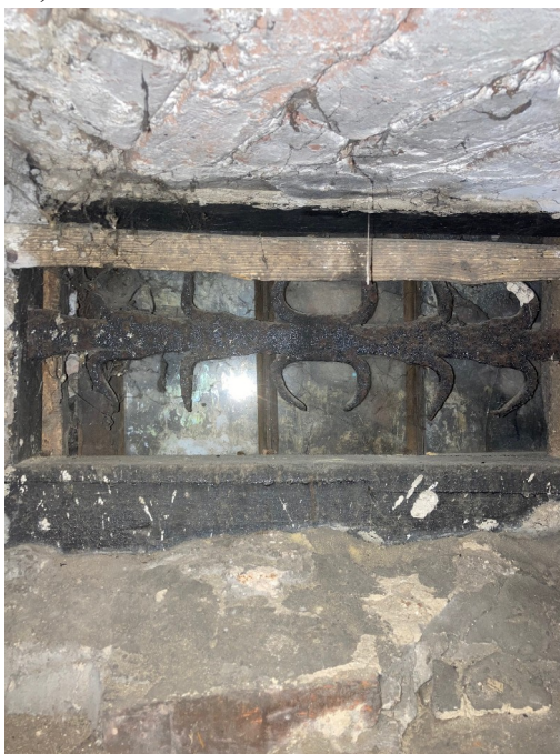
Foto 3: NE seinaga keldri aken koos sepistatud aknatrellidega
