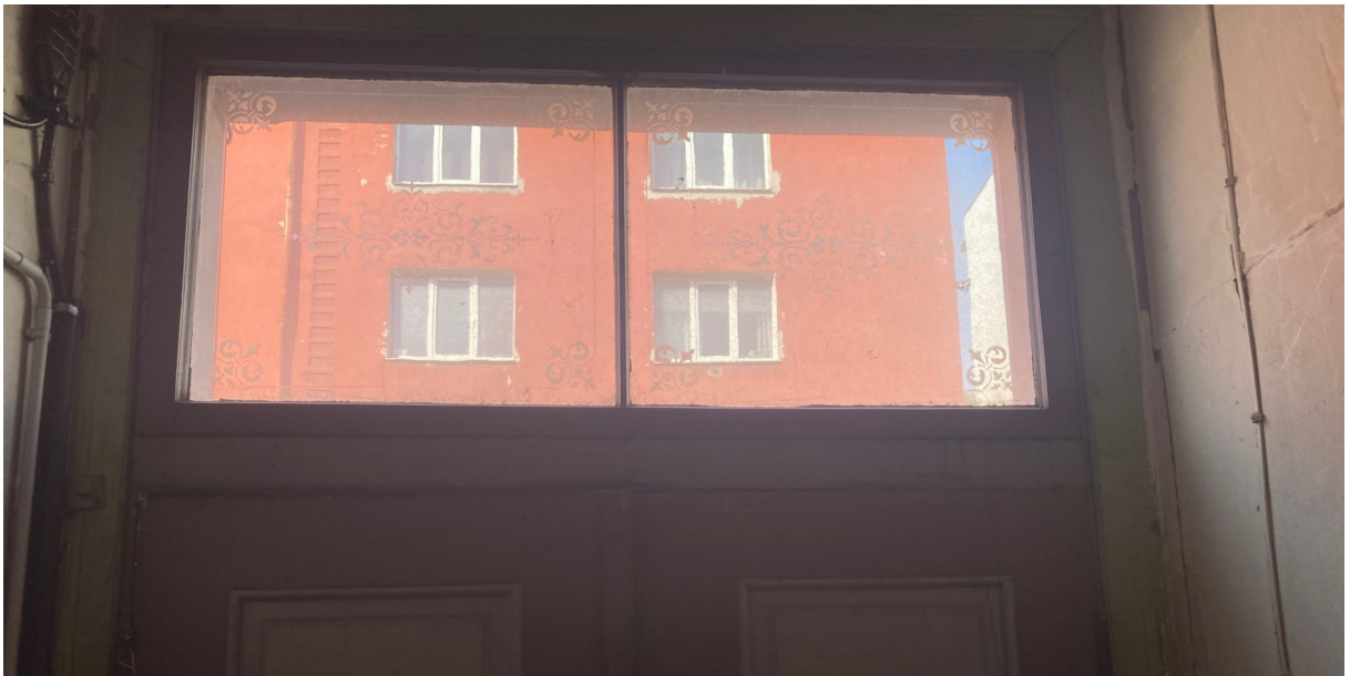
foto 11: Väliukse valgmik, kus klaasil on näha söövitatud mustrit
