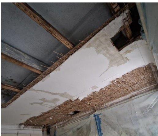
22. Aluslae lammutamine. Autori foto.
